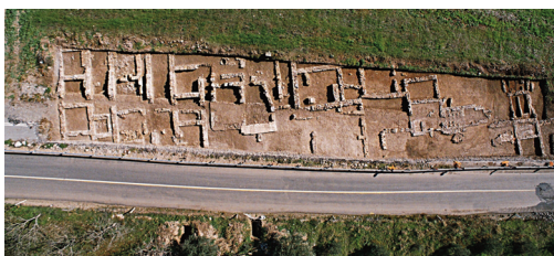
Εικ. 16. Καλαπόδι. Ερείπια κτηριακού συγκροτήματος.
