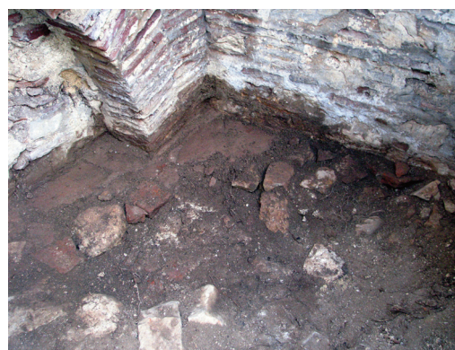
Εικ. 4. Δυτική πλευρά του κτηρίου Α.
