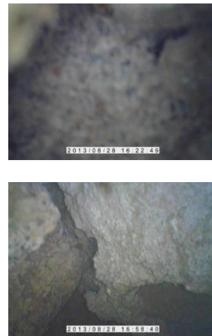
Εικ. 3.2 : Εσωτερική δομή τοίχου (ενδοσκοπική κάμερα)
