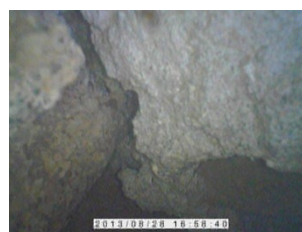
Εικ. 3.10 : Εσωτερική δομή τοίχου (ενδοσκοπική κάμερα)
