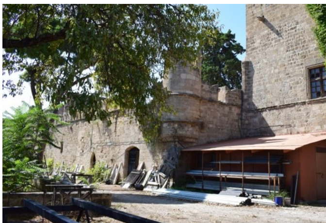
Εικ. 3.7 : Ανατολική όψη σιδηρουργείου
