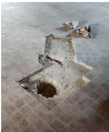
Εικ. 3.5 : Διερεύνηση επικάλυψης πατώματος ορόφου ξυουργείου
