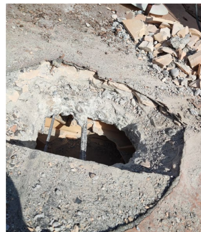
Εικ. 3.6 : Διερεύνηση επικάλυψης πατώματος δώματος ξυουργείου
