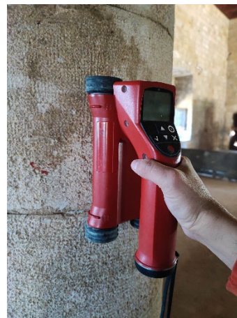
Εικ. 3.12 : Διερεύνηση τυχόν ύπαρξης ω.σ. εντός κυκλικού πεσσού ορόφου (ξύλουργείο)
