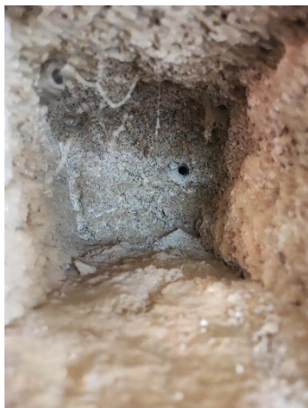
Εικ. 3.11 : Εσωτερική δομή ορθογωνικού πεσσού ισογείου (ξύλουργείο)
