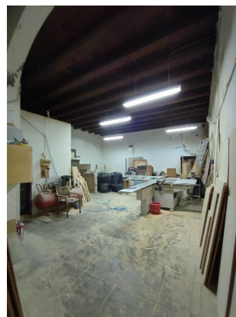
Εικ. 3.8 : Οροφή βορείου χώρου σιδηρουργείου
