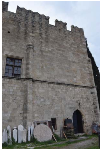
Εικόνα 12. Κτήριο Α, Ανατολική Όψη, άποψη βόρειας γωνίας (Ξ.Σιμου, 2024)
