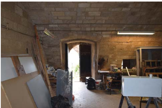
Εικόνα 15. Κτήριο Α, χώρος εισόδου Α.101, ανατολική θύρα Θ1.01
