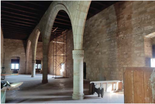
Εικόνα 22. Κτήριο Α, αίθουσα ορόφου Β.101
