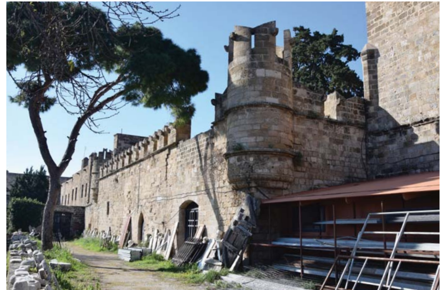
Εικόνα 36. Κτήριο Β, άποψη από τα βορειοανατολικά
