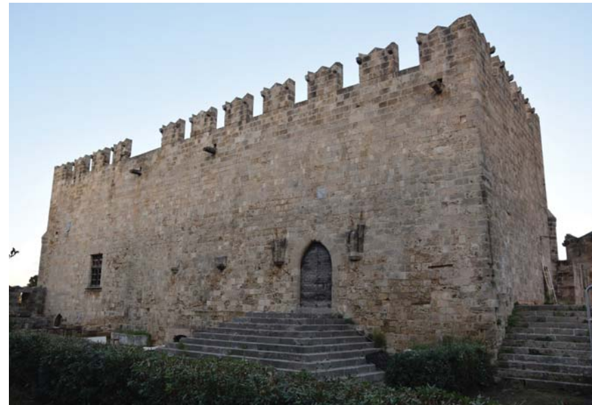
Εικόνα 14. Κτήριο Α, άποψη από τα νοτιοδυτικά, επικοινωνία μέσω κλίμακας με δώμα κτηρίου Β
