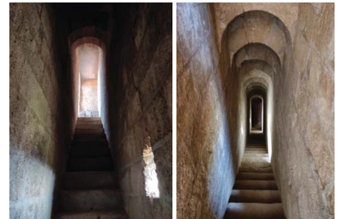
Εικόνα 27. Κτήριο Α, κλίμακα ανόδου από τη στάθμη του ορόφου προς στο δώμα, εγγεγραμμένη στο πάχος του ανατολικού τοίχου
