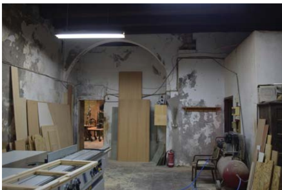
Εικόνα 45. Κτήριο Β, αίθουσα Β.101, σύνδεση με κτήριο Α.
