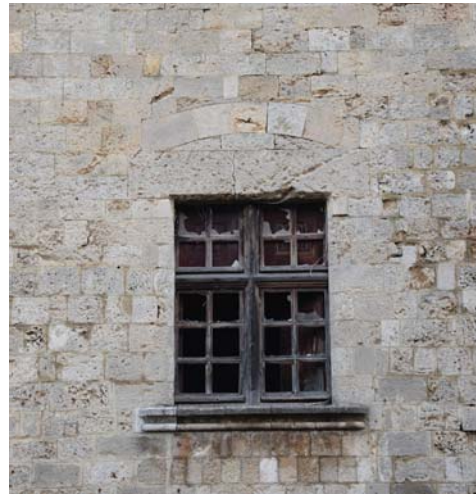
Εικόνα 62. Κτήριο Α, ρηγματώση πάνω από το Π.201
