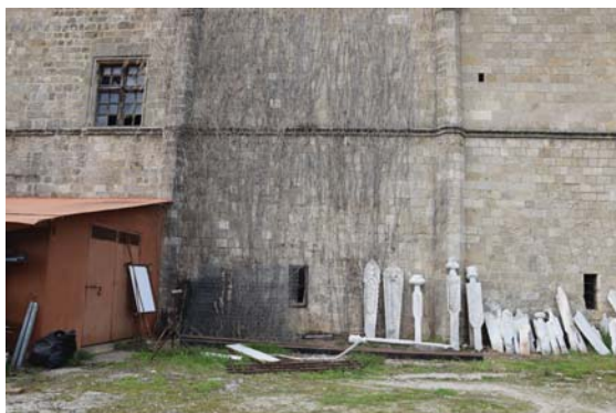
Εικόνα 78. Κτήριο Α, κάλυψη ανατολικής όψης από αναρριχητική βλάστηση
