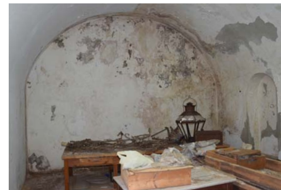
Εικόνα 51. Κτήριο Β, αίθουσα Β.104, νότιος τοίχος
