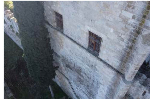
Εικόνα 10. Άποψη βόρειου τοίχου
