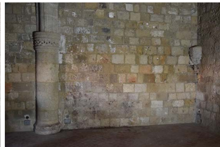
Εικόνα 34. Κτήριο Α, αίθουσα Α.201, σωζόμενο επίκρανο αρχικής ιπποτικής κατασκευής σταυροθαλίου στη ΝΔ γωνία
