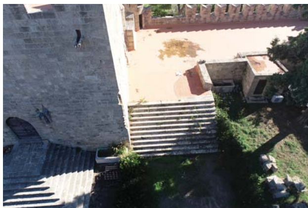
Εικόνα 43. Συμβολή κτηρίου Α και Β, άποψη από τα δυτικά
