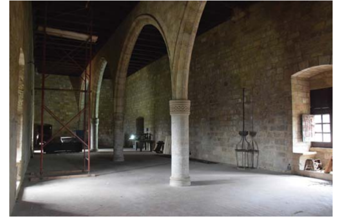
Εικόνα 24. Κτήριο Α, αίθουσα ορόφου Β.101
