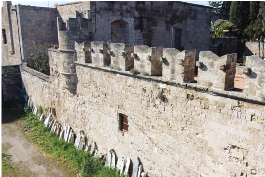
Εικόνα 37. Κτήριο Β, ανατολικός τοίχος
