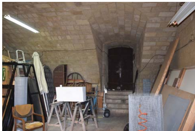
Εικόνα 16. Κτήριο Α, χώρος εισόδου Α.101, δυτική θύρα Θ1.02
