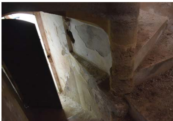
Εικόνα 50. Κτήριο Β, χώρος Β.102.Γ (κλίμακα ιταλοκρατίας)
