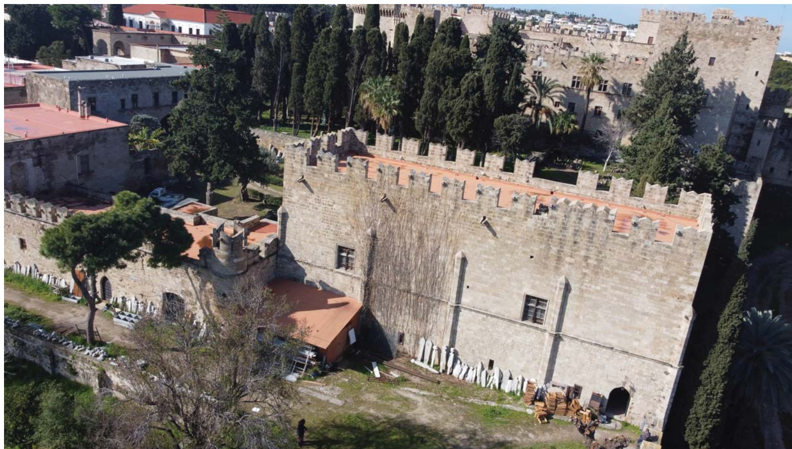
Εικόνα 3. Γενική άποψη του κτηριακού συγκροτήματος από τα βορειοανατολικά. Στο βάθος το παλάτι του Μεγάλου Μαγίστρου (Ξ.Σίμου, 2024)
