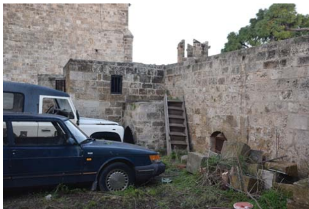
Εικόνα 40. Κτήριο Β, άποψη δυτικής πλευράς
