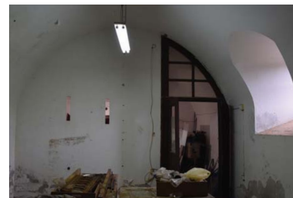
Εικόνα 52. Κτήριο Β, αίθουσα Β.104, βόρειος τοίχος
