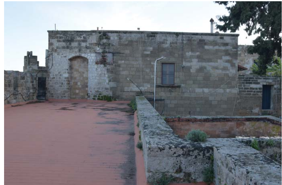
Εικόνα 38. Κτήριο Β, άποψη δώματος προς τα νότια
