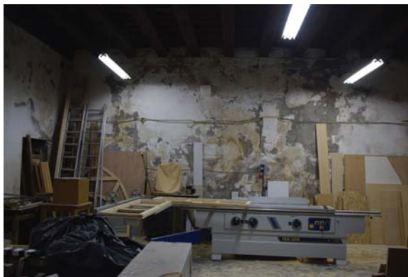
Εικόνα 73. Κτήριο Β, χώρος Β.101
