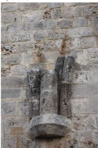
Εικόνα 29. Λεπτομέρεια γένεσης σταυροθαλίου πιθανής κατασκευής περιστώου
