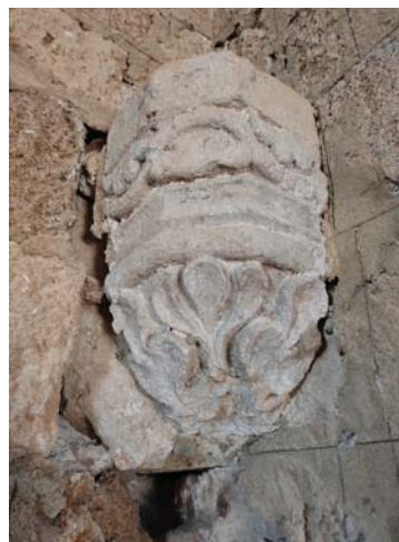
Εικόνα 34. Κτήριο Α, αίθουσα Α.201, σωζόμενο επίκρανο αρχικής ιπποτικής κατασκευής σταυροθαλίου στη ΝΔ γωνία
