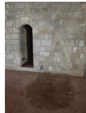
Εικόνα 71. Εισροή υδάτων στην αίθουσα Β.101 λόγω αστοχίας υγραμόνωσης
