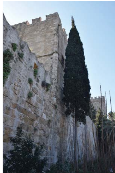
Εικόνα 13. Κτήριο Α, Ανάπτυξη του κτηρίου πάνω στο βόρειο τείχος της μεσαιωνικής οχύρωσης, άποψη από το προτείχισμα της οχύρωσης
