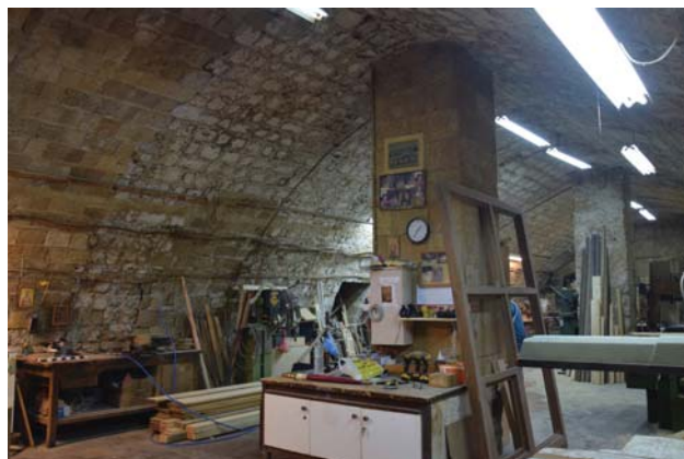
Εικόνα 19. Κτήριο Α, κύριος θολωτός χώρος ξυλουργείου Α.102, άποψη από τα βόρεια
