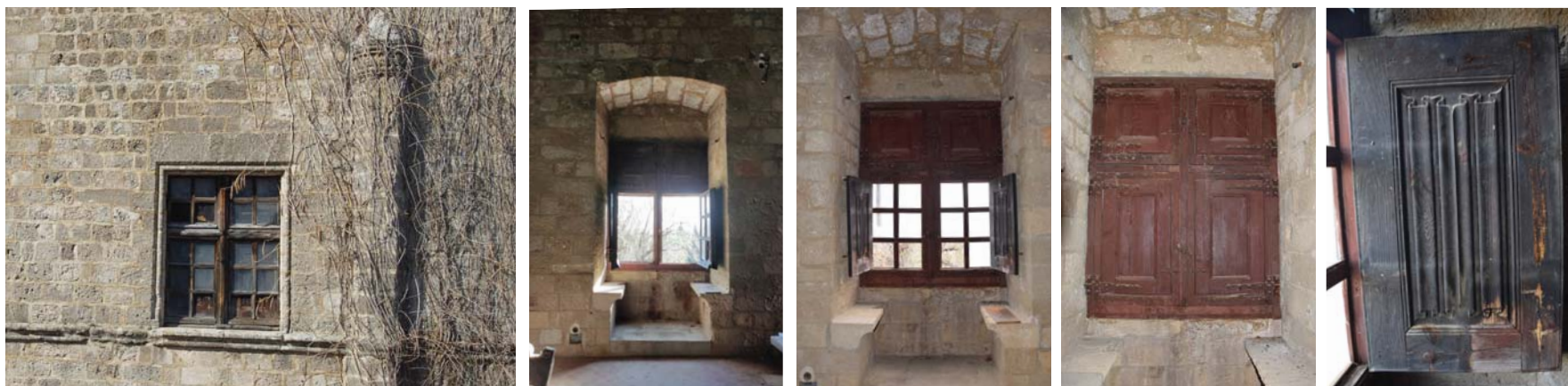
Εικόνα 98. Κτήριο Α, Παράθυρο ορόφου Π.205
