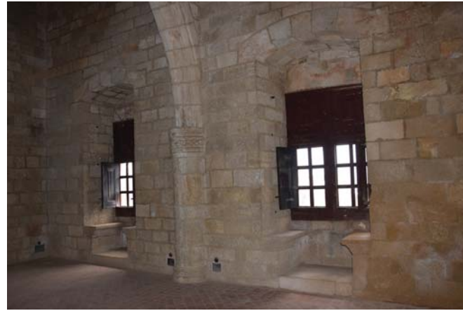
Εικόνα 23. Κτήριο Α, αίθουσα ορόφου Β.101
