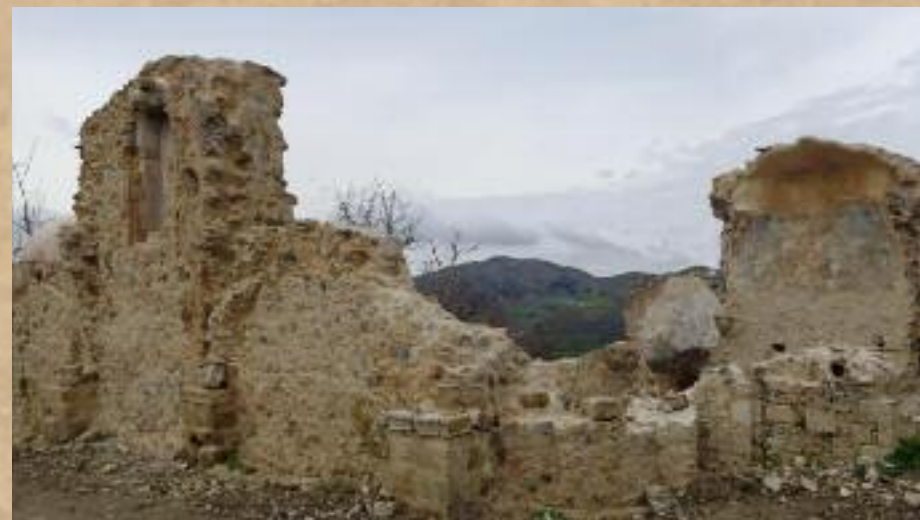
Παναγία στην Πατσώ, άποψη του ναού πριν και κατά τη διάρκεια των εργασιών
