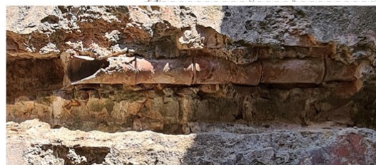
Σχήμα 1: Πήλινοι σωλήνες δικτύου διανομής κρύου και ζεστού νερού.
