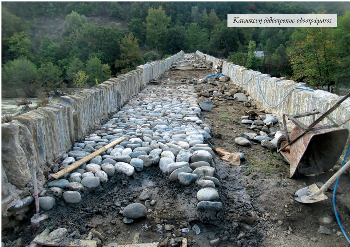
Κατασκευή του διδούστρωτου οδοστρώματος.
