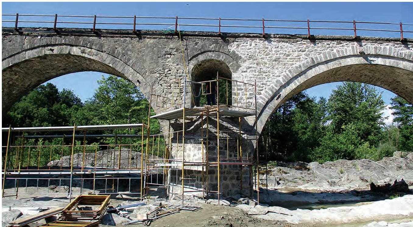
Κατά τη διάρκεια των εργασιών
