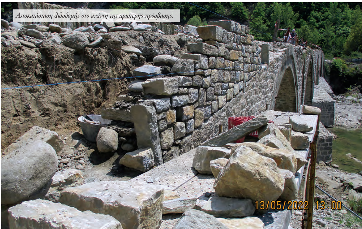
Εγκατάσταση δαπέδου εργασίας του 5ου τόξου.
