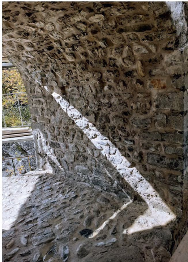
Εσωτερικό ανακουφιστικού τόξου μετά την αποκατάστασή του.
