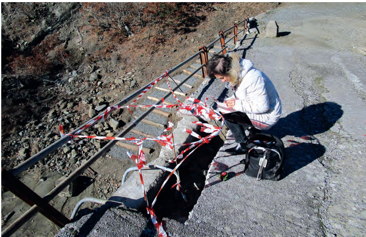
Διερευνητική τομή και αποτύπωση στρωτογραφίας.
