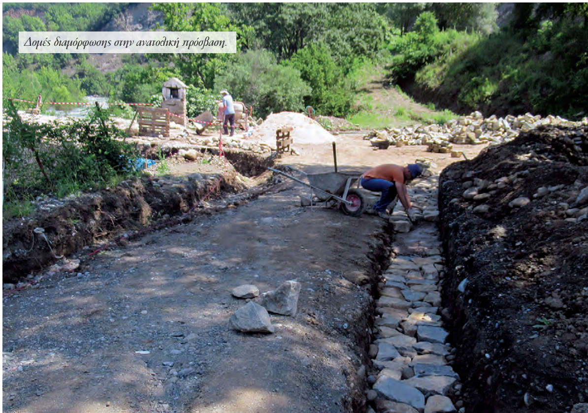
Στραγγιστικοί αύλακες απορροής και διενδότησης ομβρίων.
