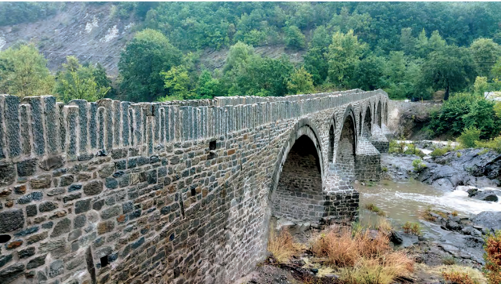
Τχρος στην αρχική δέση του οδοστρώματος της δυτικής πρόσβασης με εντοιχισμό αρκάδων.
