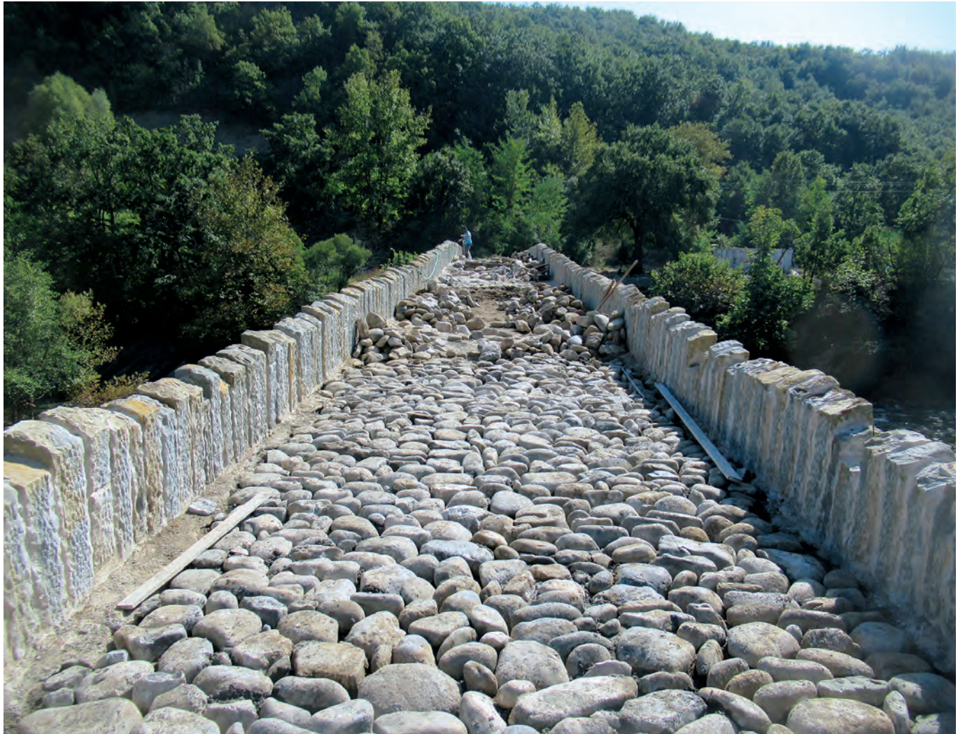
Ανακατασκευή του διδύρωτου καταστρώματος.
