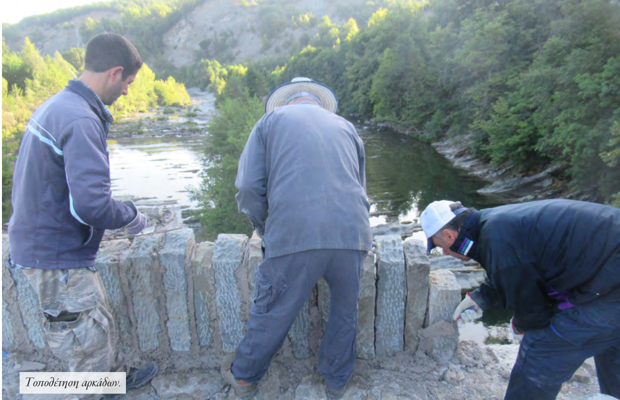
Ενίσχυση καμαρών και αποκατάσταση αρμοδογημάτων.
