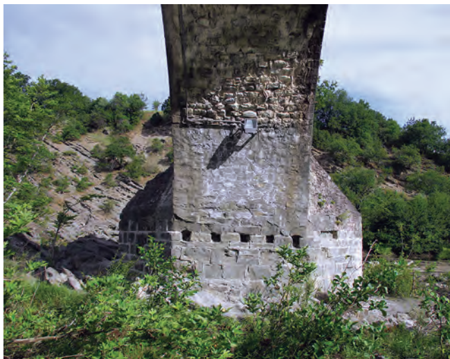
Άποψη εσωραχίου καμάρας πριν τις εργασίες με επίχρισμα από τοιμενοκονίαμα και την ηλεκτρική εγκατάσταση φωτισμού.
