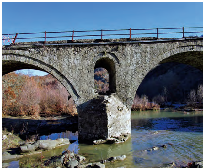
1 ο μεσόβαθρο πριν τις εργασίες αποκατάστασης.
