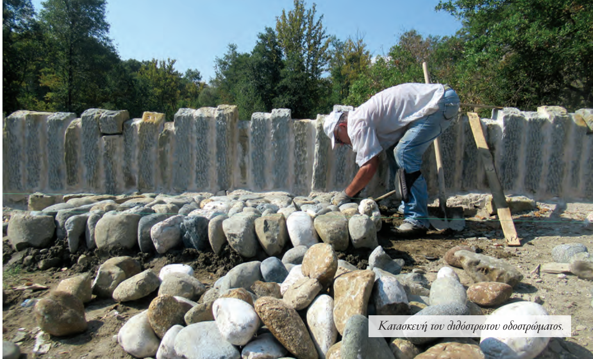
Κατασκευή διδούστρωτου οδοστρώματος.
