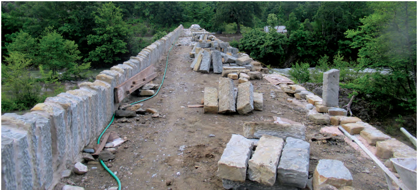
Τοποθέτηση των αρκάδων.
