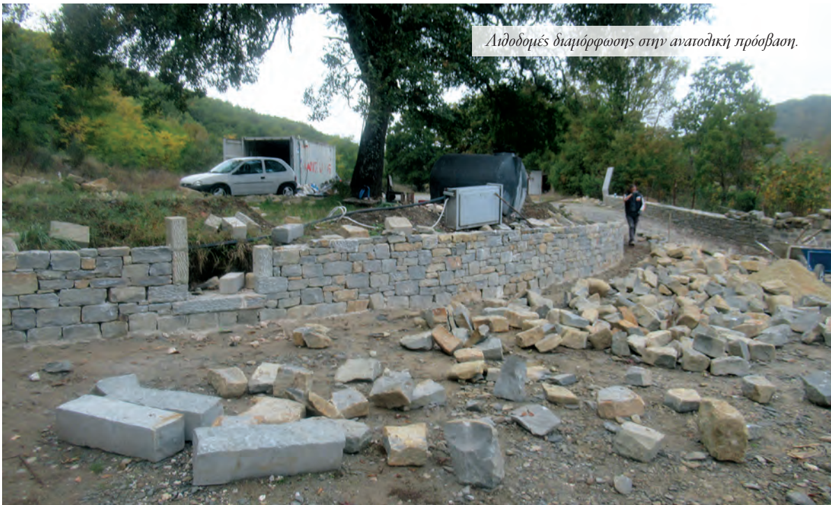
Ανακατασκευή εικονοστασίου και λιδοδομής διαμόρφωσης.
