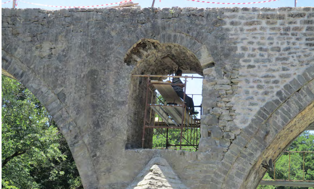
Αποκατάσταση 4 ου ανακουφιστικού τόξου.
