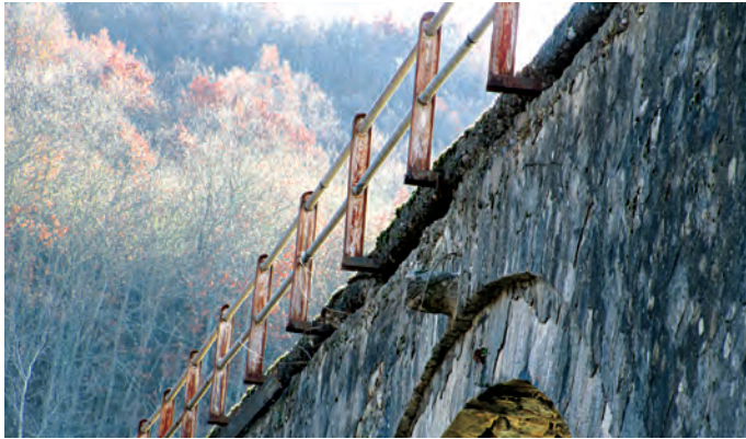
Μεταλλικά κγκηιδώματα οδοστρώματος.
