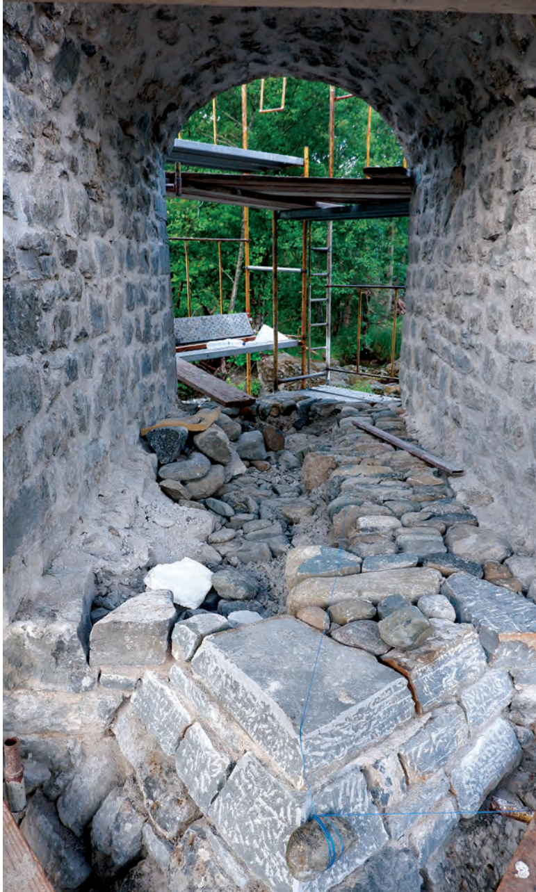
Αποκατάσταση εμβόδου και δαπέδου ανακουφιστικού τόξου.
