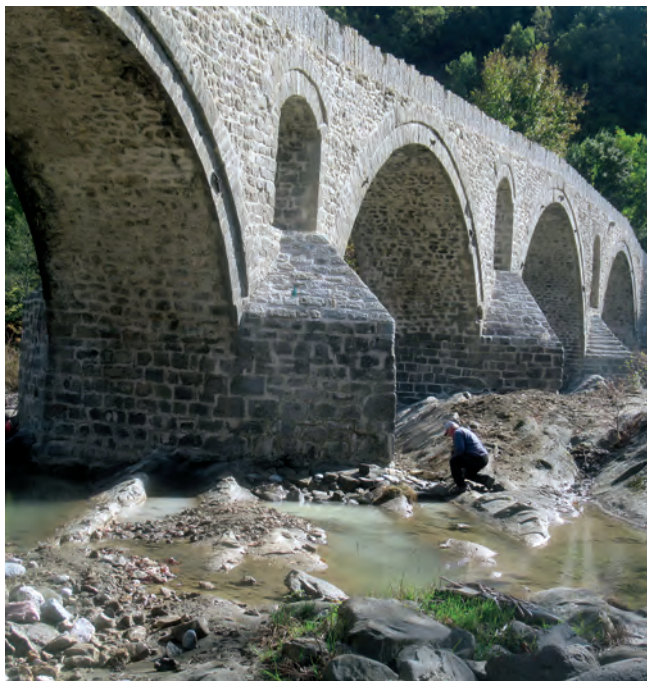
Συμπληρώσεις στη δεμεδίωση μεσόβαθρου
