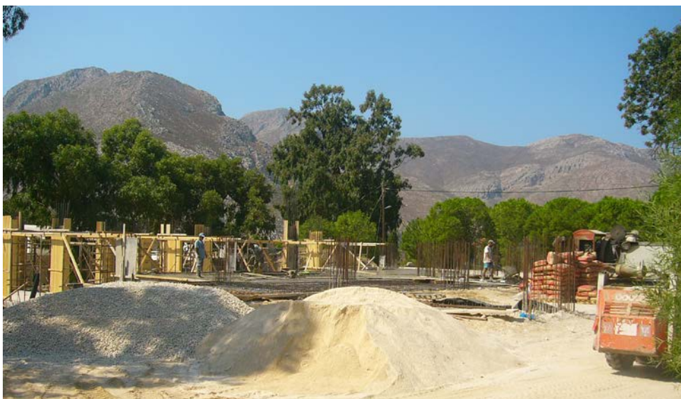
Άποψη των εργασιών κατασκευής της κτιριακής υποδομής του Μουσείου Τήλου
