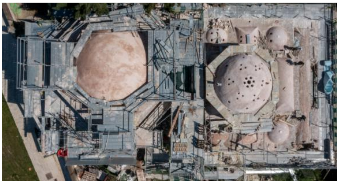
Εικόνα 2: Ανάκτηση θολοδομίας (πριν την τοποθέτηση φύλλων μολύβδου).
