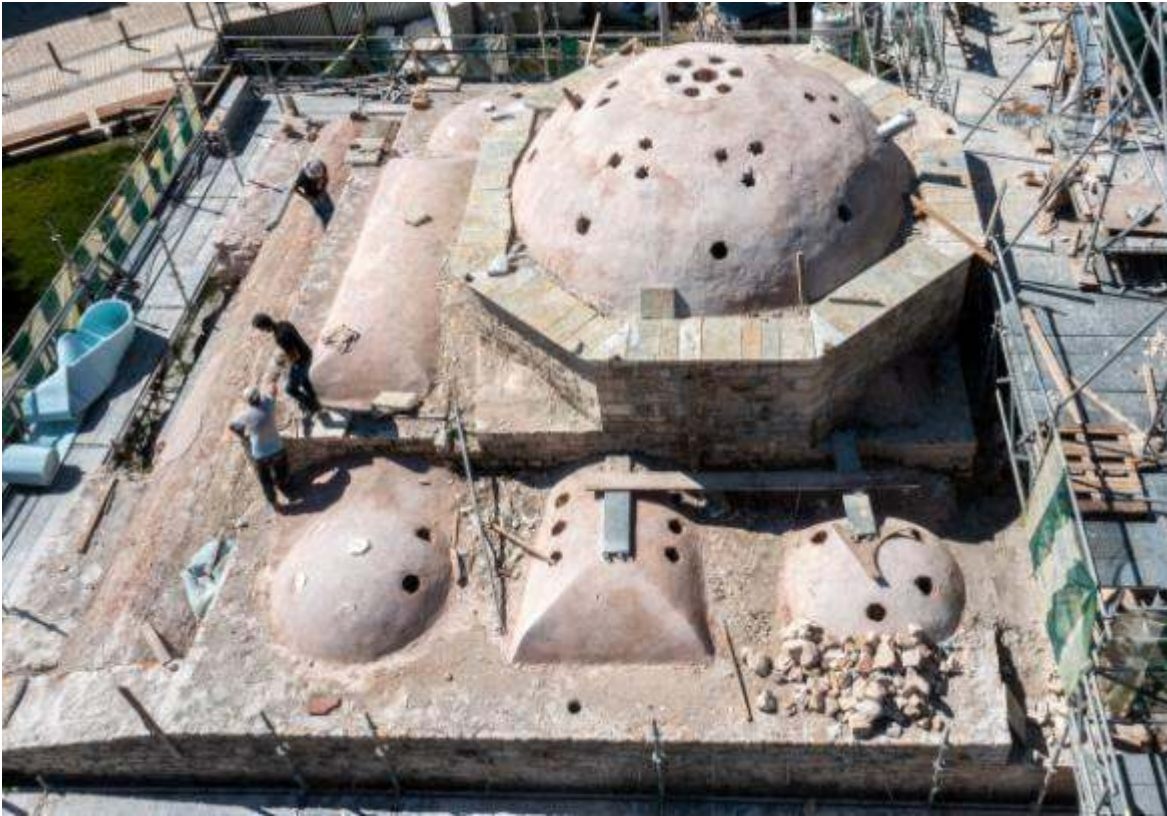
Εικόνα 3: Θολοδομία θερμού χώρου (πριν την τοποθέτηση φύλλων μολύβδου).
