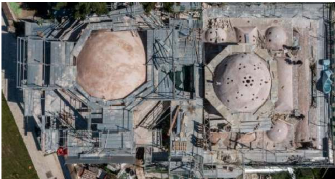
Εικόνα 2: Ανάκτηση θολοδομίας (πριν την τοποθέτηση φύλλων μολύβδου).
