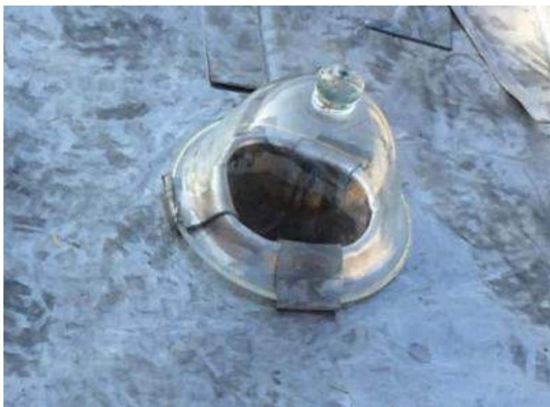
Εικόνα 7: Φωτογραφία κάλυψης φωτιστικής οπής μευάλινοκώδωνα σε άλλο μνημείο
