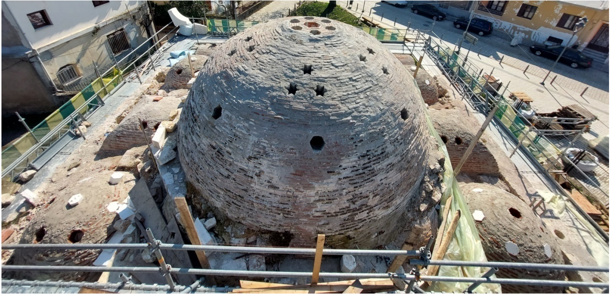
Εικόνα 3: Θολοδομία θερμού χώρου Οθωμανικού Λουτρού στο Κάστρο Ιωαννίνων.
