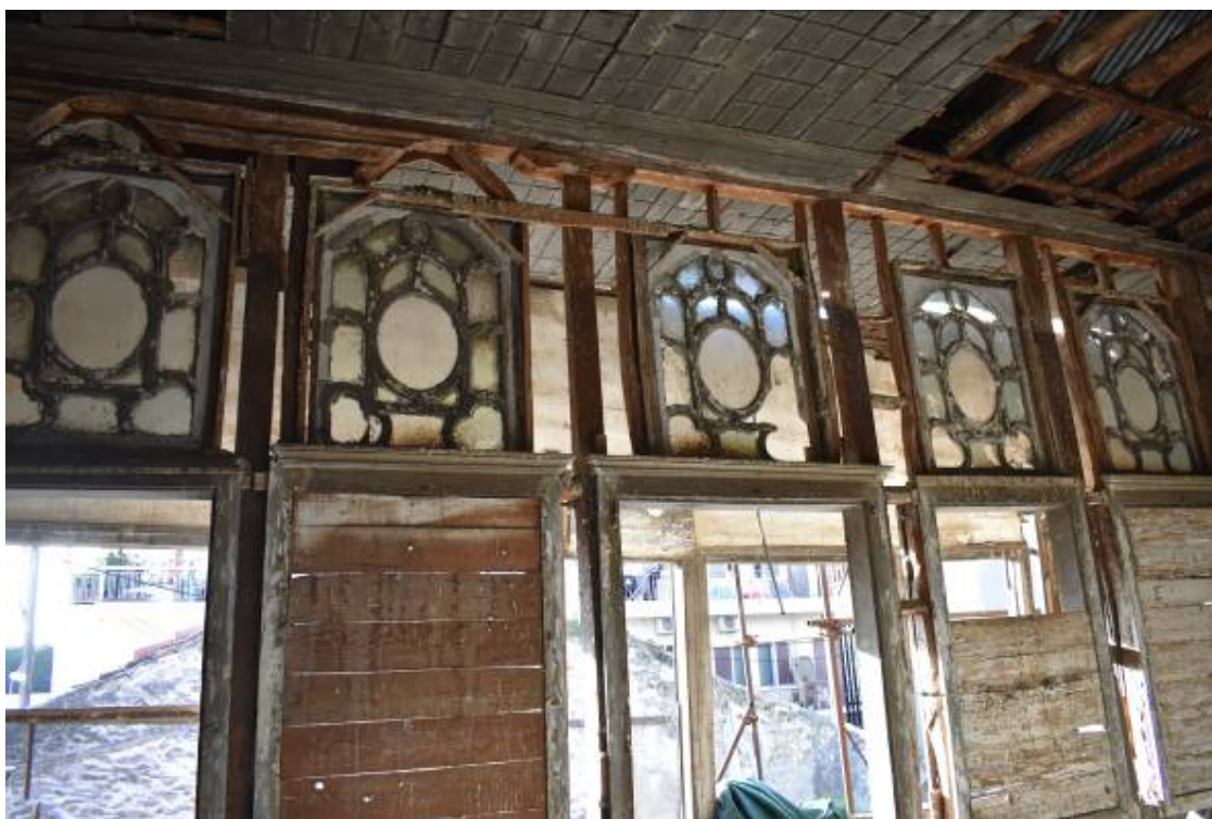
Φωτ. 127 Οι μονοί γύψινοι φεγγίτες του χαγιατιού (A2).
