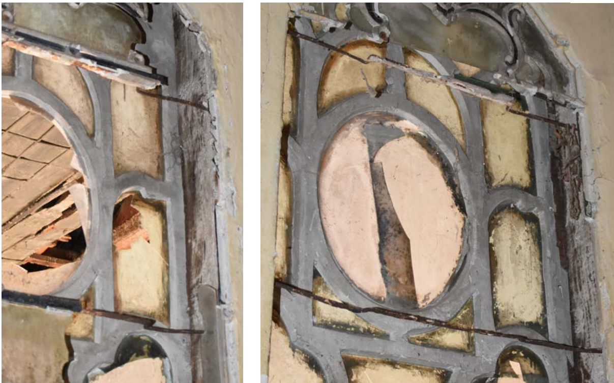
Φωτ. 314 Οξειδωμένος σκελετός στους εσωτερικούς φεγγίτες του ορτά-σοφά (Α5).
