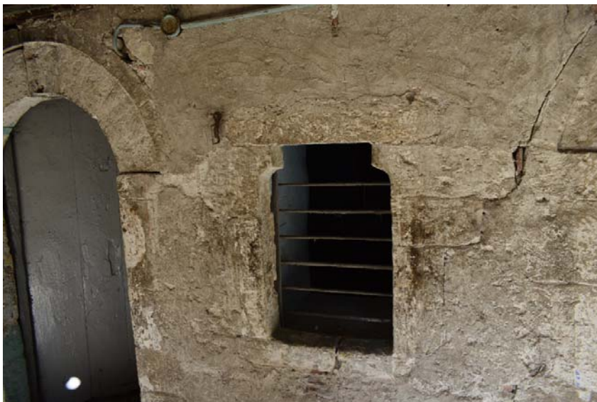
Φωτ. 384. Παράθυρο του Μεσοπατώματος με οριζόντια σιδερένια κιγκλιδώματα κυκλικής διατομής.
