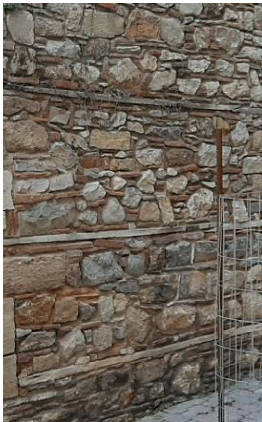
Φωτ. 118 Η τοιχοποιία του ισογείου και του μεσοπατώματος με τις οριζόντιες ξυλοδεσιές.
