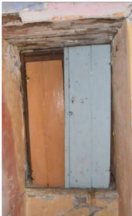
Φωτ. 236 Τοποθέτηση παλαιών ξύλινων τμημάτων πιθανώς από άλλη κατασκευή (αριστερά) και νέου (δεξιά) στα παράθυρα του χώρου ΗΜ2.
