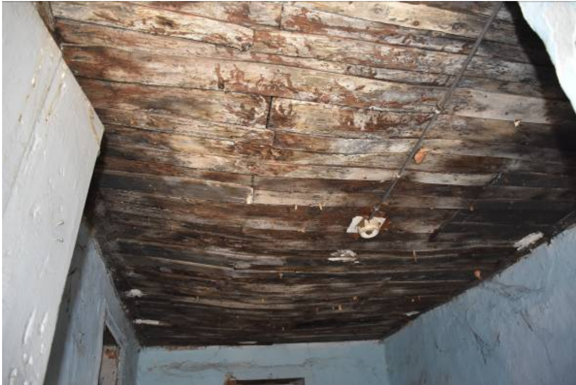
Φωτ. 44 Η οροφή του χώρου ΗΜ3.
