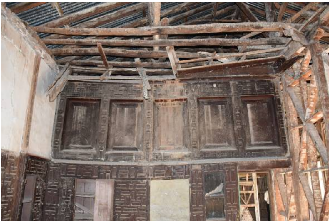
Φωτ. 31 Άποψη του δυτικού οντά (Α6) του ορόφου.
