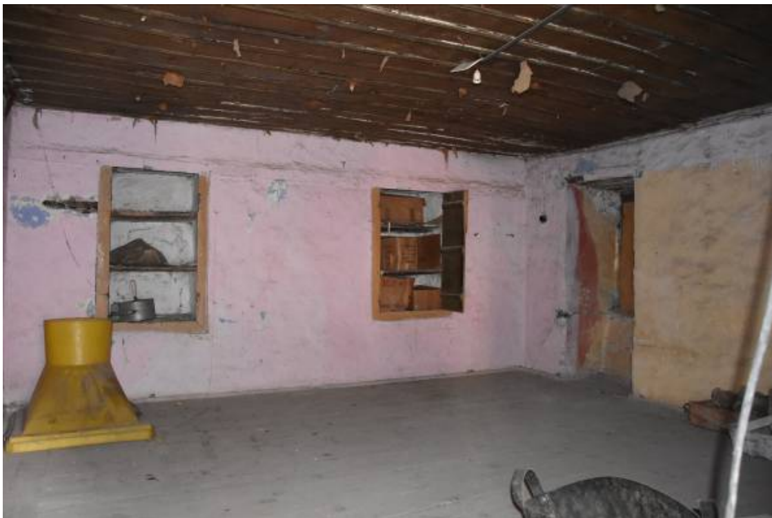
Φωτ. 17 Άποψη του χώρου HM2 του μεσοπατώματος.
