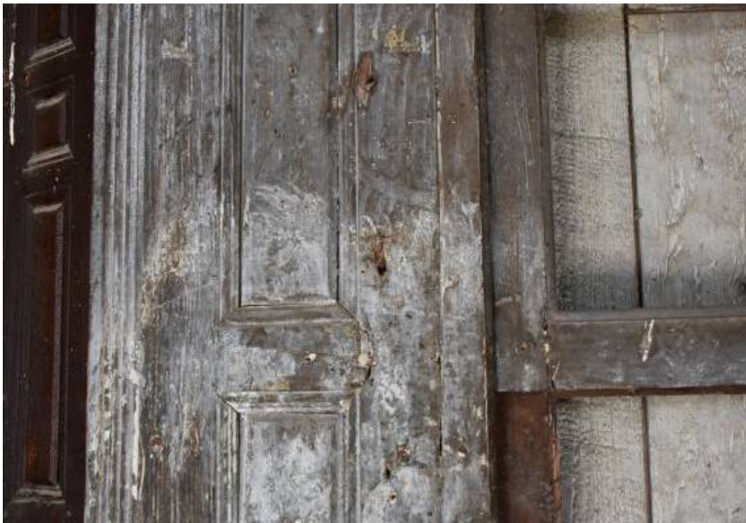
Φωτ. 259 Απώλεια υλικού και οπές από τη δράση των ξυλοφάγων εντόμων και προσβολή από σηπτικούς μύκητες στην όψη του ορτά-σοφά.
