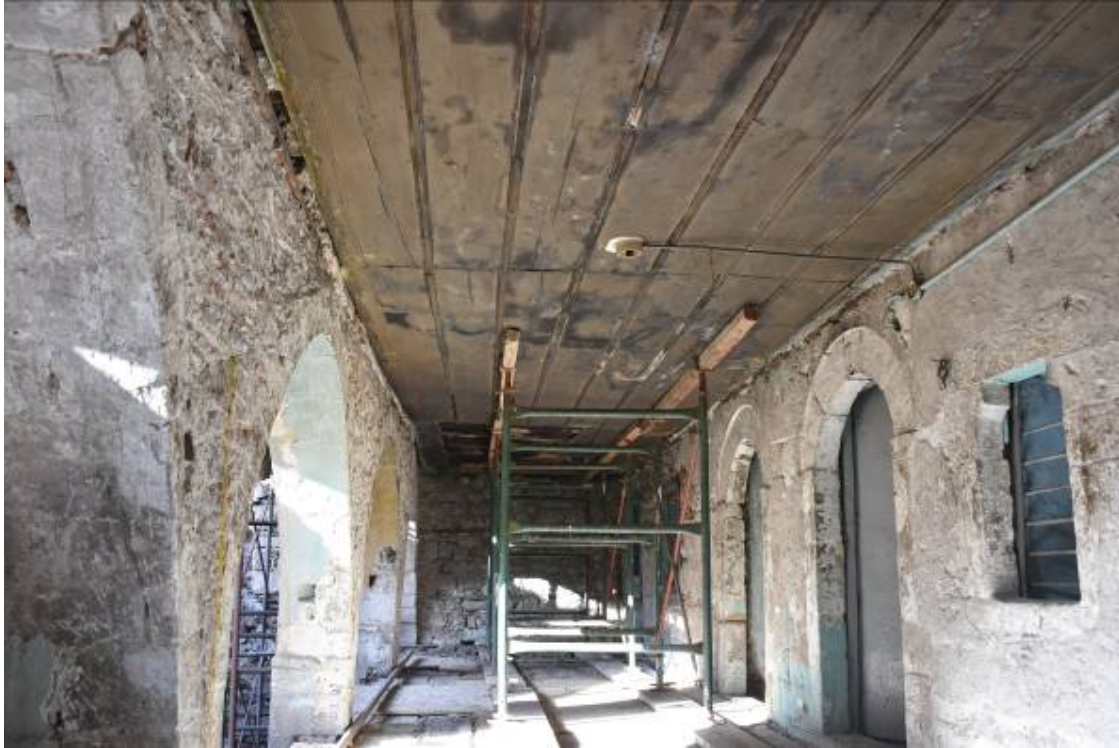
Φωτ. 16 Άποψη του ημιπαϊθριου διάδρομου (HM1) του μεσοπατώματος.
