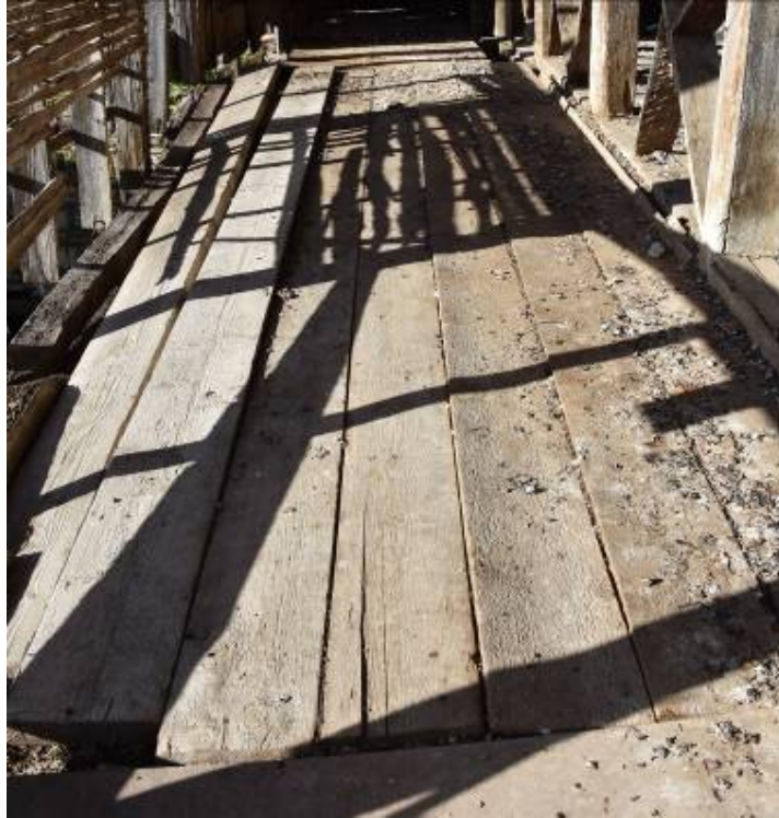
Φωτ. 70 Το δάπεδο του εξώστη (A1).
