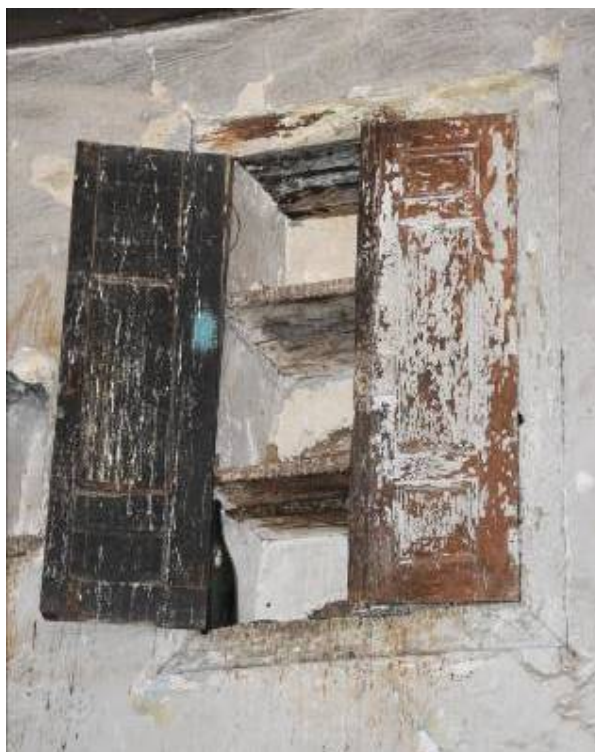
Φωτ. 111 Το ανατολικό ερμάριο του βόρειου τοίχου του χώρου ΗΜ4.
