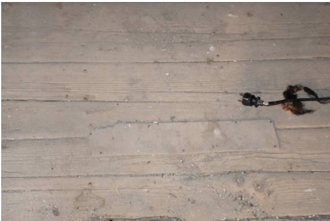
Φωτ. 214 Τοποθέτηση μικρών τμημάτων νέου ξύλου στο δάπεδο του χώρου ΗΜ2.
