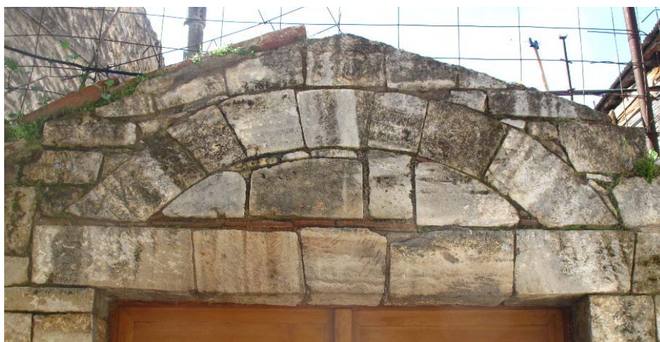
Φωτ. 351. Το λαξευτό λίθινο υπέρθυρο τόξο, εγγεγραμμένο σε αετωματικό πλαίσιο, της θύρας εισόδου επί της οδού Παίδων
