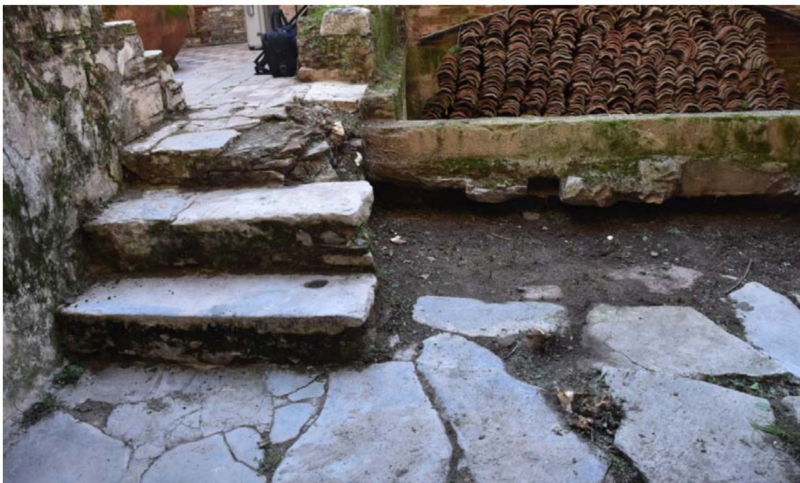
Φωτ. 443. Φθορές λόγω της υγρασίας, μηχανικής καταπόνησης και χρήσης και στις λίθινες πλάκες της πλακόστρωσης της αυλής. Επιπλέον ολική απώλεια κάποιων από τις πλάκες, ενώ μέρος του δαπέδου είναι θαμμένο από τις προσχώσεις.
