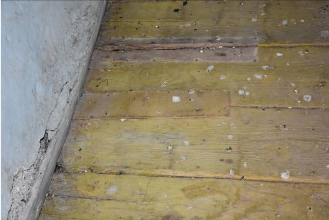
Φωτ. 215 Τοποθέτηση μικρών τμημάτων νέου ξύλου στο επιχρωματισμένο δάπεδο του χώρου ΗΜ3.
