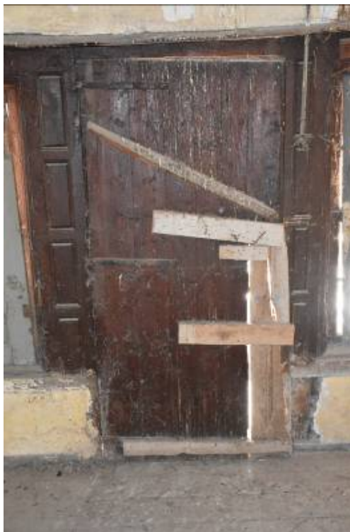
Φωτ. 233 Τοποθέτηση νέων τμημάτων ξύλου στη θύρα του ορτά-σοφά (A5).
