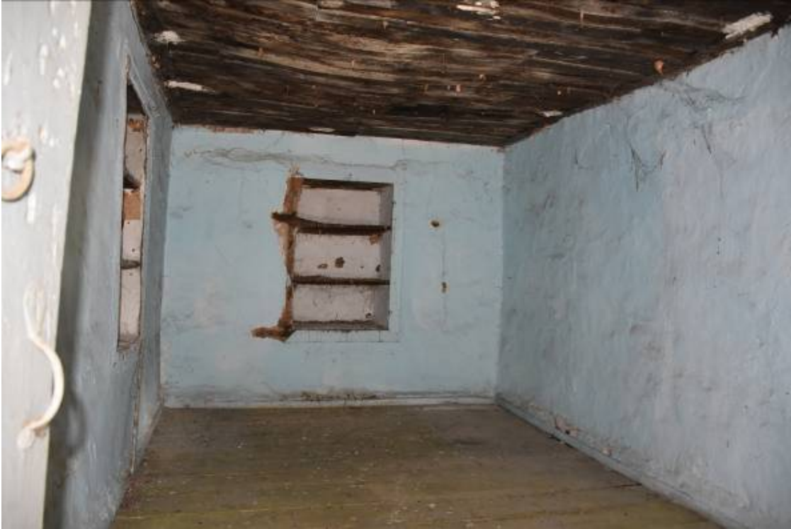
Φωτ. 18 Άποψη του χώρου ΗΜ3 του μεσοπατώματος.
