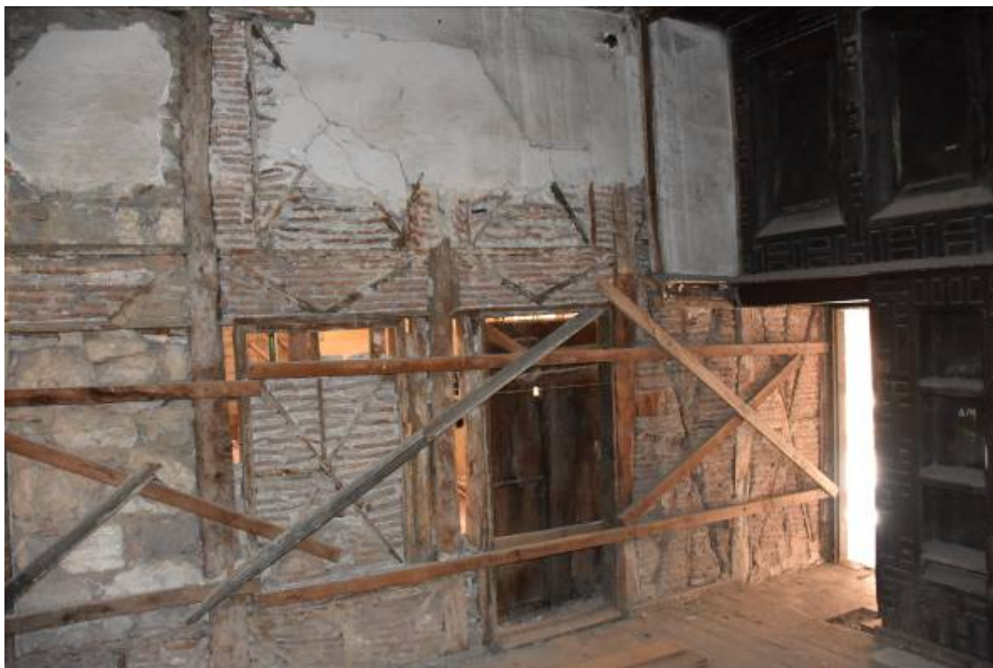
Φωτ. 35 Ξυλόπηκτος τοίχος του ορόφου.
