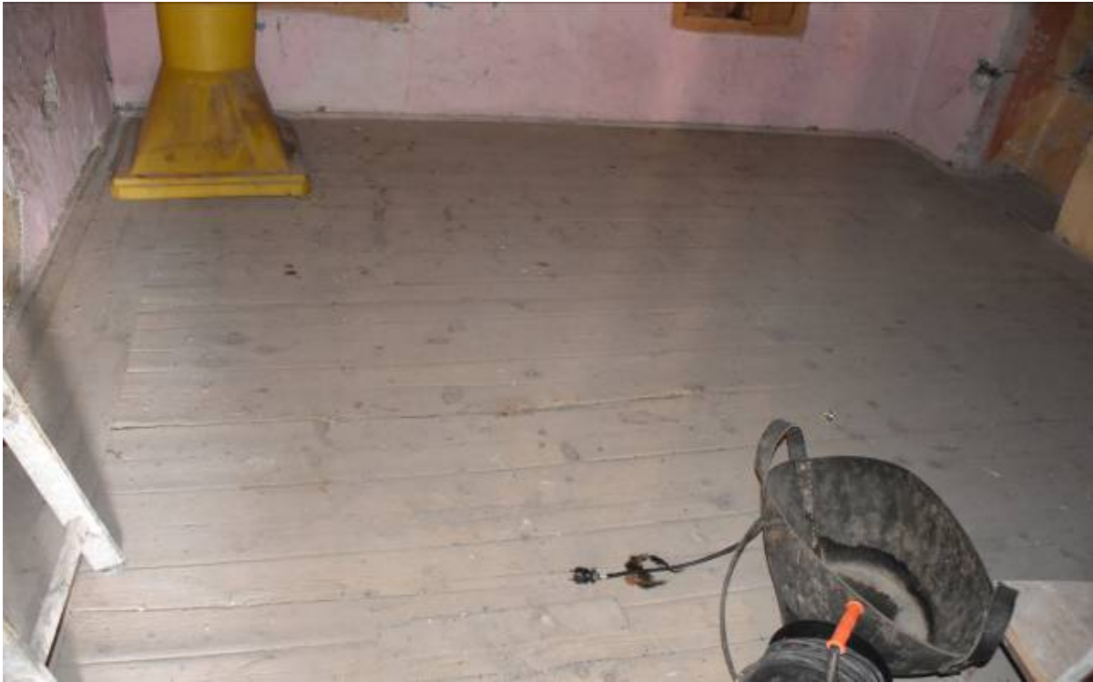
Φωτ. 68 Το δάπεδο του χώρου ΗΜ2.
