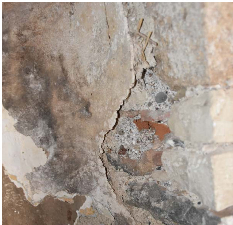
Φωτ. 321 Σαθροποιημένο κονίαμα στην παραστιά του τζακιού.
