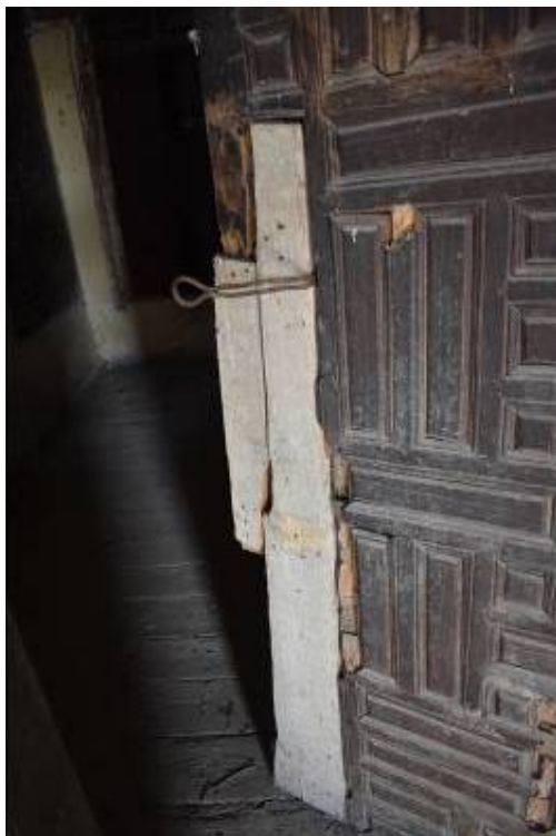
Φωτ. 233 Τοποθέτηση νέων τμημάτων ξύλου στη θύρα του ορτά-σοφά (A5).
