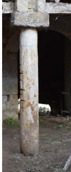
Φωτ. 371. Άποψη της μεσαίας κολώνας που αναπτύσσεται κάτω από το ξύλινο κλιμακοστάσιο ανόδου στον Όροφο.
