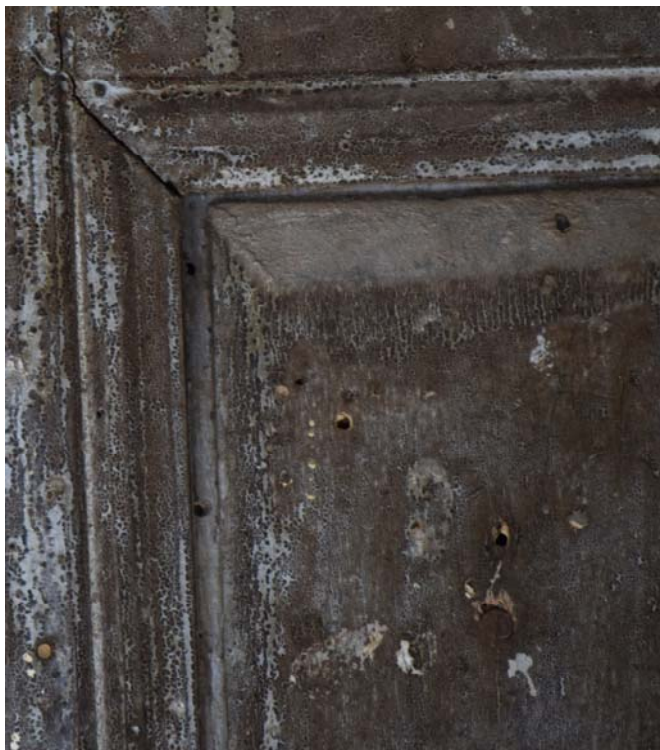
Φωτ. 260 Οπές από τη δράση των ξυλοφάγων εντόμων στην όψη του ορτά-σοφά.
