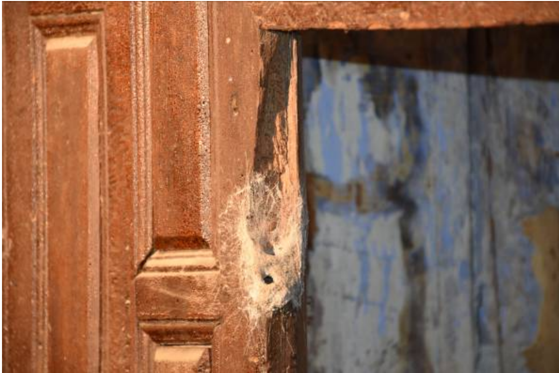
Φωτ. 249 Απώλεια υλικού από την δράση των ξυλοφάγων εντόμων.
