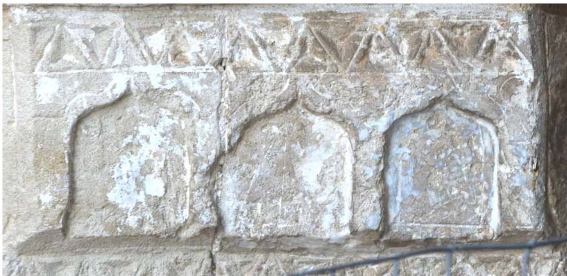
Φωτ. 436. Στρώματα χρωματιστού κονιάματος και στο διακοσμητικό ανάγλυφο της γωνίας.
