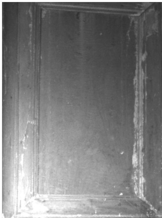
Φωτ. 170 Φωτογράφιση με το σύστημα Muisi στα 1000nm (IR, υπέρυθρο), όπου δεν διακρίνεται υποκείμενο ζωγραφικό στρώμα στο δεύτερο άνω ταμπλά της μουσάντρας του δυτικού οντά.
