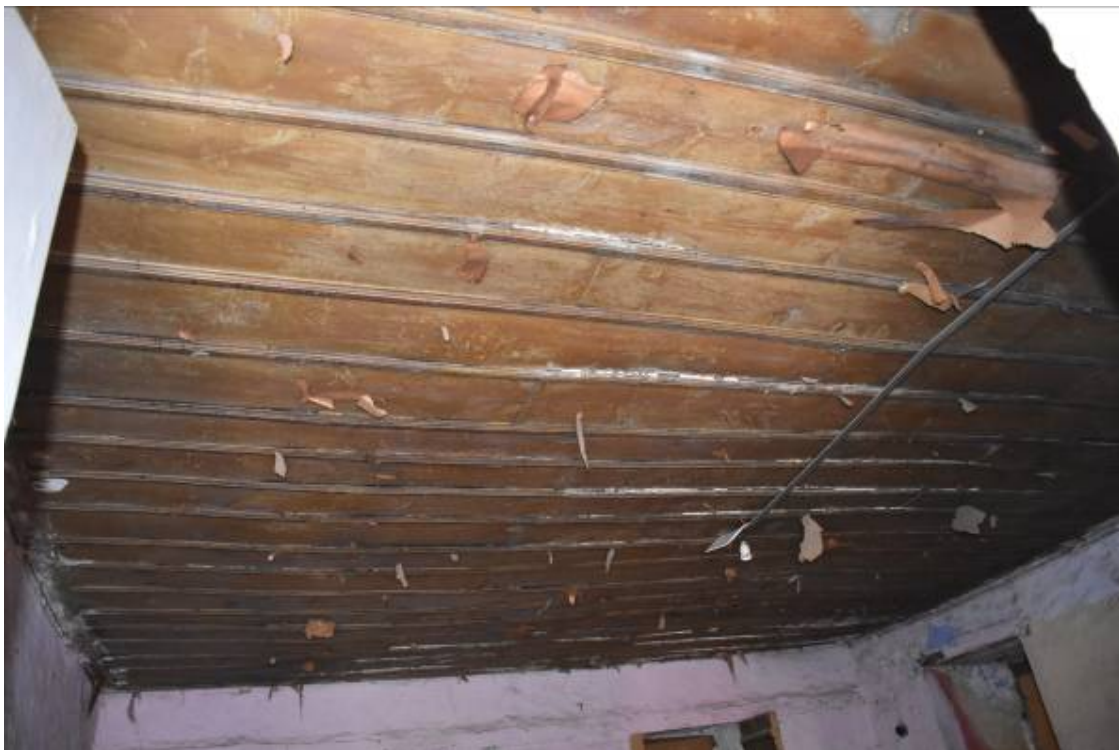
Φωτ. 43 Η οροφή του χώρου ΗΜ2.
