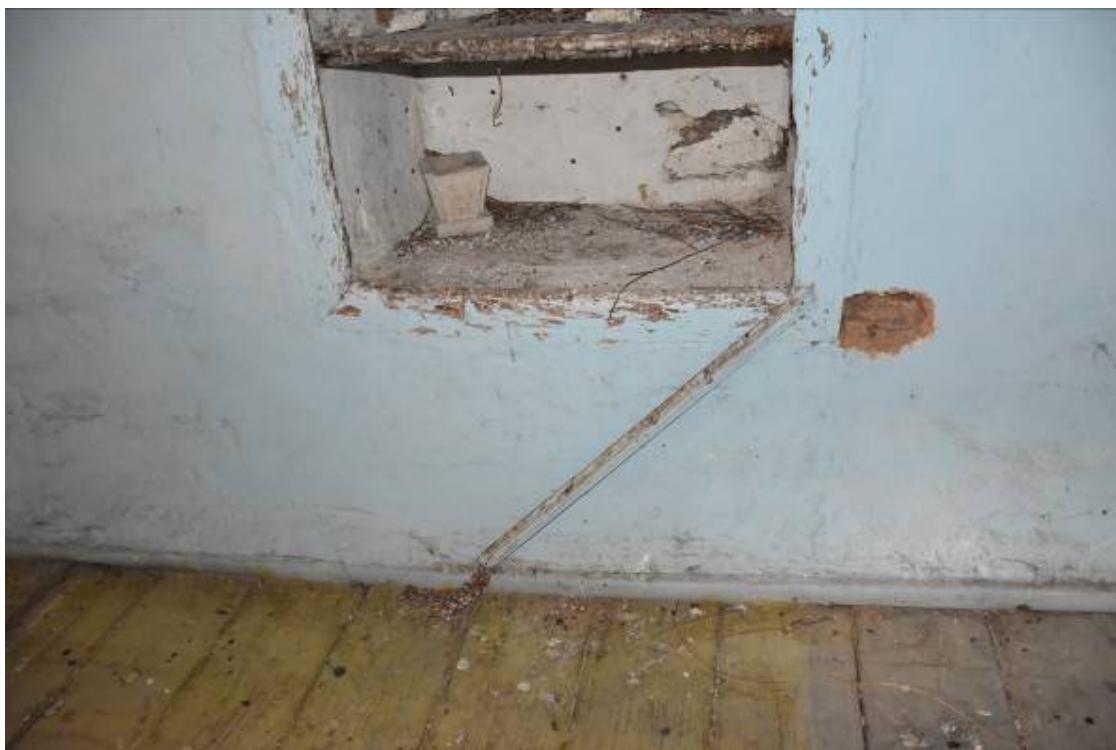
Φωτ. 269 Αποκολλημένο ξύλινο τμήμα σε ερμάριο του χώρου ΗΜ3.
