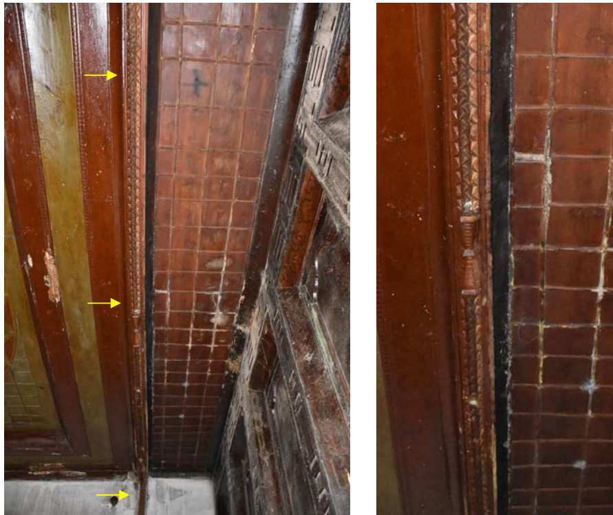
Φωτ. 57 Η οροφή μπροστά από τη μουσάντρα του ανατολικού οντά (A4) και η σκαλιστή κορνίζα που την χωρίζει την περίτεχνη οροφή.
