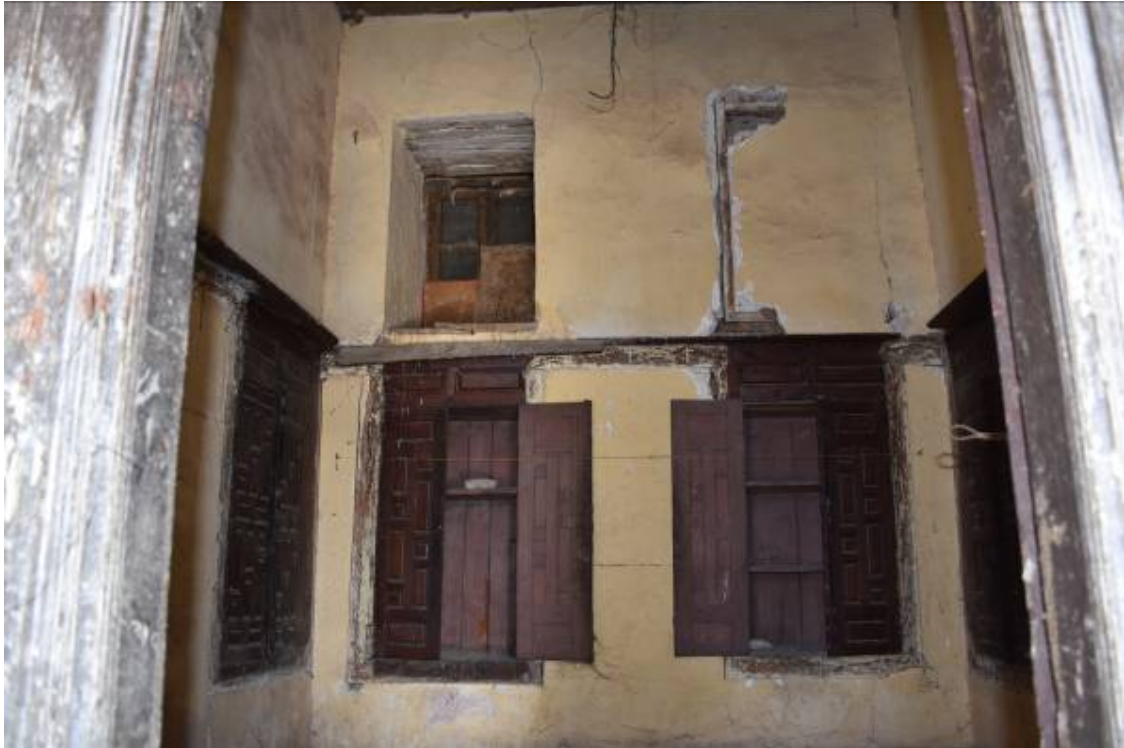
Φωτ. 26 Άποψη του ορτά- σοφά (A5) του ορόφου.
