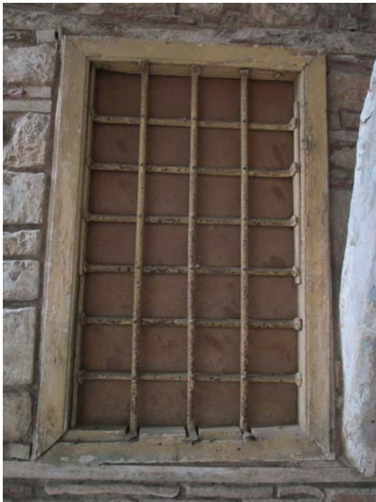
Φωτ. 390-391. Τα μεταλλικά πλέγματα στα παράθυρα του μεσοπατώματος εξωτερικά. Διακρίνονται επικαθίσεις και οξείδωση της μεταλλικής επιφάνειας.
