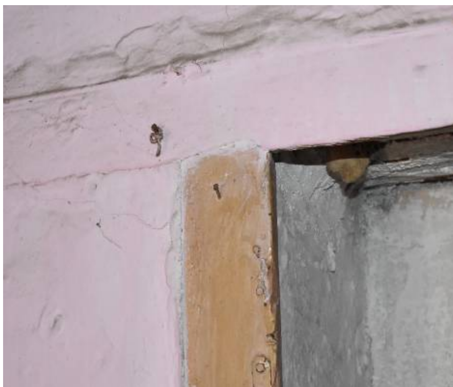
Φωτ. 273 Οξειδωμένος μεταλλικός σύνδεσμος σε ερμάριο του χώρου ΗΜ2.
