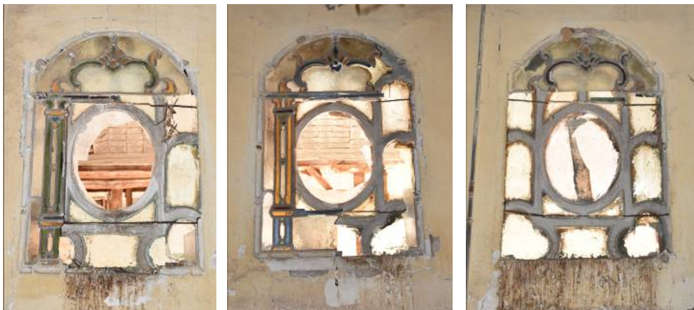
Φωτ. 132 Η πίσω πλευρά των τριών διπλών γύψινων φεγγιτών του ορτά-οντά (A5).
