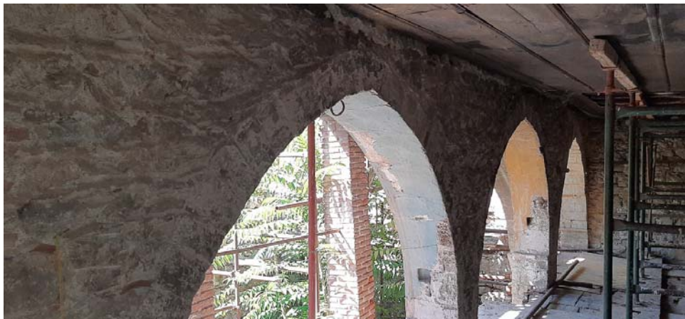
Φωτ. 380. Άποψη της αψιδωτής τοξοστοιχίας στο επίπεδο του Μεσοπατώματος, κατασκευασμένη με πλινθοπερίκλειστο σύστημα.
