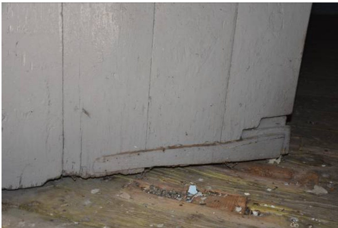
Φωτ. 232 Τοποθέτηση νέων τμημάτων ξύλου στην επιχρωματισμένη θύρα του χώρου ΗΜ3.
