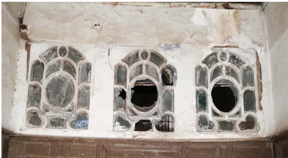
Φωτ. 385. Άποψη των γύψινων φεγγιτών μετά διαφανή υαλοπετάσματα του ορτά-σοφά.
