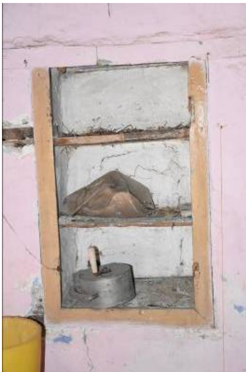
Φωτ. 267 Απώλεια φύλλων σε ερμάριο του χώρου ΗΜ2 (αριστερά) και του δυτικού οντά (δεξιά).
