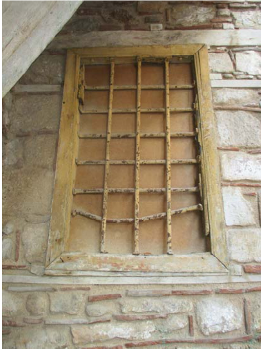
Φωτ. 394-395. Μεταλλικό πλέγμα παραθύρου και η λεπτομέρεια του, όπου διακρίνονται επικαθίσεις και οξείδωση της μεταλλικής επιφάνειας, αλλά και στρέβλωση του σχήματος των μεταλλικών ράβδων λόγω μηχανικής καταπόνησης.
