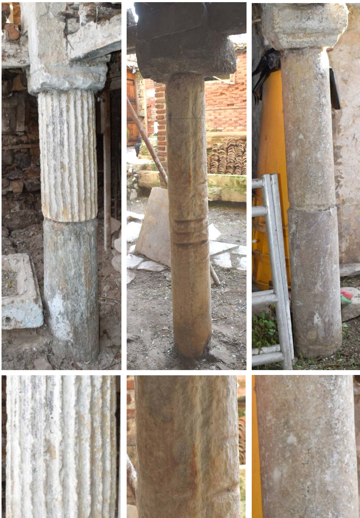
Φωτ. 420-425. Λίθοι παλαιότεροι σε επαναχρησιμοποίηση στις 3 κολώνες του ισογείου. Διακρίνονται επίσης απομείωση της επιφάνειας, κονιάματα βαφής και επιφανειακές εκδορές και απολεπίσεις.
