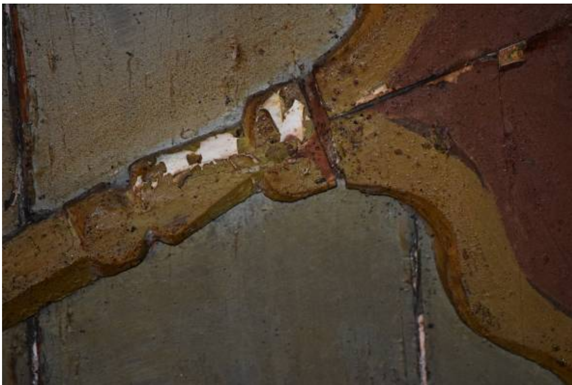
Φωτ. 200 Απώλειες χρωματικού διακόσμου και αποκολλημένο ζωγραφικό στρώμα στην οροφή του ανατολικού οντά (Α4).
