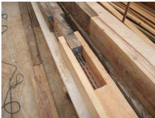
Φωτ. 343 Συμπλήρωση δοκού.
