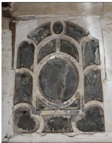
Φωτ. 130 Οι τρεις διπλοί γύψινοι φεγγίτες, όπως φαίνονται από την όψη του ορτά-οντά (A5).
