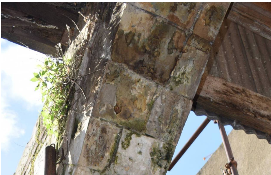
Φωτ. 414. Περιβαλλοντικές επικαθίσεις, στρώμα βιολογικό, παρουσία φυτών, και μαύρες κρούστες σημειακά στο κάτω μέρος της αψίδας της αυλής.
