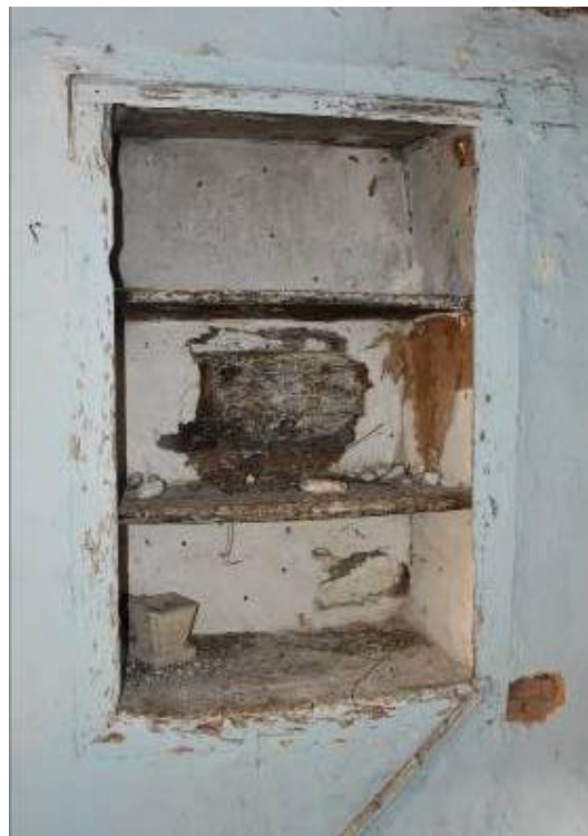
Φωτ. 108 Το ερμάριο του δυτικού τοίχου του χώρου ΗΜ3.
