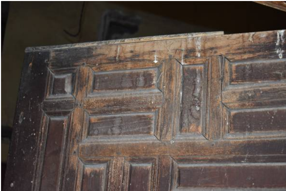
Φωτ. 240 Απώλεια χρωματικού στρώματος στη θύρα του ορτά-σοφά (A5).
