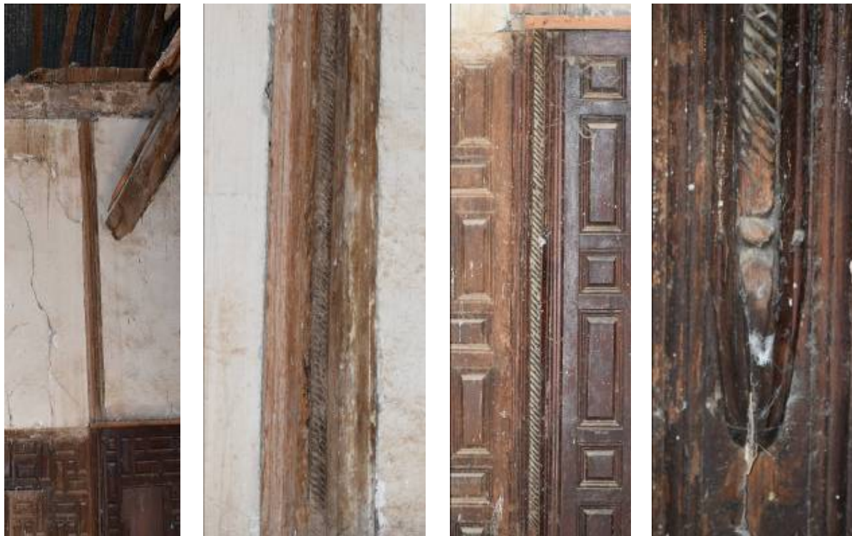
Φωτ. 62 Η σκαλιστή κορνίζα που χώριζε την περίτεχνη οροφή του δυτικού οντά (Α6) από την οροφή μπροστά από τη μουσάντρα.
