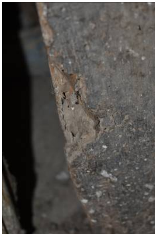
Φωτ. 230 Απώλεια ξύλινου τμήματος από τη δράση ξυλοφάγων εντόμων στη θύρα του δυτικού οντά (Α6).
