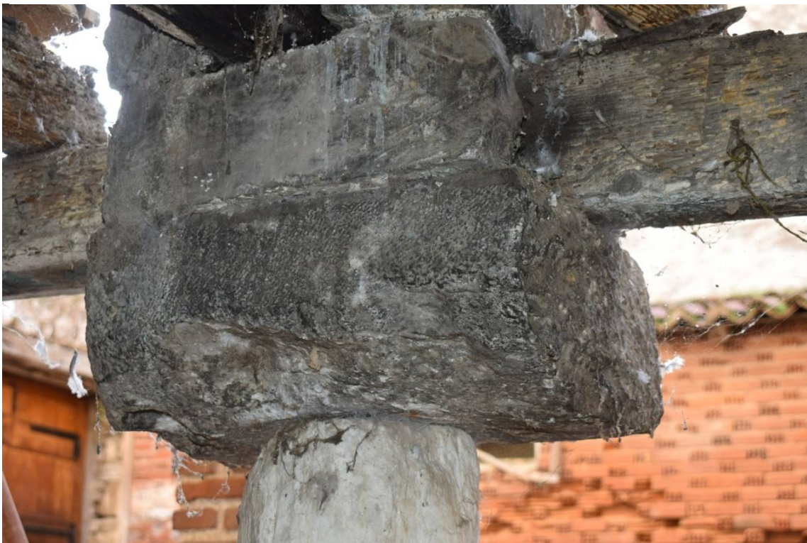
Φωτ. 419. Στρώμα περιβαλλοντικών επικαθίσεων, περιττώματα πτηνών και υλικά από οικοδομικές δραστηριότητες στο λίθινο κιονόκρανο της μεσαίας κολώνας του ισογείου.
