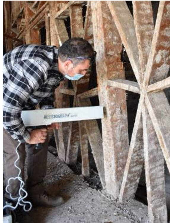
Φωτ. 154 Μέτρηση της πυκνότητας του ξύλου σε ύψος 0,70μ. από το δάπεδο (μπροστινή πλευρά, πάχους 17εκ.).
