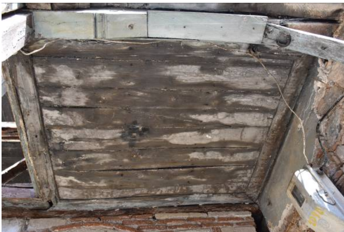
Φωτ. 41 Η οροφή του χώρου ΗΜ0.
