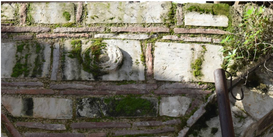
Φωτ. 405. Στην διπλή αψίδα του προαύλιου χώρου, η διακοσμητική ροζέτα και στρώμα βιολογικών επικαθίσεων, μαζί με έντονη παρουσία φυτών με ανώτερο ριζικό σύστημα στα δεξιά.
