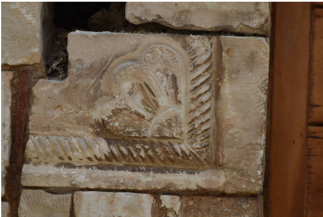
Φωτ. 412. Περιβαλλοντικές επικαθίσεις και μαύρες κρούστες σημειακά στον διακοσμημένο λίθο της αυλόθυρας αριστερά της ξύλινης πόρτας.
