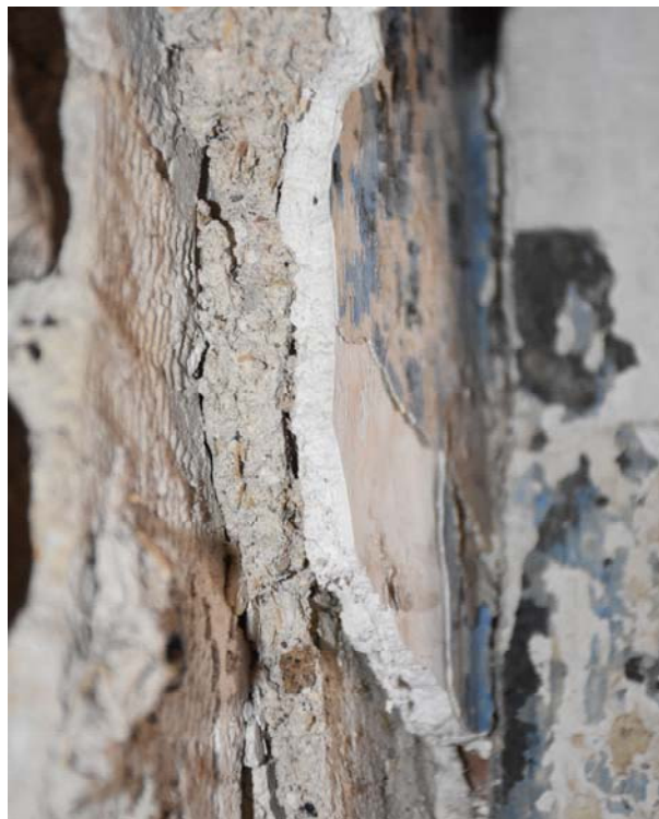
Φωτ. 319 Αποκόλληση του γύψινου διακοσμητικού από το κονίαμα του τοίχου και σαθροποίηση του γύψινου υποστρώματος.
