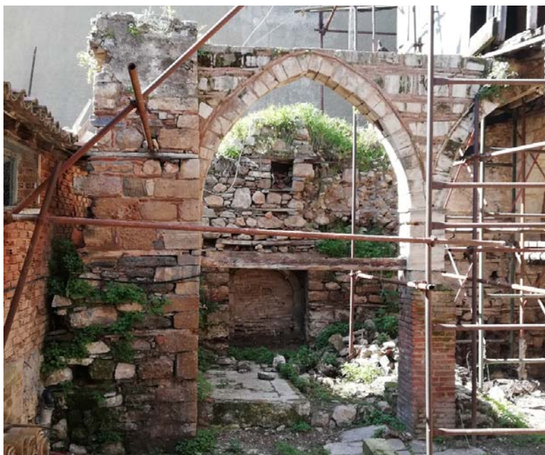
Φωτ 363. Το διπλό αψιδωτό άνοιγμα με τα δύο οξυκόρυφα τόξα, όπου το ένα εφάπτεται στον τοίχο της περίφραξης και το άλλο στον τοίχο της οικίας.
