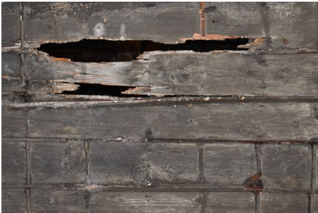
Φωτ. 185 Απώλεια ξύλινων τμημάτων από τη δράση των ξυλοφάγων εντόμων στην οροφή του χαγιατιού (A2).
