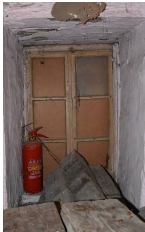
Φωτ. 236 Τοποθέτηση παλαιών ξύλινων τμημάτων πιθανώς από άλλη κατασκευή (αριστερά) και νέου (δεξιά) στα παράθυρα του χώρου ΗΜ2.
