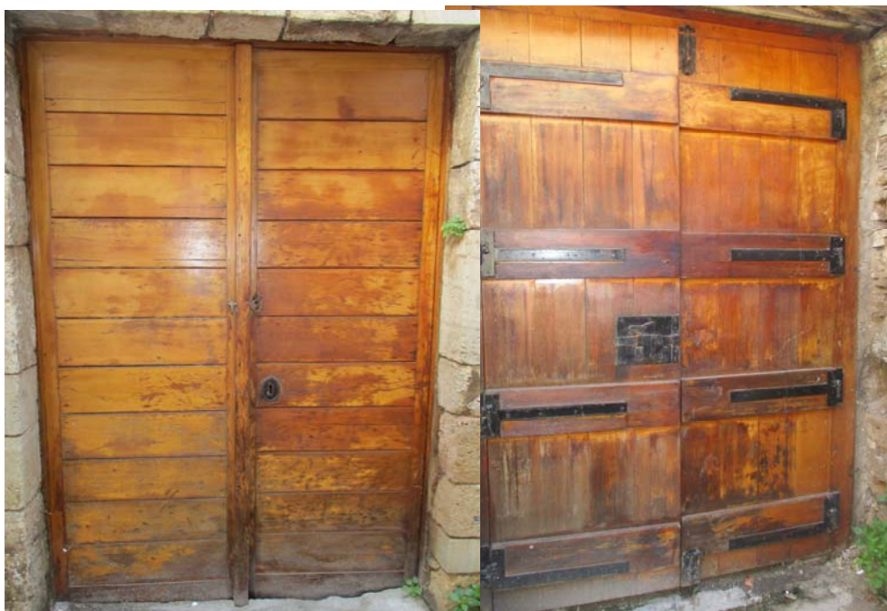
Φωτ. 354-355. Το ξύλινο θύρωμα της εισόδου στον αύλειο χώρο της Οθωμανικής οικίας, με τα μεταλλικά στοιχεία όπως κλειδαριά, δακτύλιοι, ταινιωτά ελάσματα βάσης, σύρτες, μεντεσέδες, ταινιωτά ελάσματα σε σχήμα T και Γ. Οι δύο όψεις του, εξωτερική και εσωτερική.
