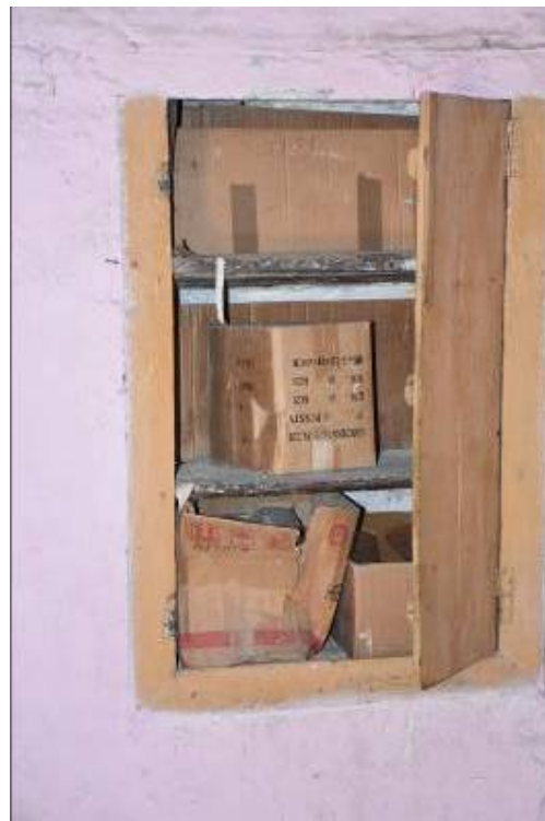
Φωτ. 106 Το ανατολικό ερμάριο του βόρειου τοίχου του χώρου ΗΜ2.
