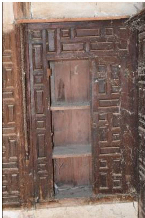
Φωτ. 267 Απώλεια φύλλων σε ερμάριο του χώρου ΗΜ2 (αριστερά) και του δυτικού οντά (δεξιά).
