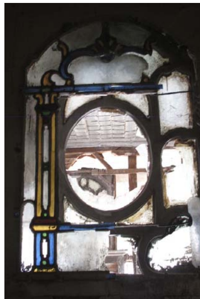
Φωτ. 386. Άποψη των γύψινων φεγγιτών του χαγιατιού με τα έγχρωμα υαλοπετάσματα.
