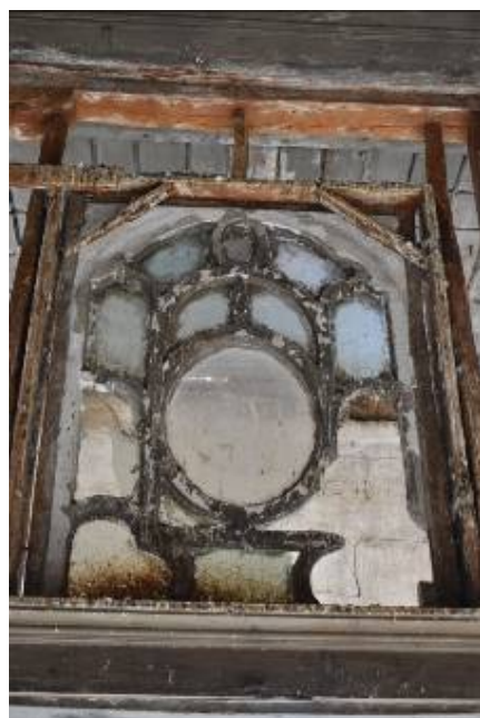
Φωτ. 128 Οι πέντε μονοί γύψινοι φεγγίτες του χαγιατιού (A2).
