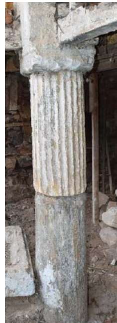
Φωτ. 373. Άποψη της αριστερής κολώνας που αναπτύσσεται κάτω από το ξύλινο κλιμακοστάσιο ανόδου στον Όροφο.
