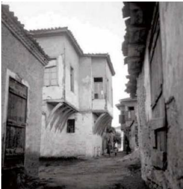
Φωτ. 1 Το στενό της οδού Παίδων, με το αρχοντικό στο κέντρο, πριν ακόμα γκρεμιστούν τα παλιά σπίτια στα δεξιά της φωτογραφίας, κλείνοντας του το «οξυγόνο».
