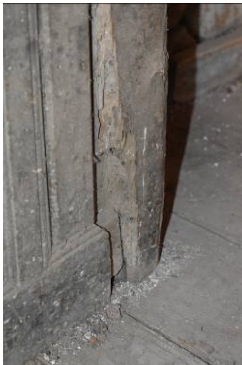
Φωτ. 227 Απώλεια ξύλινου τμήματος από τη δράση ξυλοφάγων εντόμων στη θύρα του δυτικού οντά (Α6).
