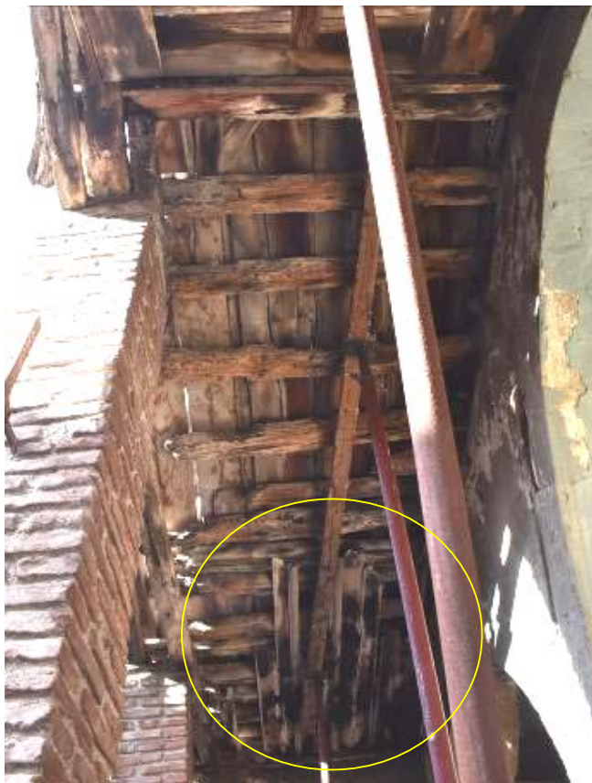
Φωτ. 37 Η οροφή του χώρου ΙΣ0. Εντός πλαισίου τα σανιδώματα που έχουν παραμείνει.
