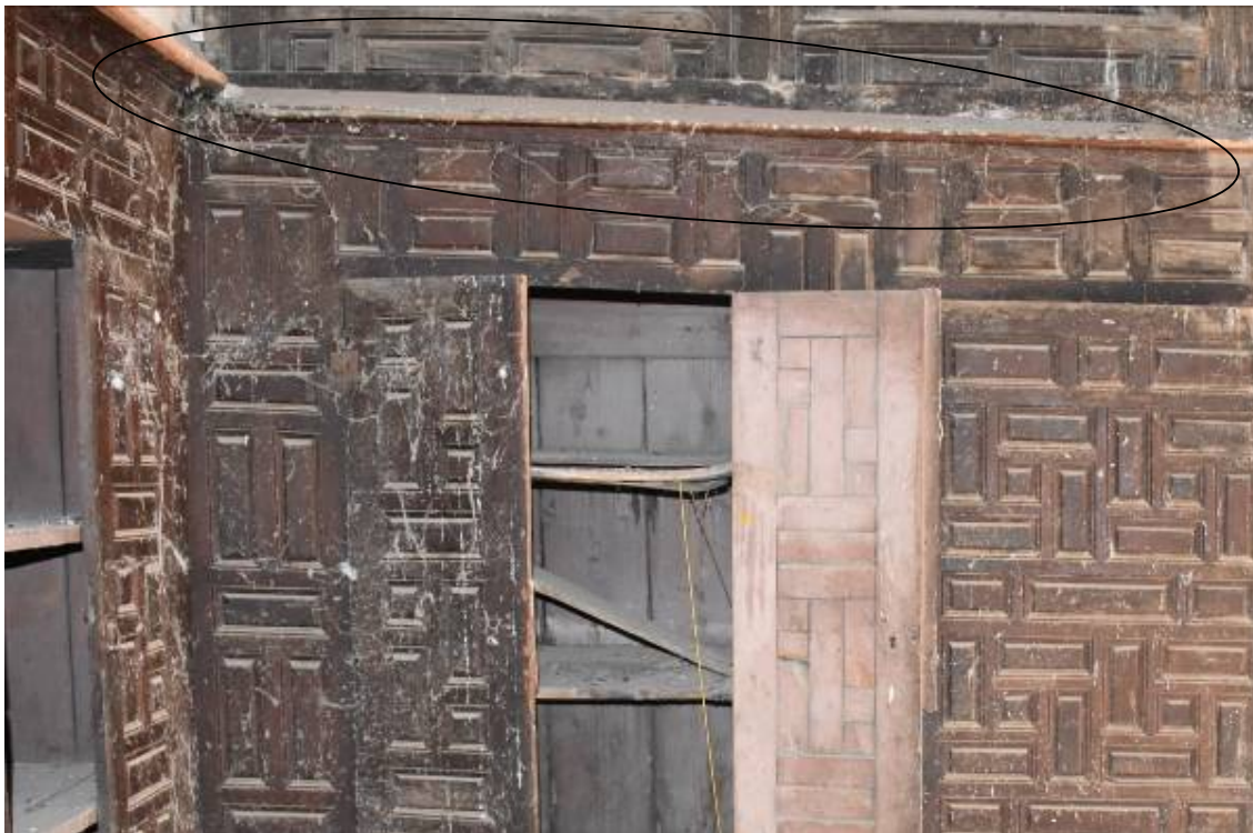
Φωτ. 102 Το ξυλόγλυπτο ράφι, το οποίο διαχωρίζει τις δύο ζώνες της μουσάντρας του δυτικού οντά (A6) και το οποίο διέτρεχε περιμετρικά όλα το δωμάτιο.
