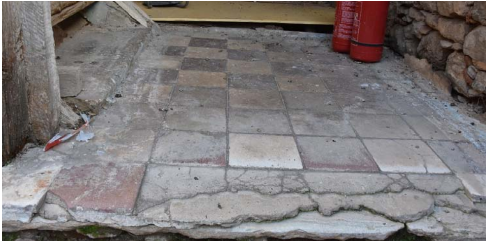
Φωτ. 379. Το δάπεδο του πλατύσκαλου του Μεσοπατώματος με τιμεντοπλακίδια λευκού και κεραμιδί-κόκκινου χρώματος σε διάταξη ζατρικίου
