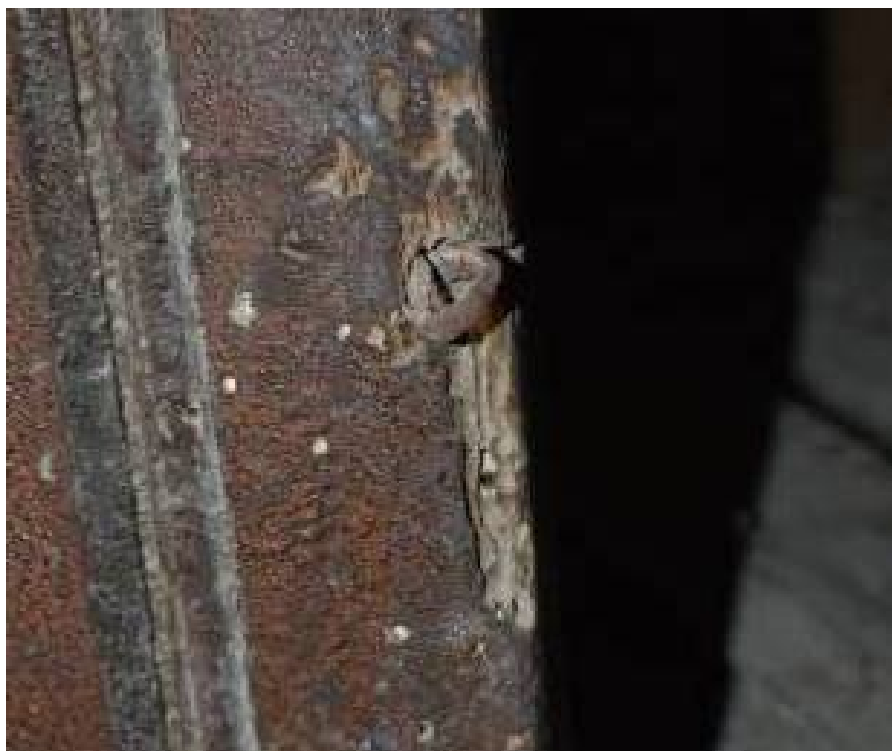
Φωτ. 248 Οξειδωμένος σύνδεσμος.
