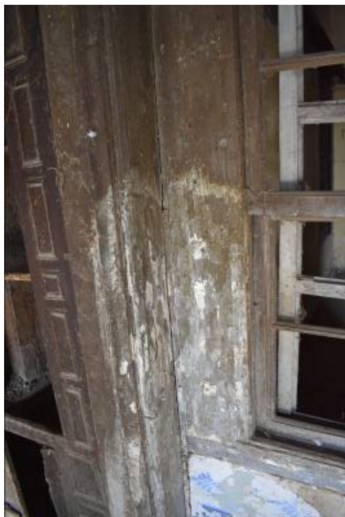
Φωτ. 262 Κάλυψη της όψης έως τη μέση με ασβεστόχρισμα.
