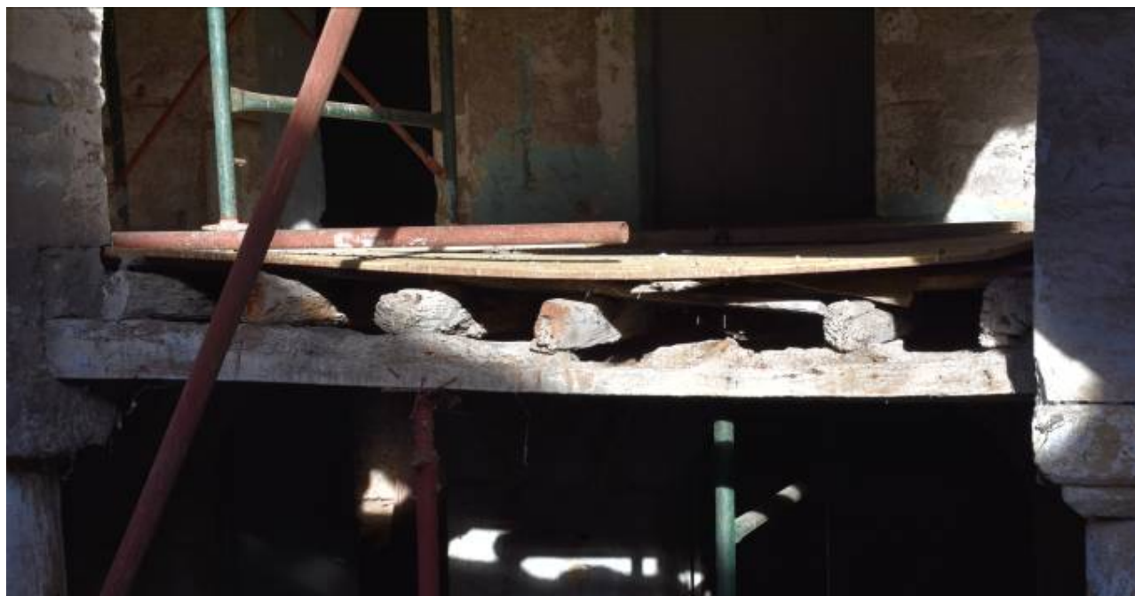
Φωτ. 125 Η κατασκευή των πατωμάτων της οικίας.
