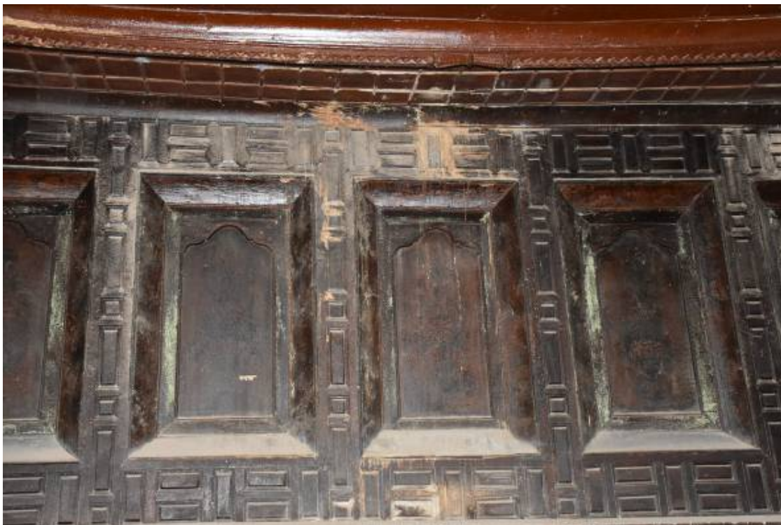
Φωτ. 253 Απώλεια χρωματικού στρώματος έως την επιφάνεια του ξύλου.
