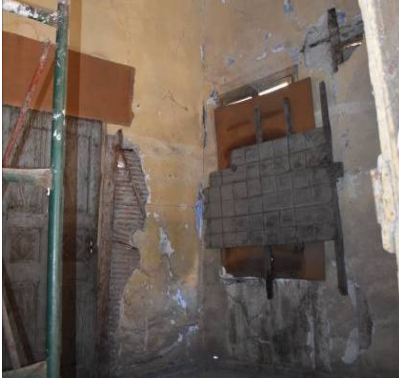
Φωτ. 235 Χρήση τμήματος οροφής και νέου ξύλου για τη σφράγιση ανοίγματος στο χώρο του σοφά (Α3).
