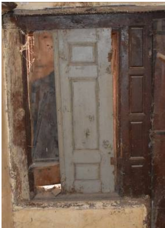
Φωτ. 234 Τοποθέτηση παλαιών ξύλινων τμημάτων πιθανώς από άλλη κατασκευή (αριστερά) και νέου πλαισίου (δεξιά) στα παράθυρα του ορτά-σοφά (A5).
