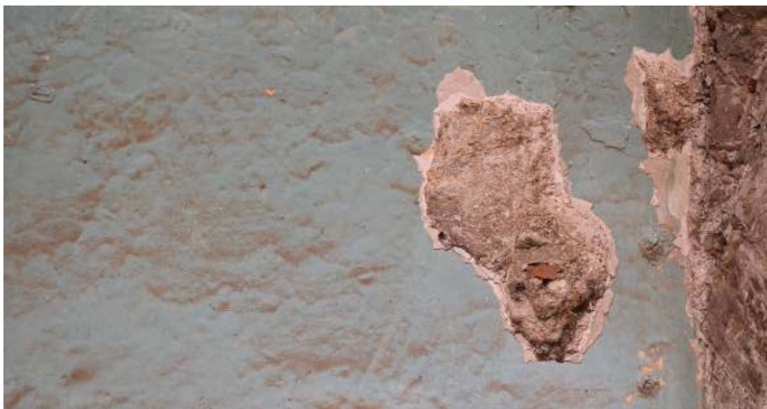
Φωτ. 145 Ο ανατολικός τοίχος του χώρου ΗΜ1 του μεσοπατώματος, όπου σώζονται και τα δύο στρώματα κονιάματος και πραγματοποιήθηκε η στρωματογραφία.
