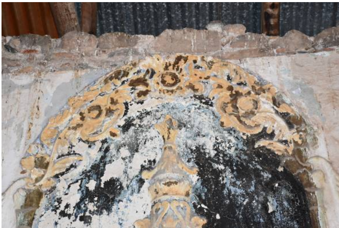
Φωτ. 134 Η τοζωτή κατάληξη του περιμετρικού πλαισίου του τζακιού με την ανάγλυφη φυτική σύνθεση.
