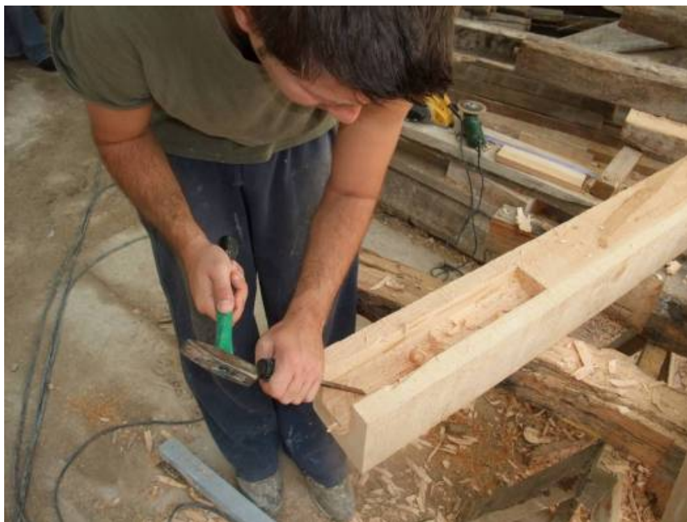
Φωτ. 341 Συμπλήρωση των δοκών.
