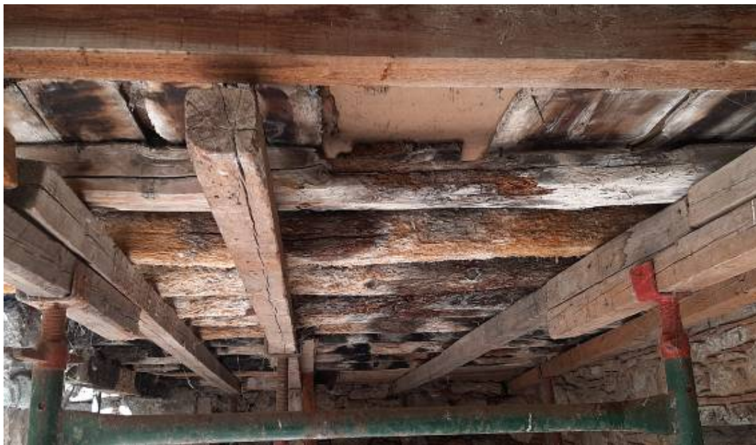
Φωτ. 124 Η κατασκευή των πατωμάτων της οικίας.
