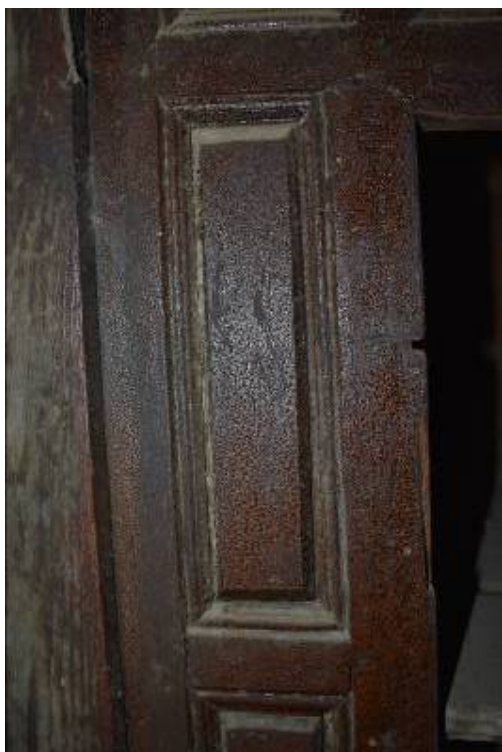
Φωτ. 256 Επικάλυψη της μουσάντρας του ανατολικού οντά (Α4) με βερνικόχρωμα. Εντός πλαισίου το δείγμα καθαρισμού που πραγματοποιήθηκε.
