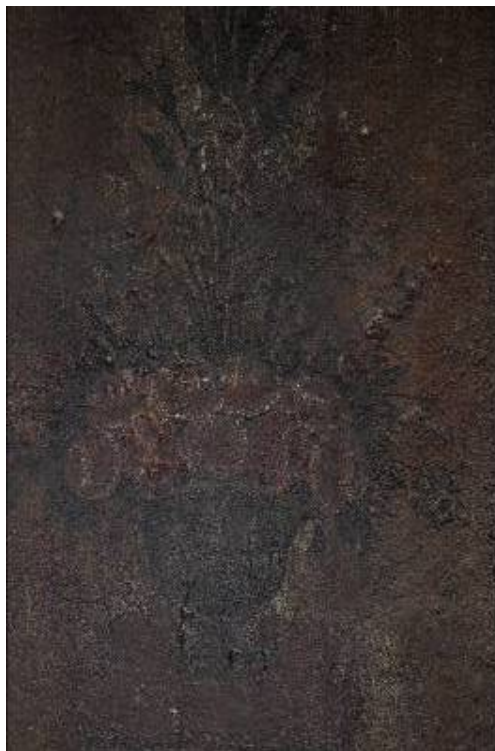
Φωτ. 255 Επικάλυψη του ζωγραφικού διακόσμου της μουσάντρας του ανατολικού οντά (Α4) με βερνικόχρωμα.
