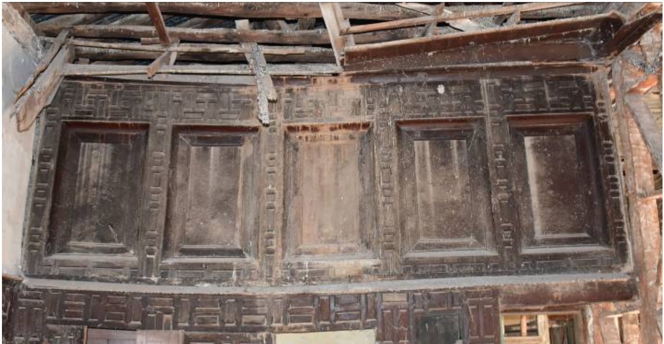
Φωτ. 100 Η άνω ζώνη της μουσάντρας του δυτικού οντά (Α6) με τις επίπεδες επιφάνειες.
