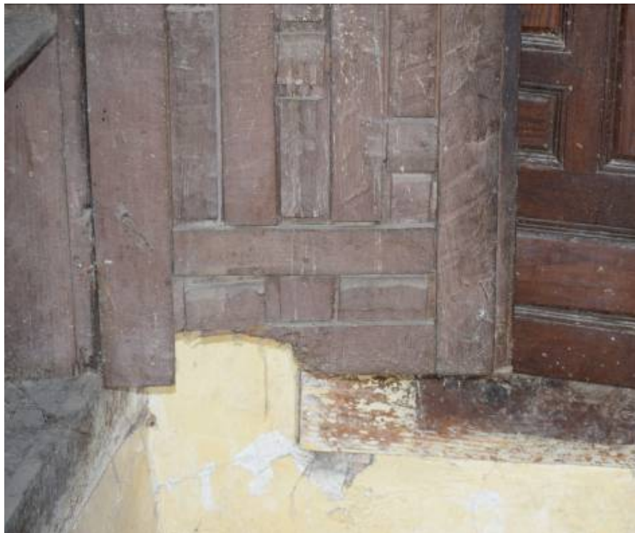
Φωτ. 268 Απώλεια ξύλινου τμήματος σε ερμαρίου του ορτά-οντά (A5).
