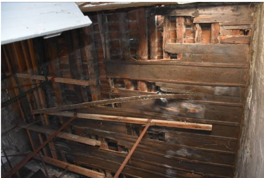
Φωτ. 45 Η οροφή του χώρου ΗΜ4.
