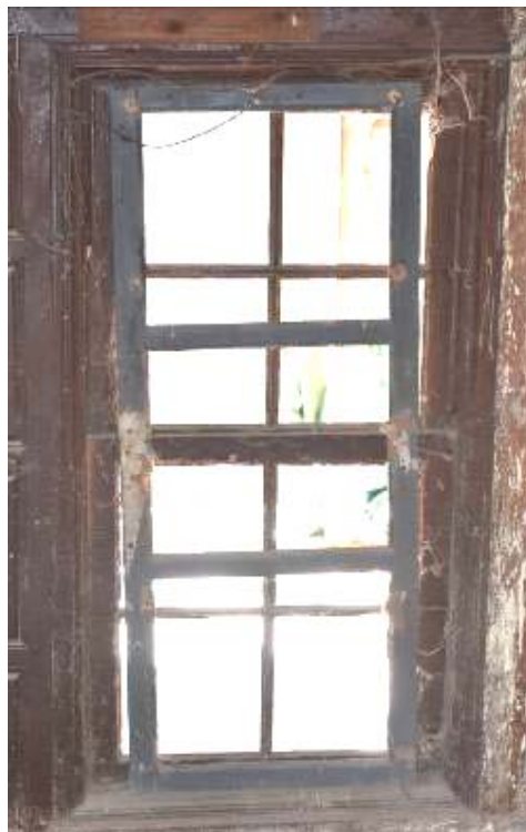
Φωτ. 234 Τοποθέτηση παλαιών ξύλινων τμημάτων πιθανώς από άλλη κατασκευή (αριστερά) και νέου πλαισίου (δεξιά) στα παράθυρα του ορτά-σοφά (A5).
