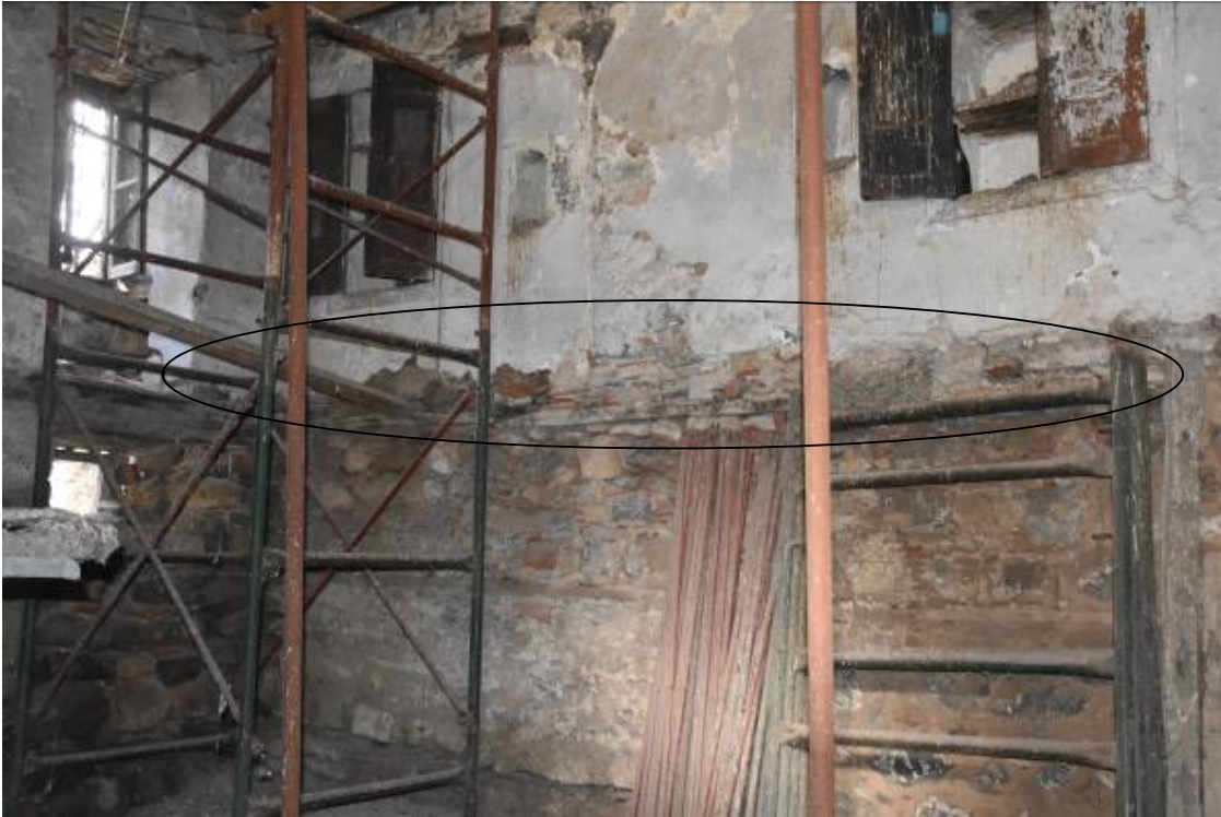
Φωτ. 303 Απώλεια των δοκών των πατωμάτων ανάμεσα στους χώρους ΙΣ3 και ΗΜ4.
