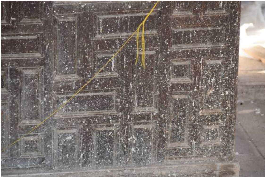
Φωτ. 251 Επικαθίσεις σκόνης, ρύπων και περιττωμάτων πτηνών.
