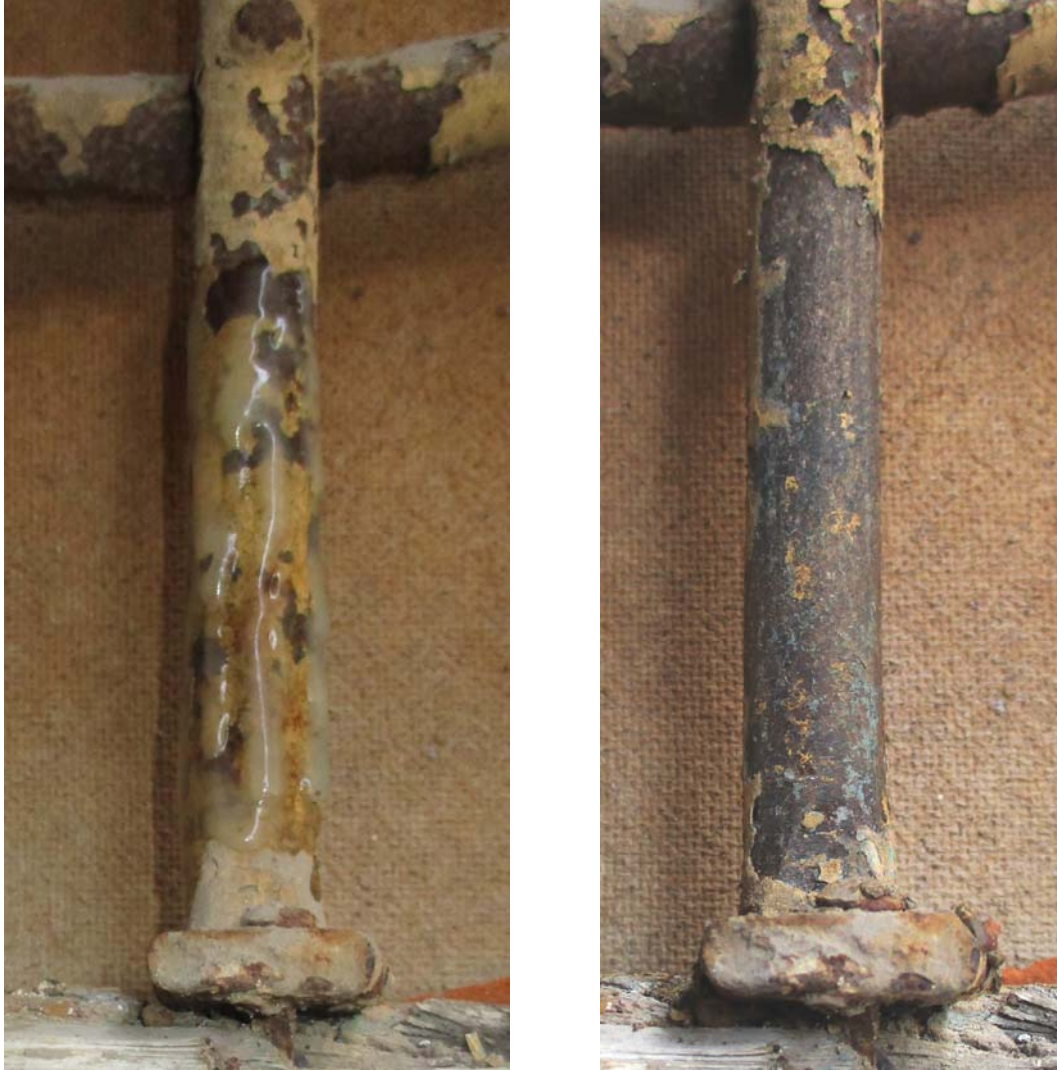
Επιφανειακός καθαρισμός με χρήση διαβρωτικού χρώματος και σταδιακή αφαίρεση με νυστέρι
