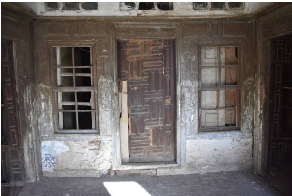
Φωτ. 261 Κάλυψη της όψης έως τη μέση με ασβεστόχρισμα.
