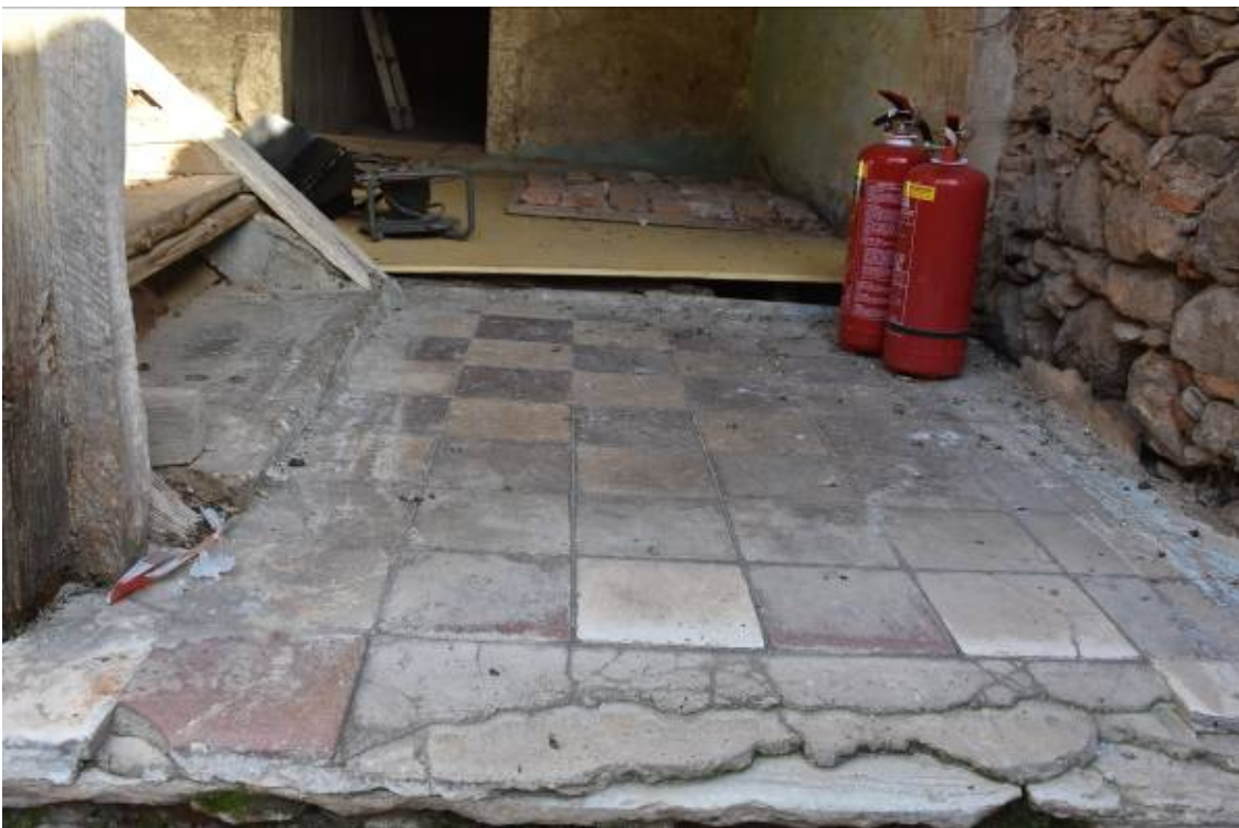
Φωτ. 15 Το τετράγωνο πλατύσκαλο (ΗΜ0) της μαρμάρινης σκάλας.
