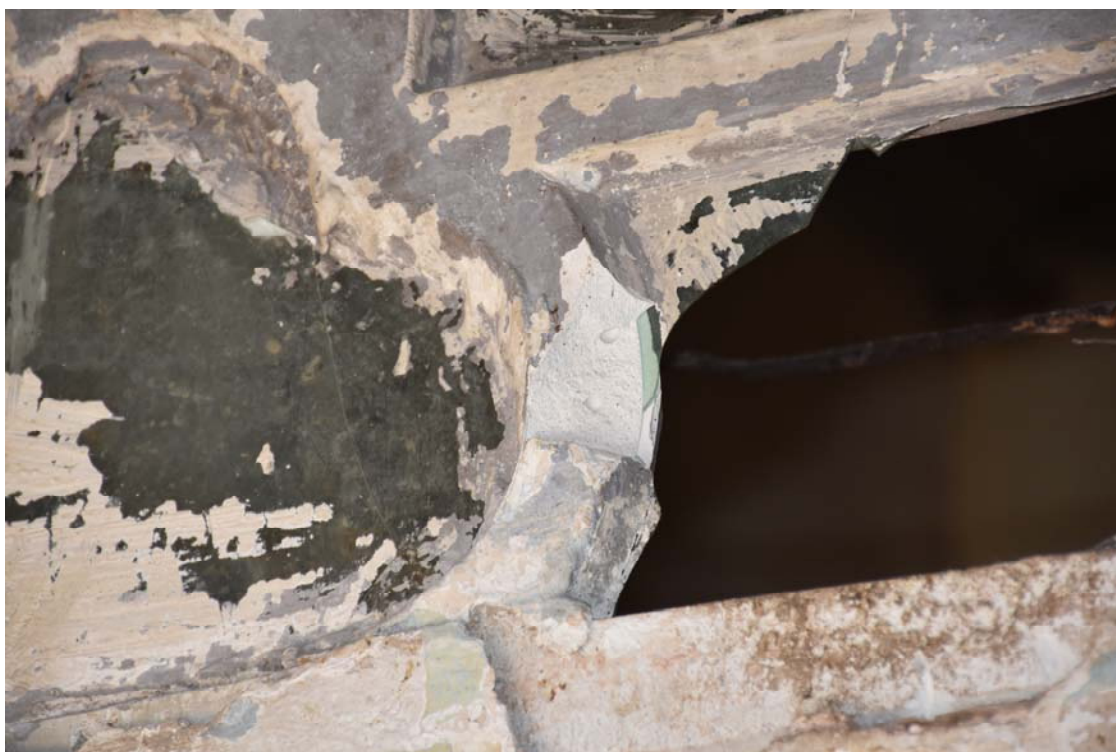
Φωτ. 316 Απώλεια του γύψινου διακοσμητικού και επιχρωματισμοί σε φεγγίτη της όψης του ορτά-σοφά (A5).
