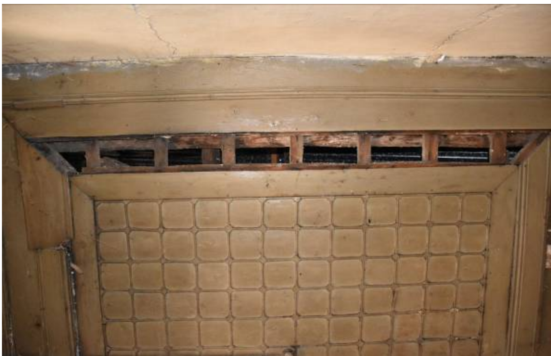
Φωτ. 182 Απώλεια τμημάτων στην οροφή του ορτά-σοφά (Α5).
