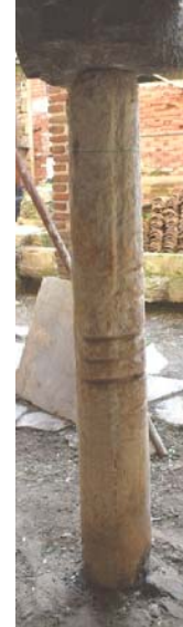
Φωτ. 372. Η οπίσθια όψη της μεσαίας κολώνας, όπου φαίνονται οι επάλληλες βαθιές εγχαράξεις.
