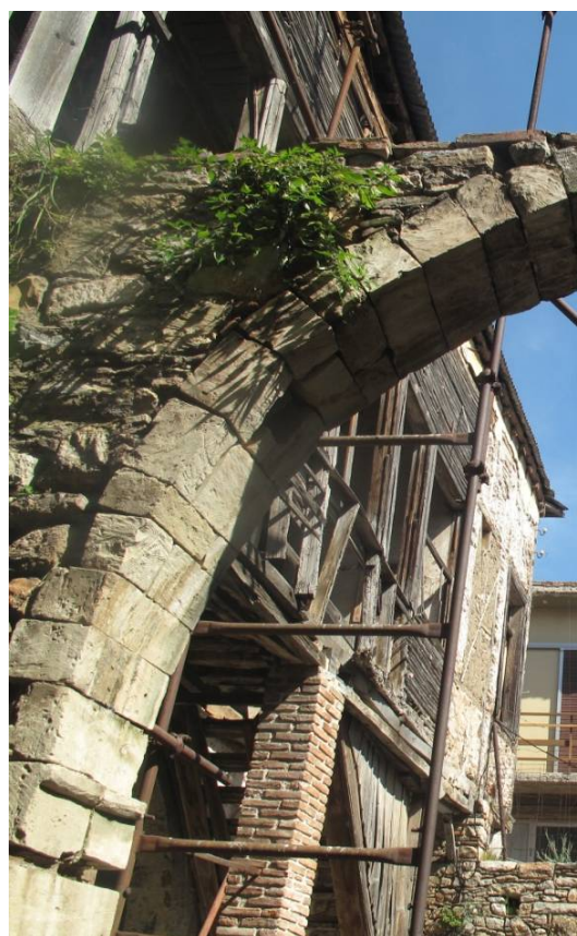
Φωτ. 409-410. Έντονο στρώμα βιολογικών επικαθίσεων τοπικά σε κάποιους λίθους και παρουσία φυτών στην αψίδα του προαύλιου χώρου.
