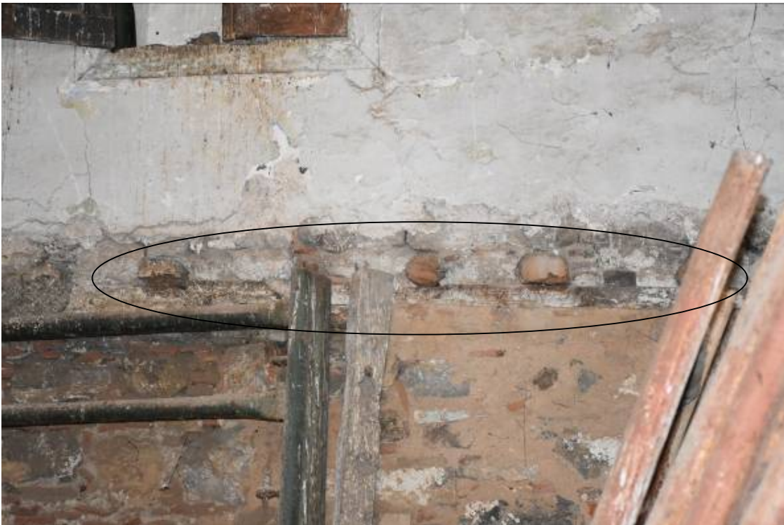
Φωτ. 304 Απώλεια των δοκών των πατωμάτων ανάμεσα στους χώρους ΙΣ3 και ΗΜ4.
