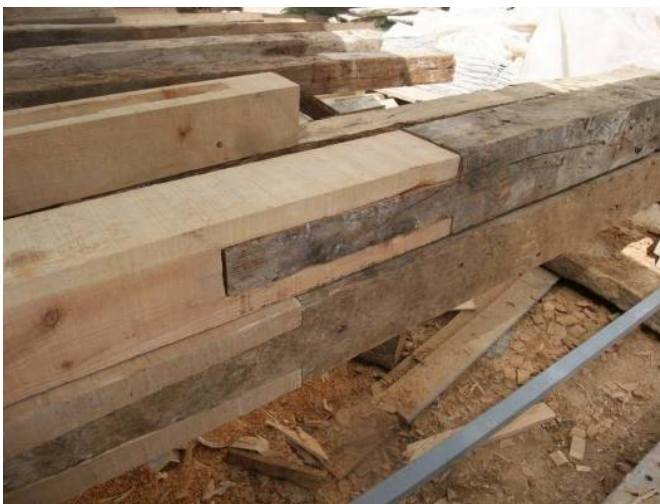
Φωτ. 344 Συμπλήρωση δοκού.
