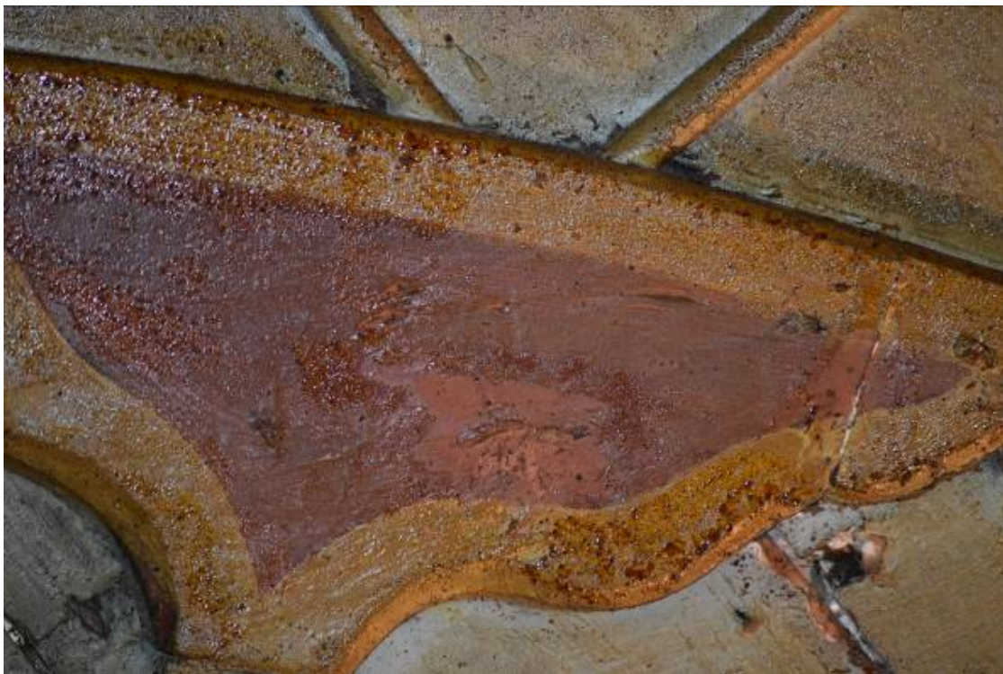
Φωτ. 203 Οξειδωμένο βερνίκι στην οροφή του ανατολικού οντά (Α4).
