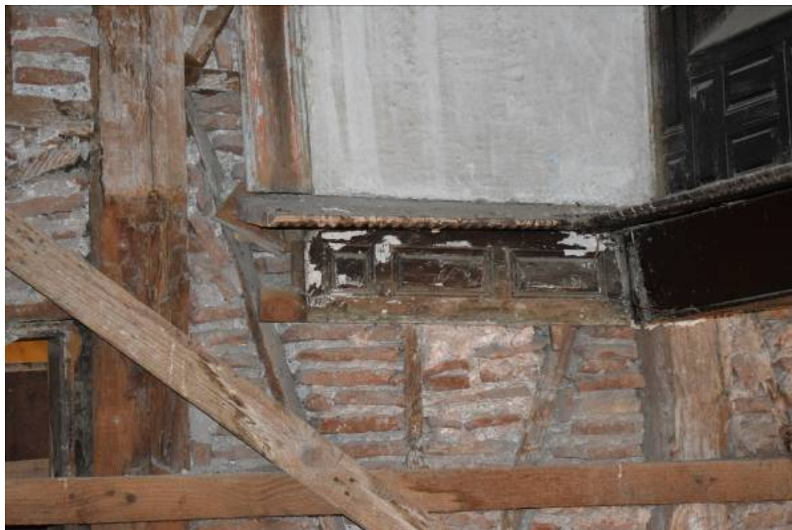
Φωτ. 97 Το ξυλόγλυπτο ράφι, το οποίο διαχωρίζει τις δύο ζώνες της μουσάντρας του ανατολικού οντά (A4) και το οποίο διέτρεχε περιμετρικά όλα το δωμάτιο.
