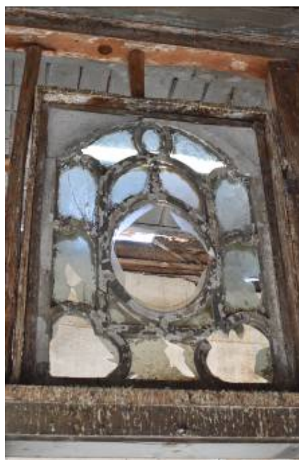
Φωτ. 128 Οι πέντε μονοί γύψινοι φεγγίτες του χαγιατιού (A2).
