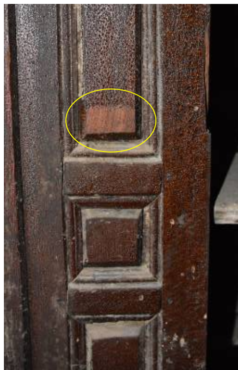
Φωτ. 256 Επικάλυψη της μουσάντρας του ανατολικού οντά (Α4) με βερνικόχρωμα. Εντός πλαισίου το δείγμα καθαρισμού που πραγματοποιήθηκε.
