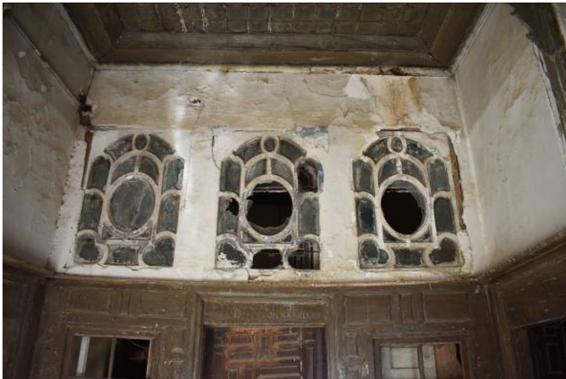
Φωτ. 129 Οι τρεις διπλοί γύψινοι φεγγίτες της όψης του ορτά-οντά (A5).
