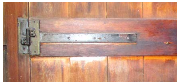
Φωτ. 396-398. Τα μεταλλικά στοιχεία της αυλόθυρας διατηρούν διαδοχικά στρώματα βαφής με απολεπίσεις και απώλειες και οξείδωση της βαφής.
