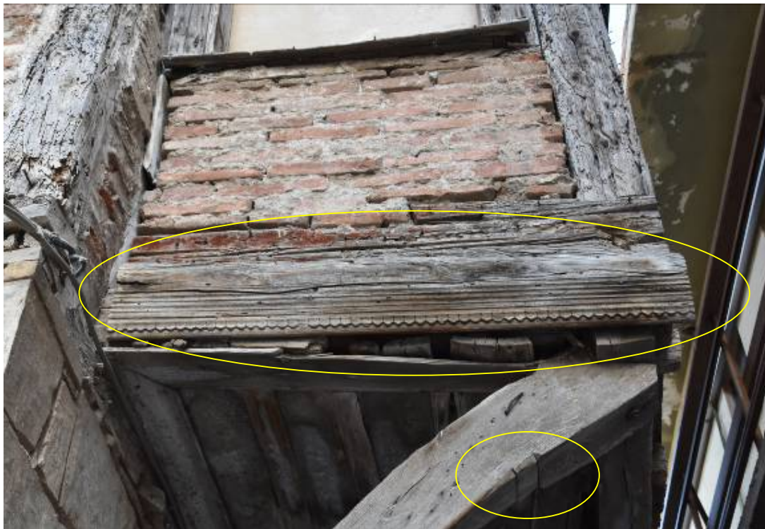
Φωτ. 123 Εγχάρακτη και ξυλόγλυπτη διακόσμηση της κορνίζας και των αντηρίδων των σαχνισιών.
