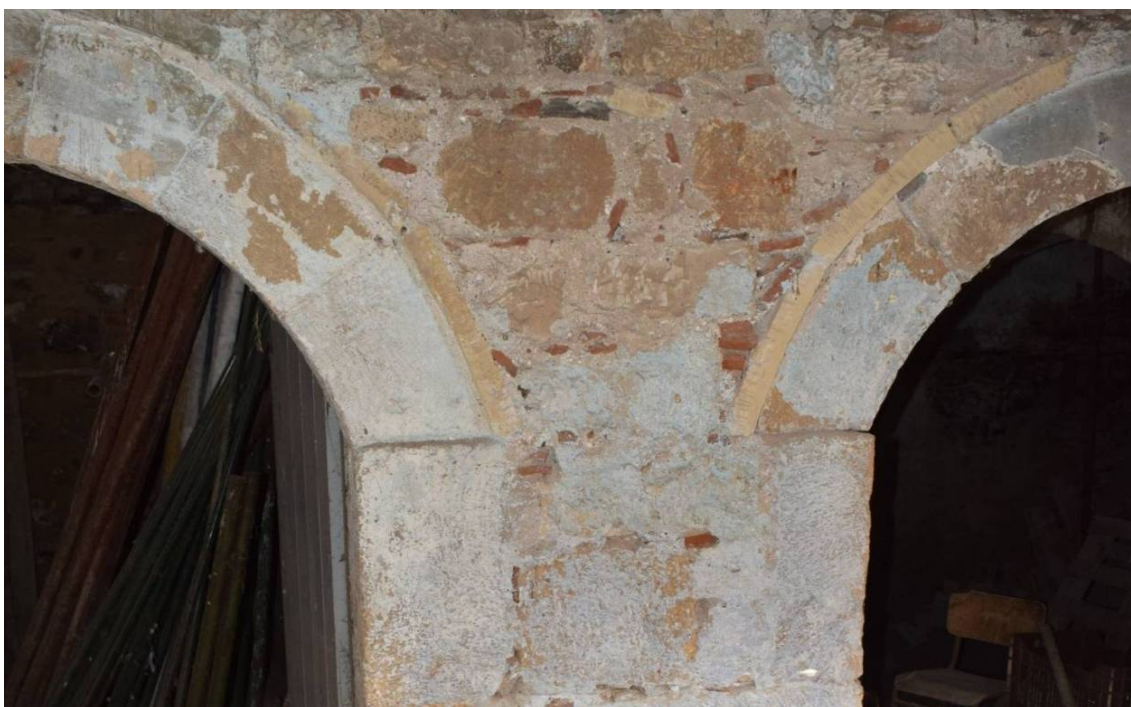
Φωτ. 427. Επιφανειακό επίστρωμα κονιάματος (βαφή) στο τοξωτό ανώφλι των θυρών του ισογείου, που έχει μερικώς φθαρεί και δημιουργεί αρνητικό αισθητικό αποτέλεσμα.
