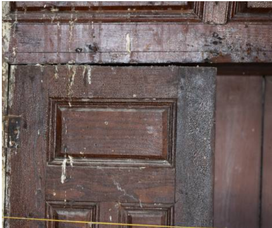
Φωτ. 275 Επικαθίσεις περιττωμάτων πτηνών σε ερμάριο του ορτά-σοφά (A5).
