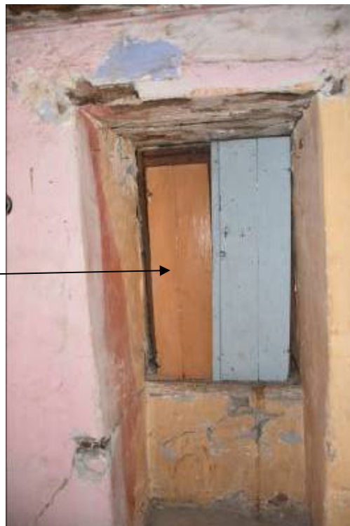
Φωτ. 266 Απώλεια φύλλου ερμαρίου του χώρου ΗΜ2 και η τοποθέτησή του σε παράθυρο.
