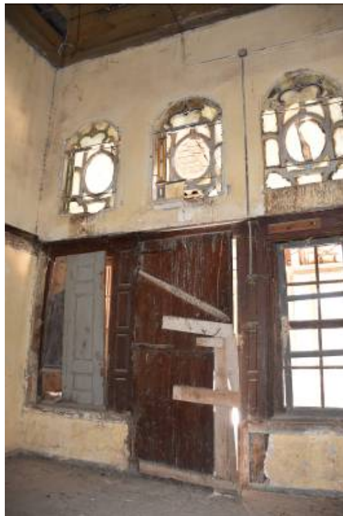
Φωτ. 27 Άποψη του ορτά- σοφά (A5) του ορόφου.
