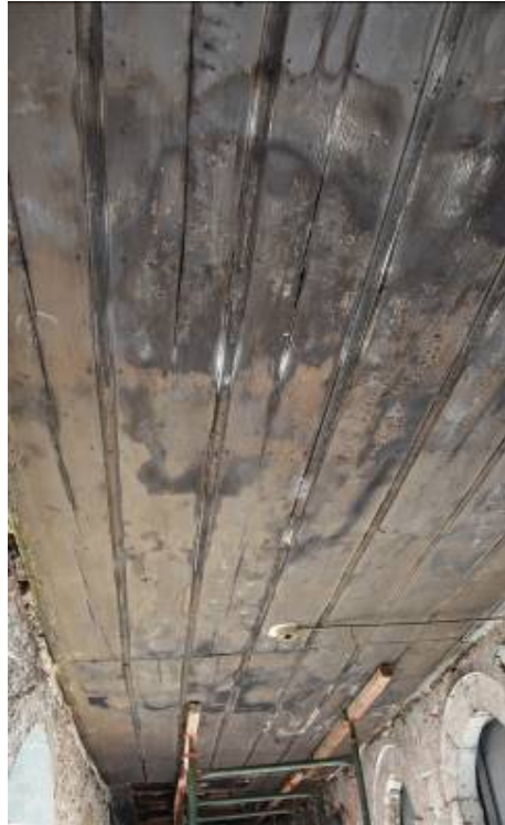
Φωτ. 42 Η οροφή του χώρου ΗΜ1.
