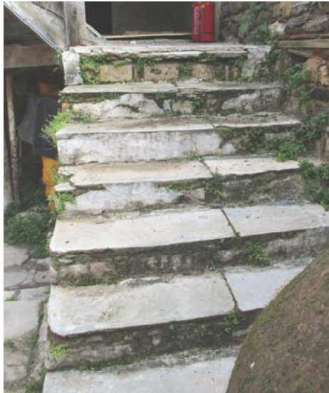
Φωτ. 359. Το κλιμακοστάσιο πρόσβασης στο Μεσοπάτωμα.
