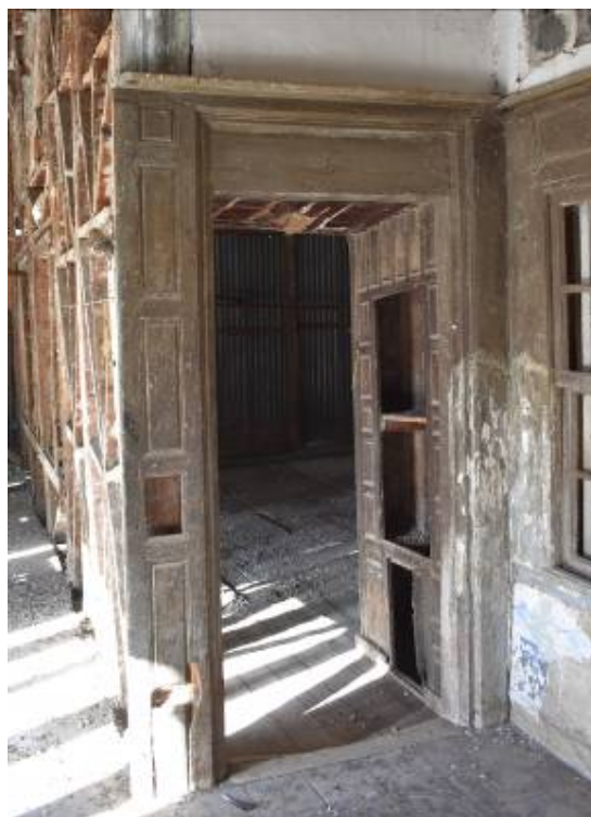
Φωτ. 105 Η είσοδος του δυτικού οντά (A6).
