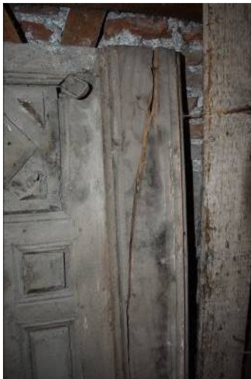
Φωτ. 247 Ρωγμάτωση σε φύλλο μουςάντρας.
