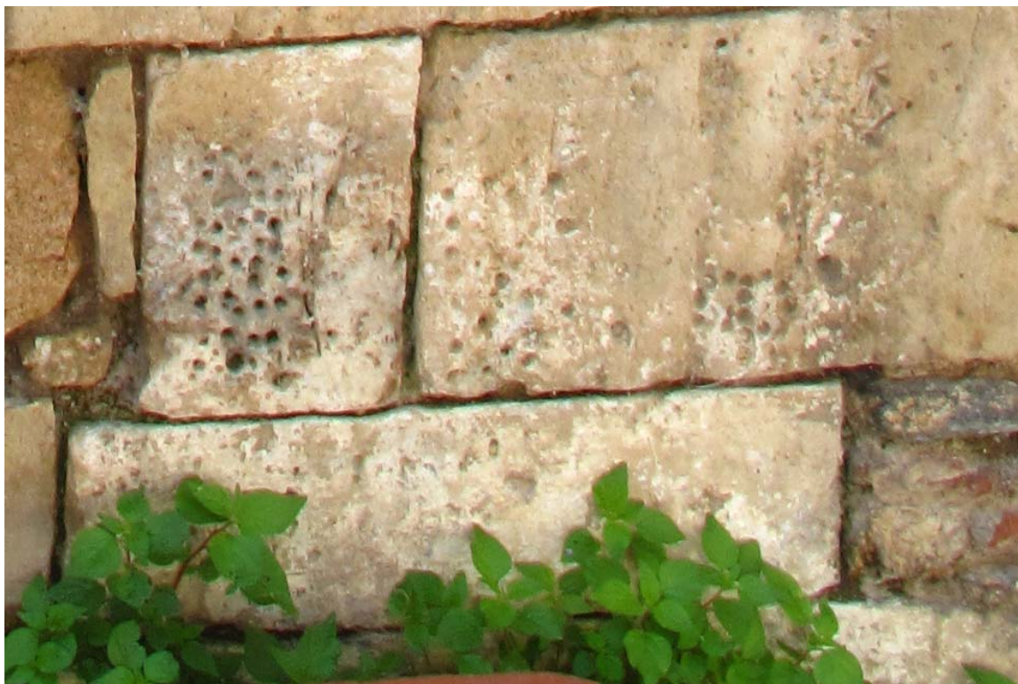
Φωτ. 415. Κυψελοειδής διάβρωση σε κάποιους απο τους μαρμαρινους λίθους της αυλόθυρας.
