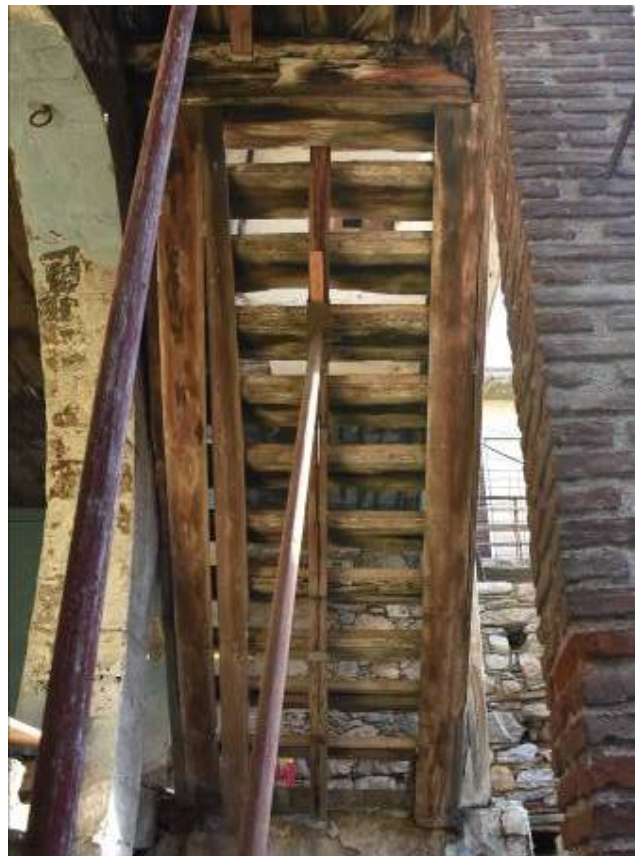
Φωτ. 115 Η πίσω όψη της ξύλινης κλίμακας.
