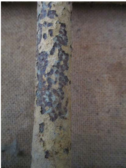
Φωτ. 392-393. Λεπτομέρεια των μεταλλικών στοιχείων στο πλέγμα των παραθύρων. Τα βαμμένα μεταλλικά στοιχεία παρουσιάζουν απώλεια της χρωματικής επιφάνειας λόγω της διόγκωσης των προϊόντων διάβρωσης του σιδήρου.
