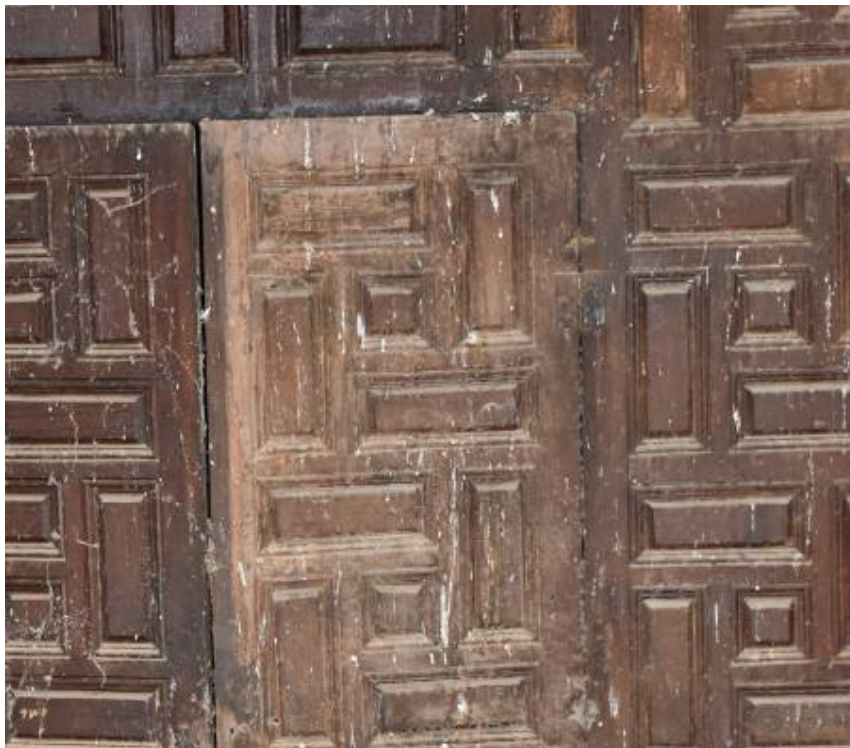
Φωτ. 276 Απώλεια χρωματικού στρώματος έως την επιφάνεια του ξύλου σε ερμάριο του δυτικού οντά (Α6).
