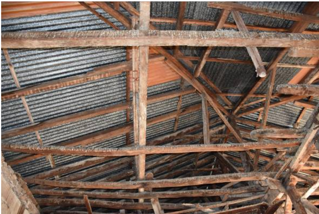
Φωτ. 117 Τμήμα της στέγης.
