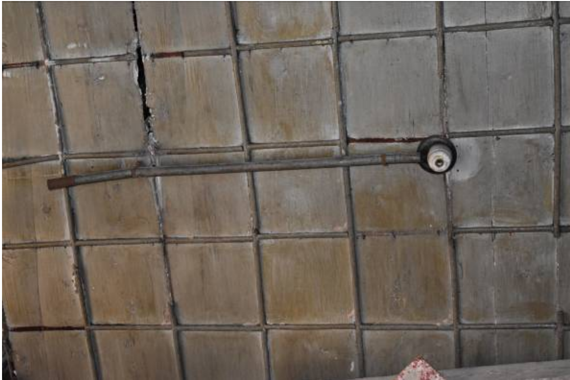
Φωτ. 195 Τοποθέτηση καλωδιώσεων για την παροχή ηλεκτρικού ρεύματος στην οροφή του εξώστη (A1).
