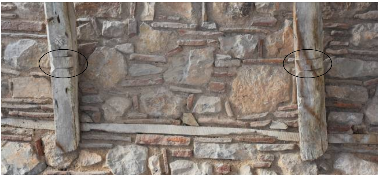
Φωτ. 121 Εγγάρκτη διακόσμηση των αντηρίδων των σαχνισιών.
