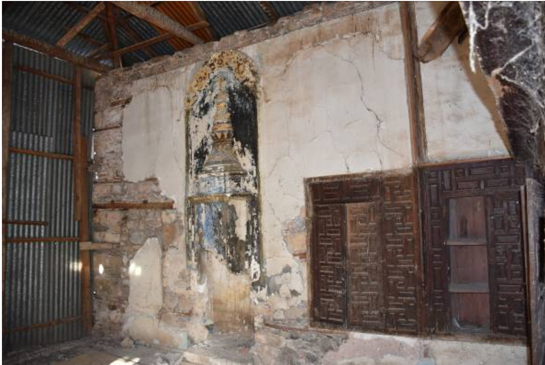
Φωτ. 30 Άποψη του δυτικού οντά (Α6) του ορόφου.
