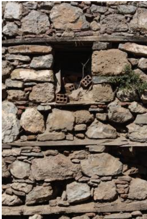
Φωτ. 34 Η τοιχοποιία του ισογείου και του μεσοπατώματος με τις οριζόντιες ξυλοδεσιές.
