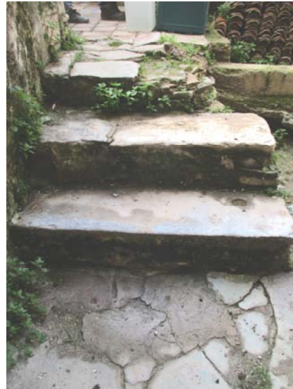
Φωτ. 360. Το τρίβαθμο κλιμακοστάσιο πρόσβασης στο υποβαθμισμένο υψομετρικά χώρο της αυλής.
