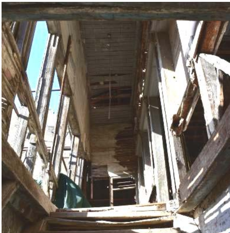
Φωτ. 21 Άποψη του εξώστη (A1) του ορόφου.
