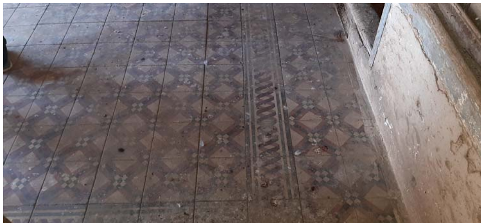
Φωτ. 387. Το νεοκλασικό δάπεδο από τσιμεντοπλακίδια του χαγιατιού
