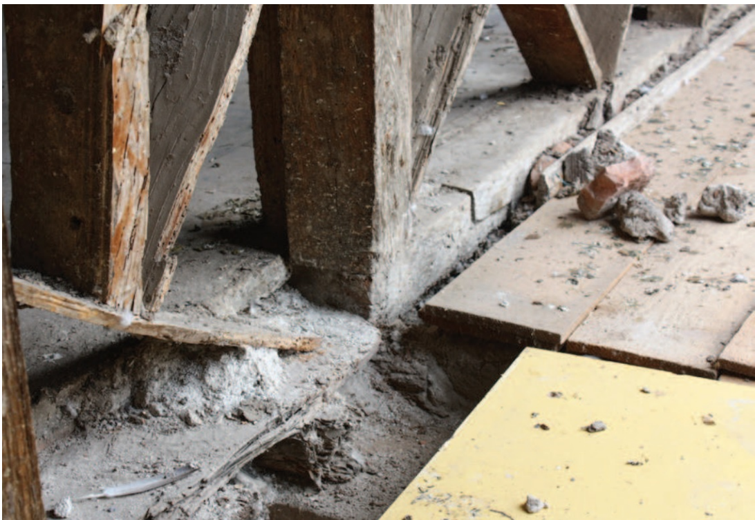
Φωτ. 75 Περιοχή του χαγιατιού (Α2) όπου εντοπίστηκαν ίχνη από παλαιότερο ξύλινο δάπεδο.
