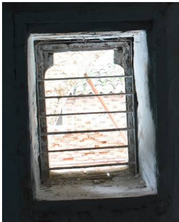
Φωτ. 85 Το παράθυρο του νότιου τείχους του χώρου ΗΜ3.
