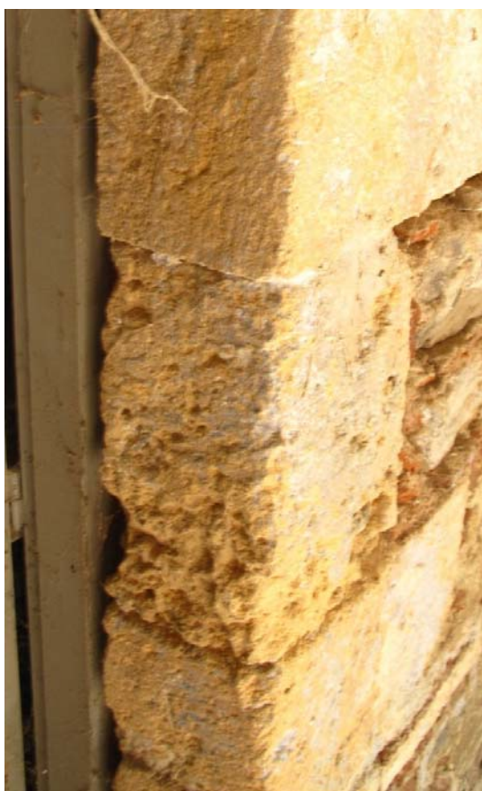
Φωτ. 440-441. Καταπονημένοι και διαβρωμένοι λίθοι σε τοιχοποιία αλλά και στο κλιμακοστάσιο.
