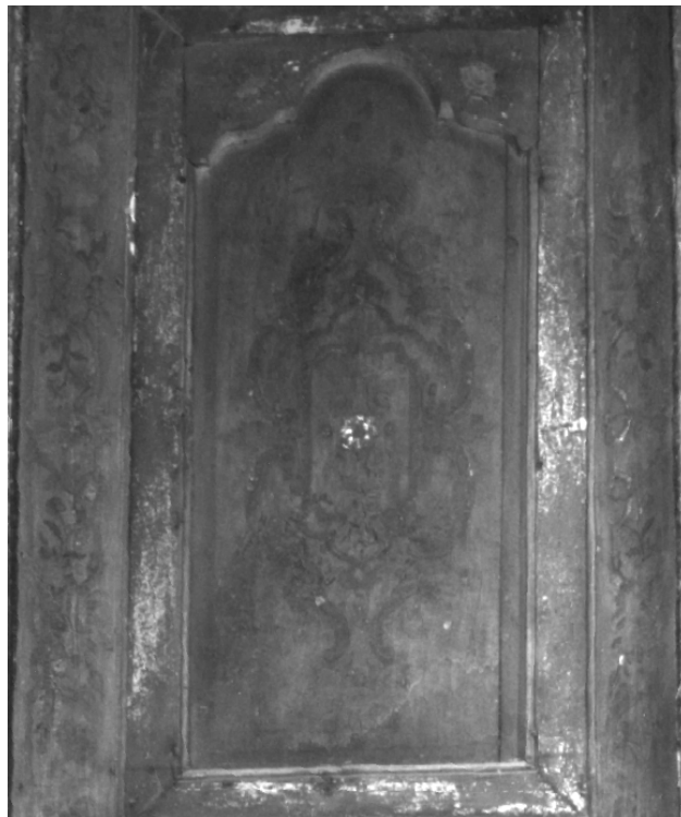
Φωτ. 158 Φωτογράφιση με το σύστημα Mysis στα 1000nm (IR, υπέρυθρο) στο οποίο διακρίνονται οι λεπτομέρειες της ζωγραφικής του πρώτου άνω ταμπλά της μουσάντρας του ανατολικού οντά.
