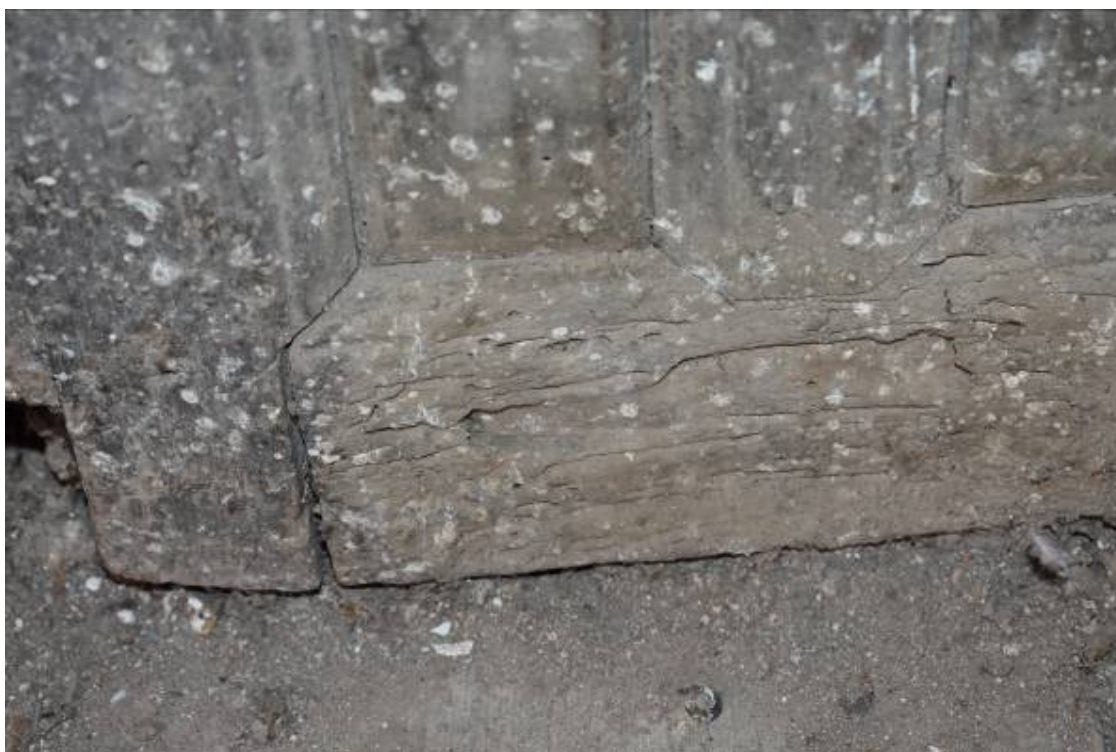
Φωτ. 228 Απώλεια ξύλινου τμήματος από τη δράση ξυλοφάγων εντόμων στη θύρα του δυτικού οντά (Α6).
