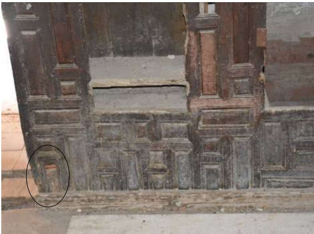
Φωτ. 244 Απώλειες ξύλινων τμημάτων στη μουσάντρα του ανατολικού οντά (A4).
