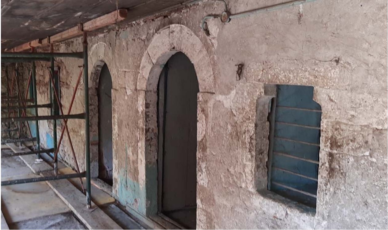
Φωτ. 331 Ο βόρειος τοίχος του χώρου ΗΜ1, όπου σώζεται το αυθεντικό εσωτερικό κονίαμα.
