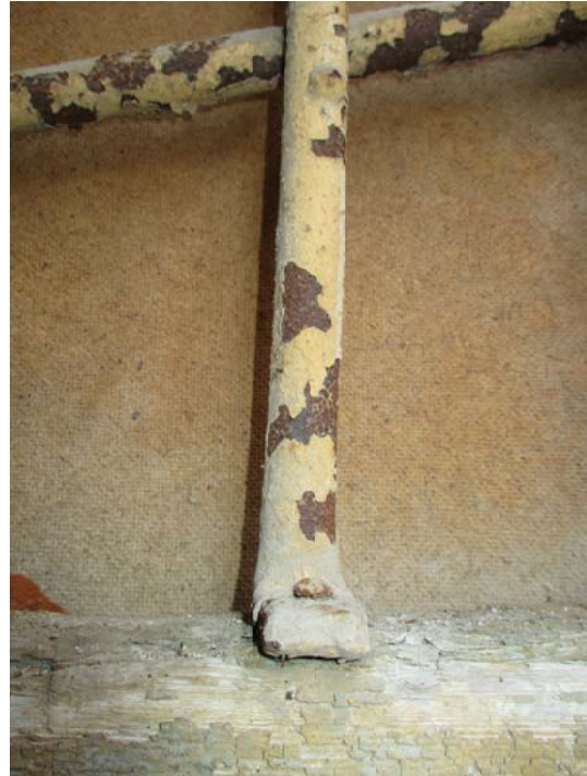
Φωτ. 394-395. Μεταλλικό πλέγμα παραθύρου και η λεπτομέρεια του, όπου διακρίνονται επικαθίσεις και οξείδωση της μεταλλικής επιφάνειας, αλλά και στρέβλωση του σχήματος των μεταλλικών ράβδων λόγω μηχανικής καταπόνησης.
