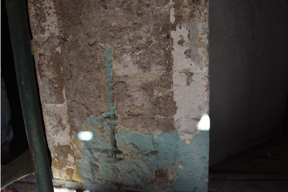
Φωτ. 339 Ασβεστοχρίσματα και επιχρωματισμοί στα κατώτερα μέρη του βόρειου τοίχου.
