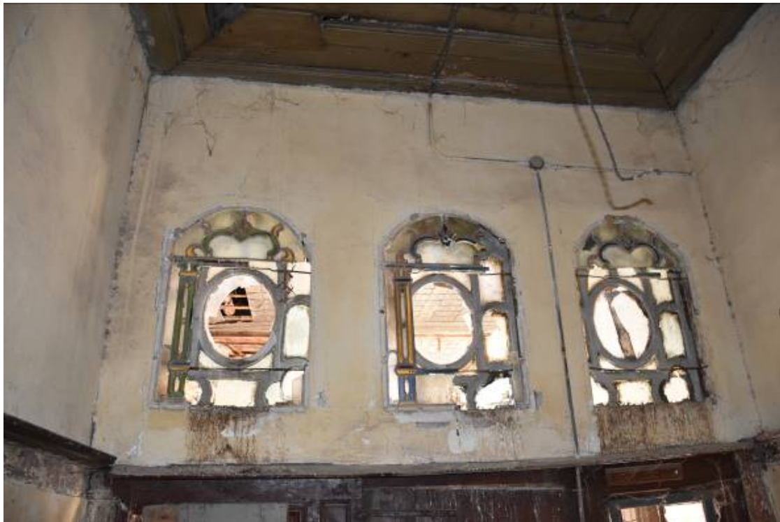
Φωτ. 131 Η πίσω πλευρά των τριών διπλών γύψινων φεγγιτών, όπως φαίνονται από το χώρο του ορτά-οντά (A5).
