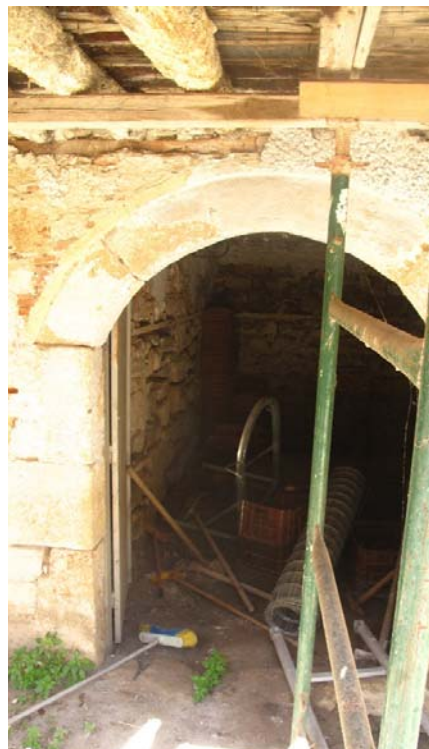
Φωτ. 378. Η είσοδος του ανατολικού δωματίου του Ισογείου με το λαξευμένο καμπύλο ανώφλι.
