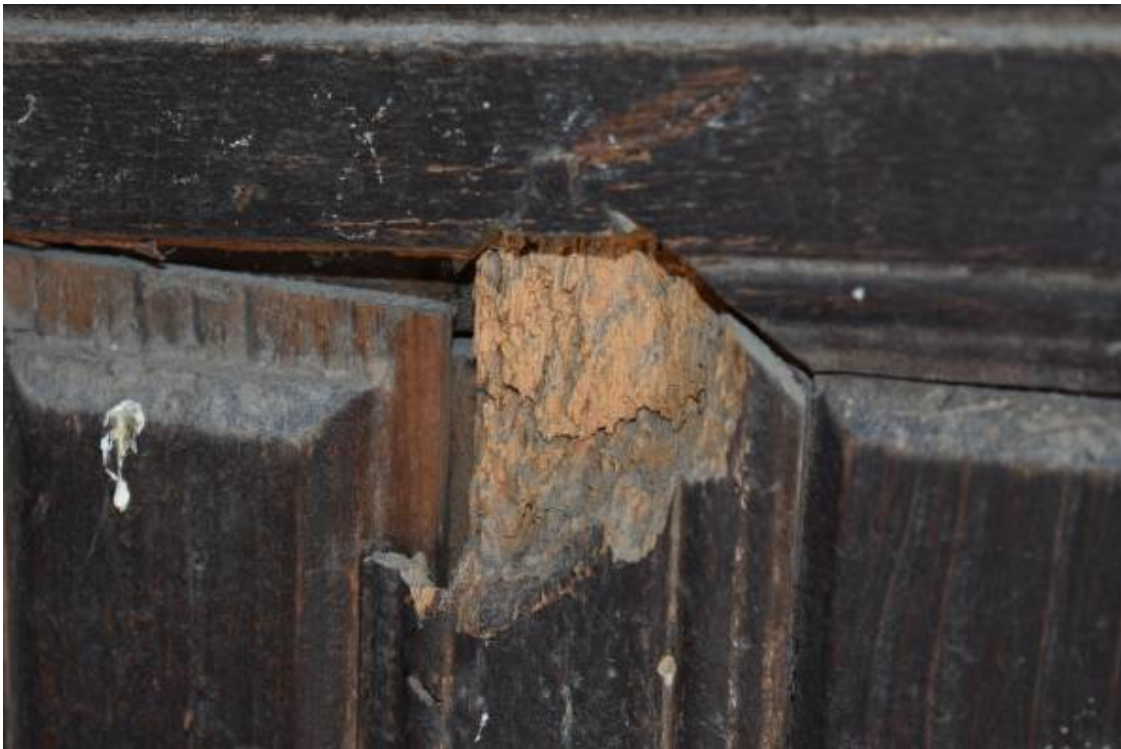
Φωτ. 226 Απώλεια ξύλινου τμήματος από τη δράση ξυλοφάγων εντόμων στη θύρα του δυτικού οντά (Α6).
