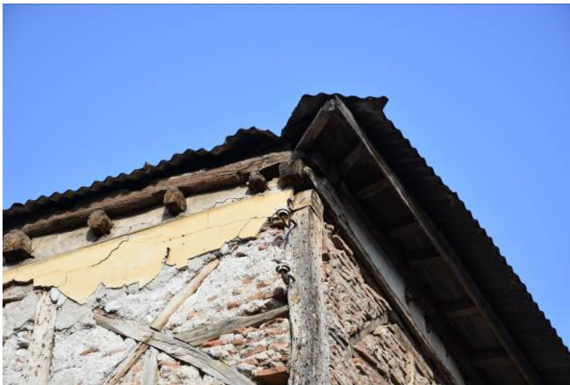
Φωτ. 126 Το κομμένο γείσο της οικίας, σύμφωνα με τη νεοκλασική αρχιτεκτονική.
