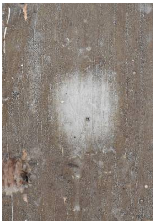
Φωτ. 264 Νεότερα βερνικοχρώματα καλύπτουν το αρχικό χρωματικό στρώμα της όψης του ορτά-σοφά (Α5). Δεξιά το δείγμα αποκάλυψης του αρχικού χρωματικού στρώματος.
