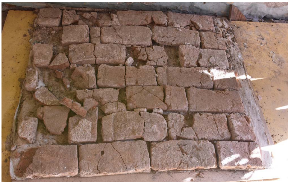
Φωτ. 381. Αποσπασμένα κεραμικά πλακίδια στην ανατολική γωνία του ημιυπαίθριου χώρου του Μεσοπατώματος.
