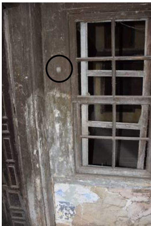
Φωτ. 264 Νεότερα βερνικοχρώματα καλύπτουν το αρχικό χρωματικό στρώμα της όψης του ορτά-σοφά (Α5). Δεξιά το δείγμα αποκάλυψης του αρχικού χρωματικού στρώματος.
