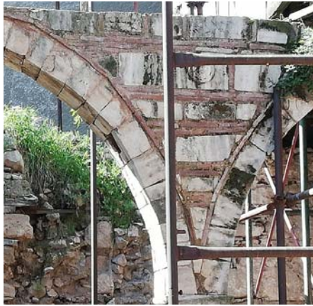
Φωτ. 363. Το σφαιρικό τρίγωνο μεταξύ των δύο τόξων, όπου φαίνονται τα υλικά κατασκευής της τοξοστοιχίας (μάρμαρο και πλίνθοι)
