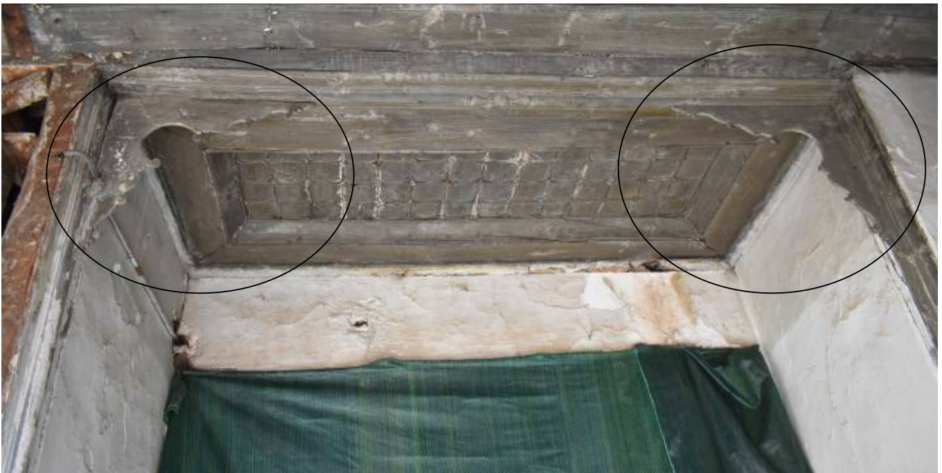
Φωτ. 51 Οι γωνιακοί «ντηλιακοί» που είναι τοποθετημένοι ανάμεσα στο ταβάνι της εισόδου του ορτά-σοφά και του χαγιατιού.
