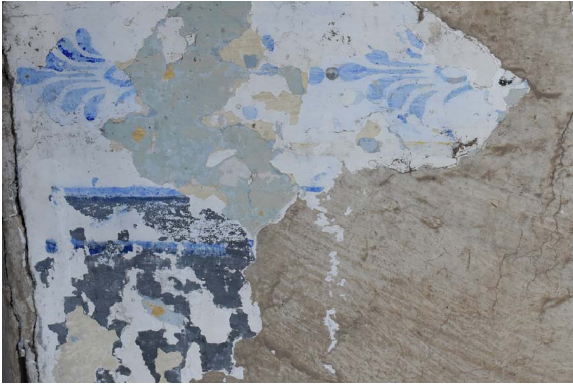
Φωτ. 328 Επάλληλοι επιχρωματισμοί και ασβεστοχρίσματα στην επιφάνεια της τοιχογραφίας.
