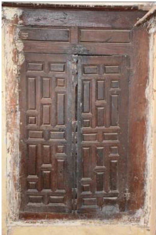
Φωτ. 278 Επιχρωματισμοί περιμετρικά ερμαρίου του ορτά-σοφά (Α5).
