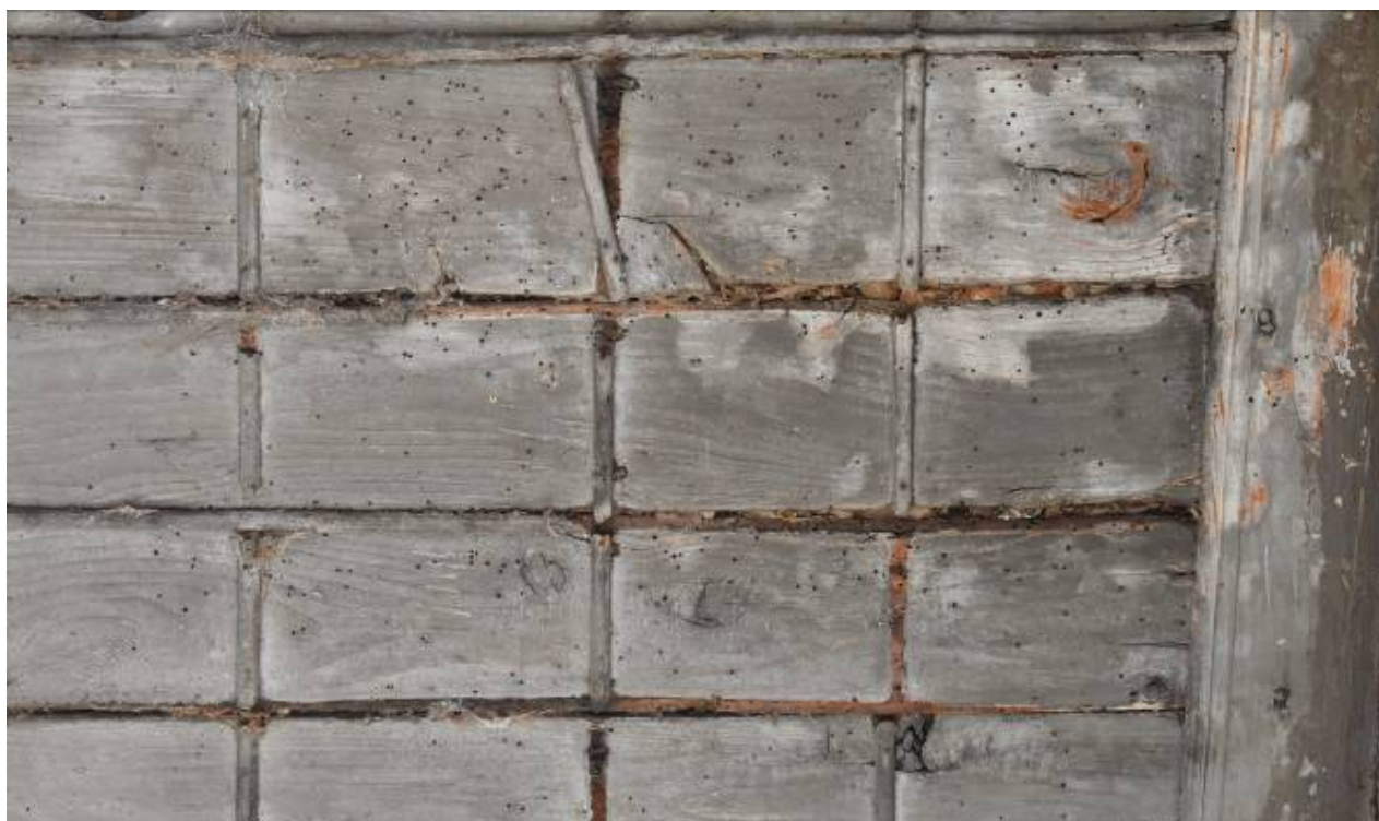
Φωτ. 186 Απώλεια ξύλινων τμημάτων από τη δράση των ξυλοφάγων εντόμων στην οροφή του χαγιατιού (A2).
