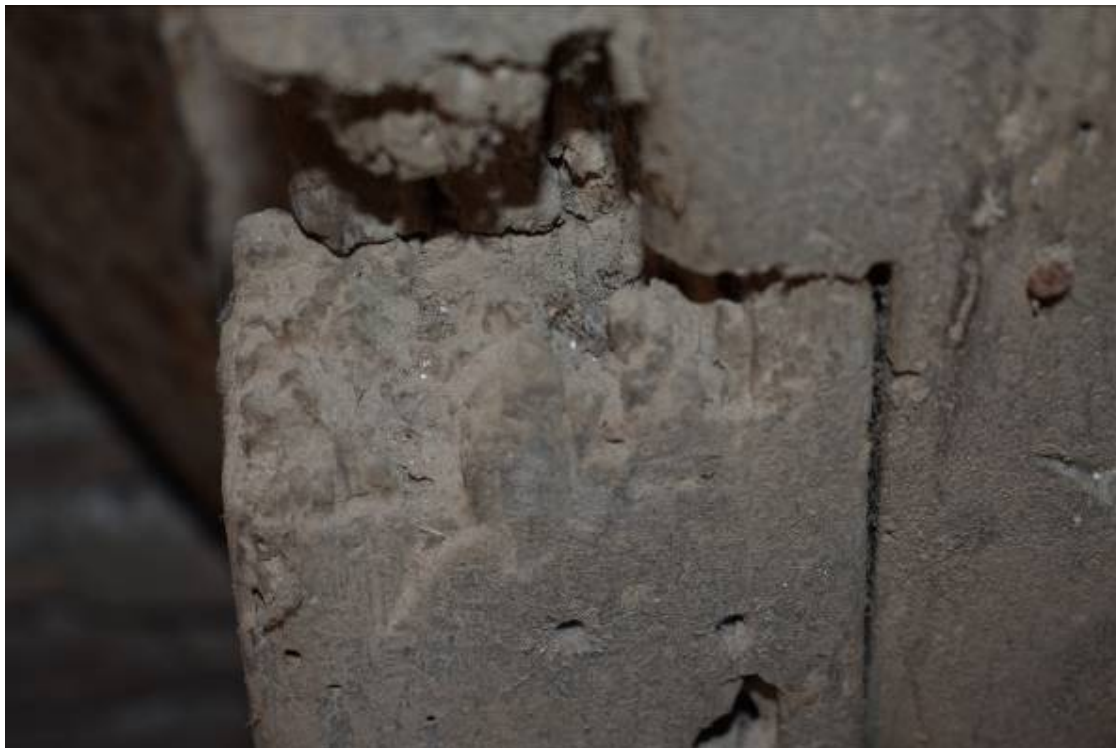
Φωτ. 229 Απώλεια ξύλινου τμήματος από τη δράση ξυλοφάγων εντόμων στη θύρα του δυτικού οντά (Α6).
