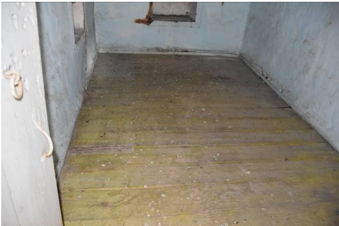
Φωτ. 69 Το δάπεδο του χώρου ΗΜ3.
