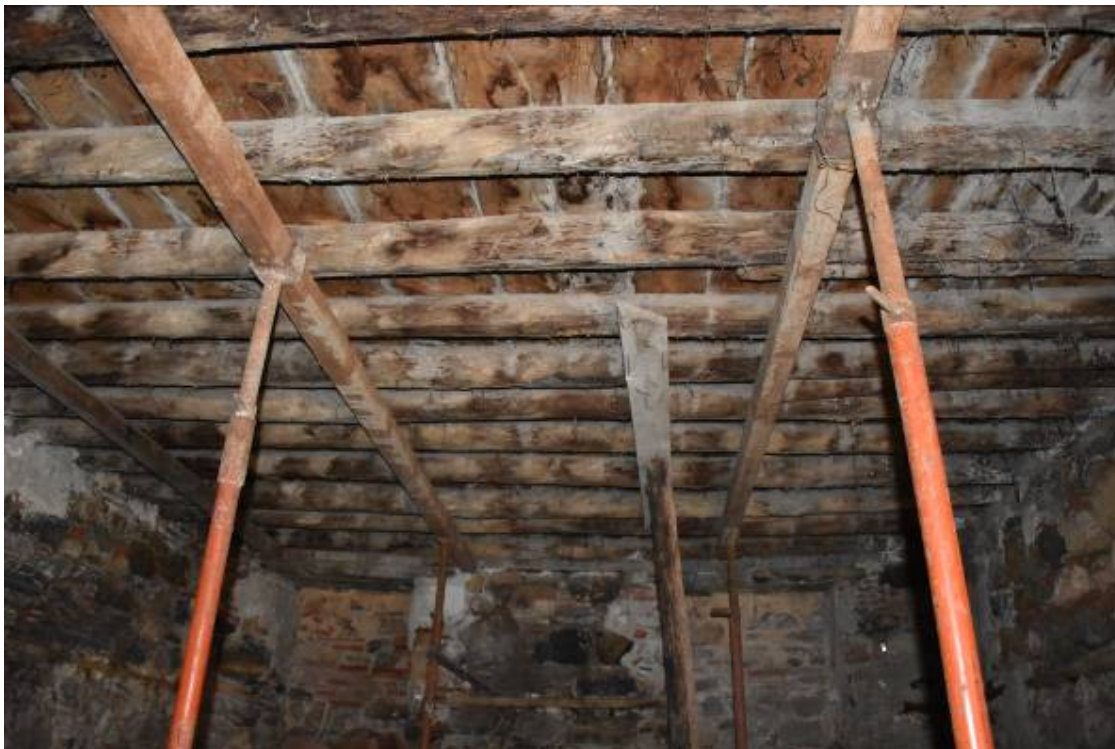
Φωτ. 39 Η οροφή του χώρου ΙΣ2α.
