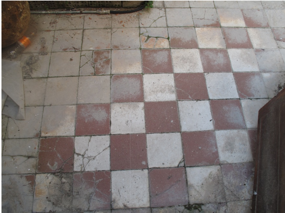
Φωτ. 356. Άποψη του παραλληλόγραμμου χώρου που διαμορφώνεται στο κατώφλι της αυλόθυρας με την επένδυση με τσιμεντοπλακίδια λευκού και κεραμιδί-κόκκινου χρώματος σε διάταξη ζατρικίου.
