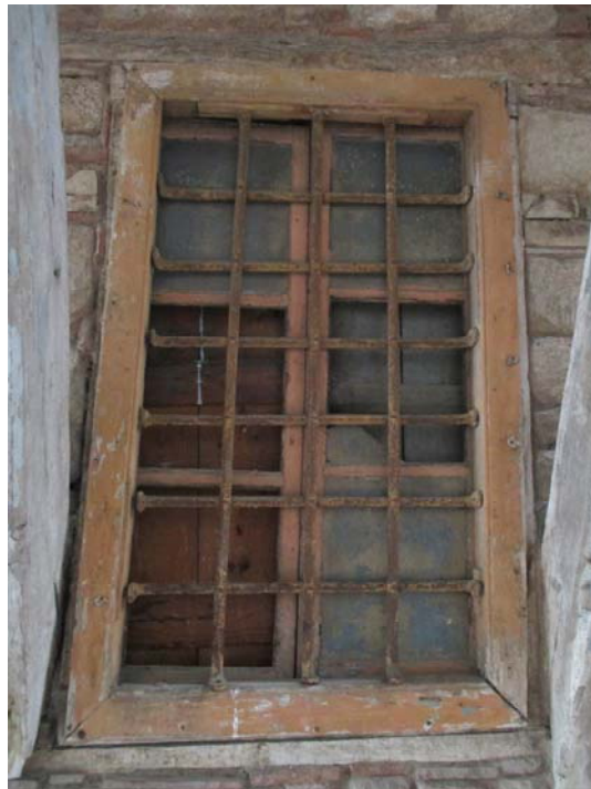
Φωτ. 390-391. Τα μεταλλικά πλέγματα στα παράθυρα του μεσοπατώματος εξωτερικά. Διακρίνονται επικαθίσεις και οξείδωση της μεταλλικής επιφάνειας.
