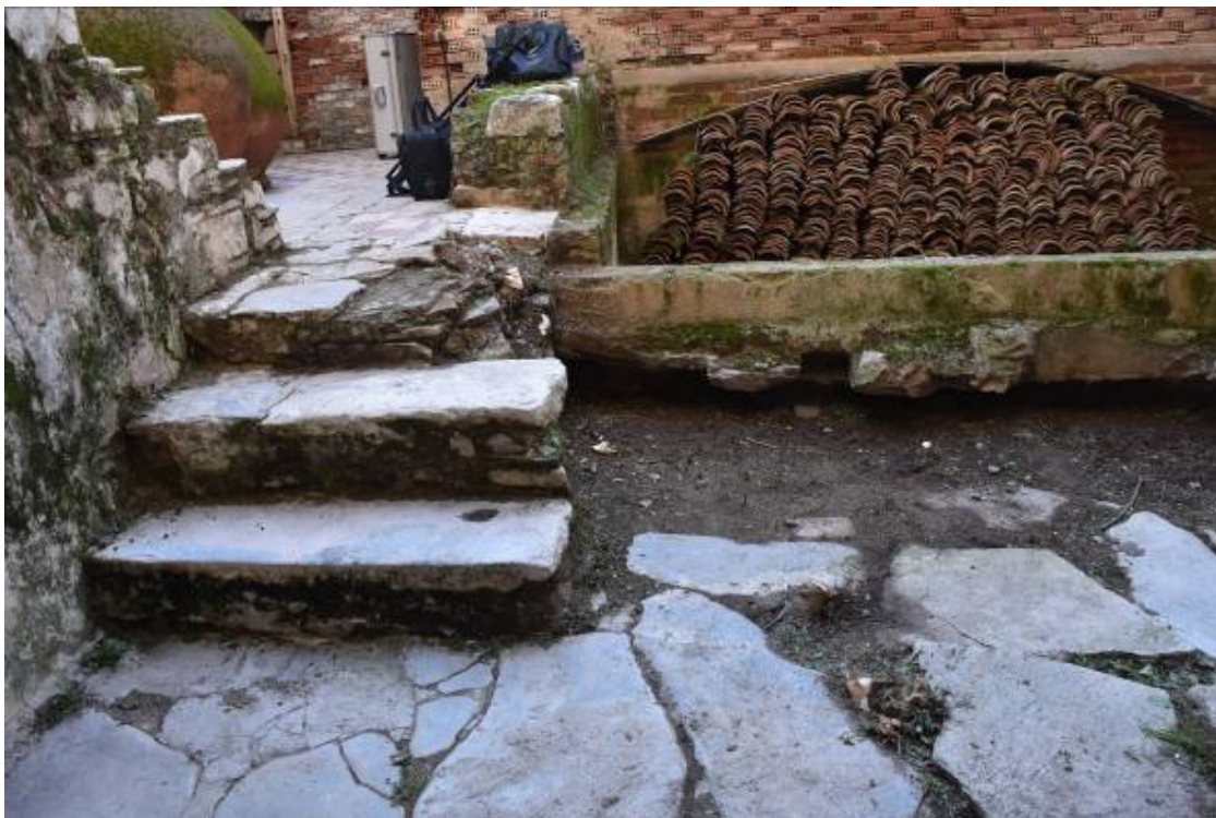
Φωτ. 7 Η πέτρινη σκάλα που οδηγεί από την αυλή στους ημιυπαίθριους χώρους του ισόγειου (ΙΣ0 και ΙΣ1).
