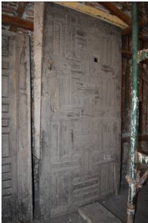
Φωτ. 89 Η θύρα του δυτικού οντά (A6).
