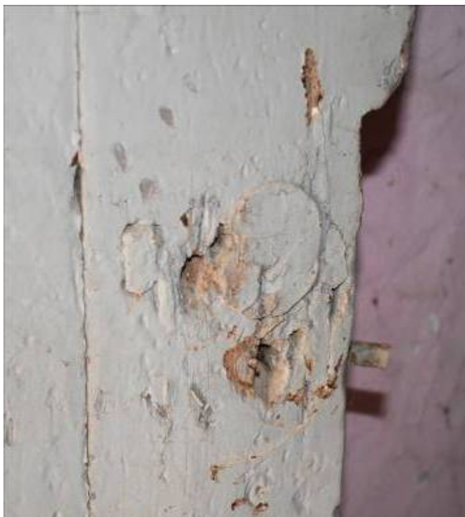
Φωτ. 231 Εκδορές και οπές στην περιοχή των μεταλλικών μηχανισμών των θυρών των χώρων ΗΜ2 και ΗΜ3.
