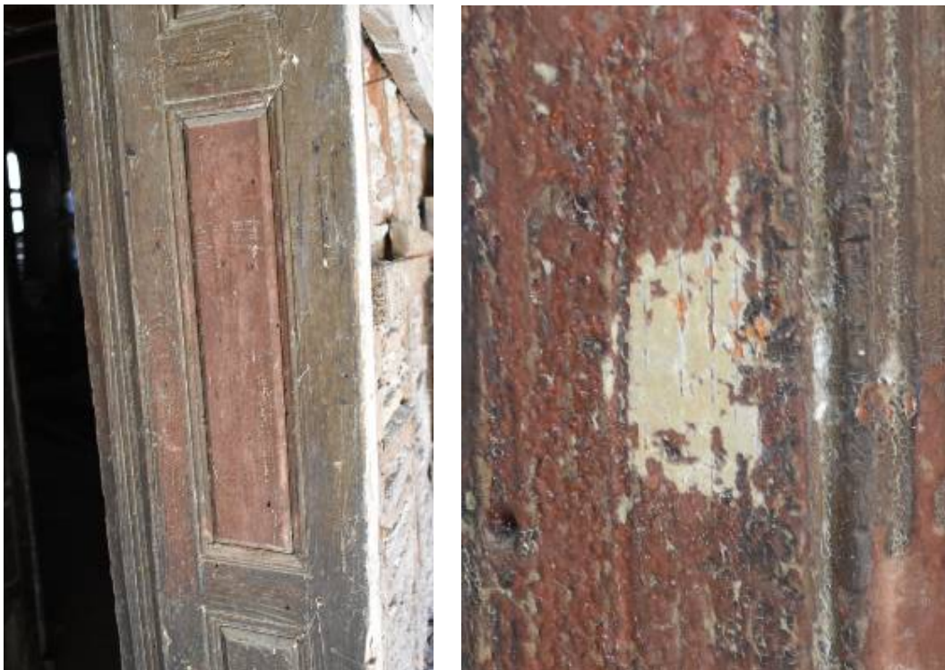
Φωτ. 265 Νεότεροι επιχρωματισμοί καλύπτουν το αρχικό χρωματικό στρώμα της όψης του ανατολικού οντά (Α4). Δεξιά το δείγμα αποκάλυψης του αρχικού χρωματικού στρώματος.
