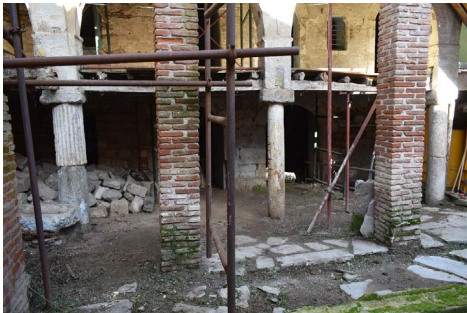
Φωτ. 368. Άποψη της κατασκευής (κολώνες) που ενέχει τις τοξωτές καμάρες του Μεσοπατώματος.
