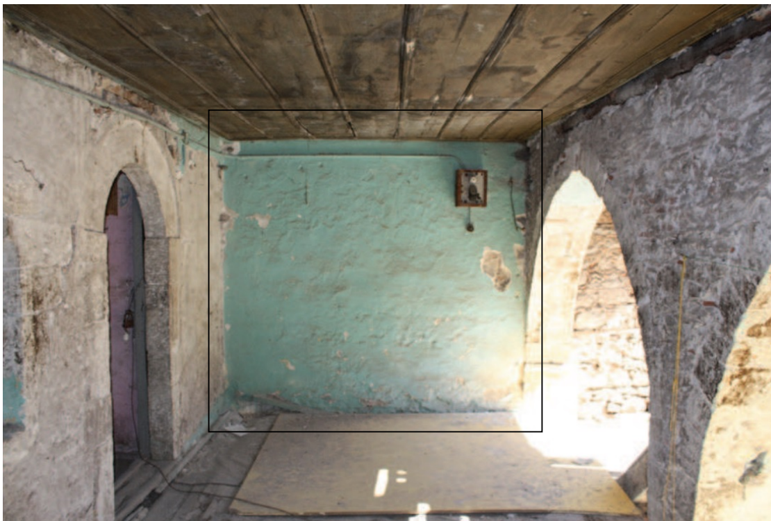
Φωτ. 144 Ο ανατολικός τοίχος του χώρου Ημ1, όπου σώζονται και τα δύο στρώματα του κονιάματος, τα οποία φέρουν νεότερα ασβεστοχρίσματα και επιχρωματισμούς.
