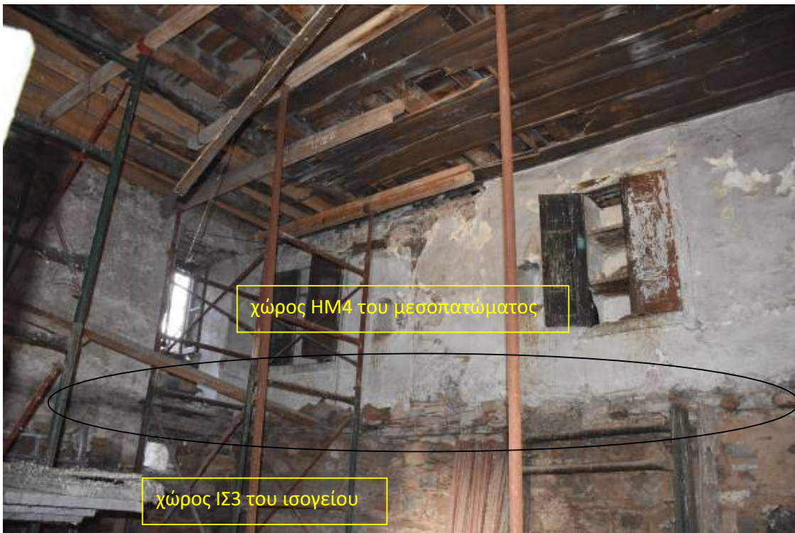
Φωτ. 19 Άποψη του χώρου ΗΜ4 του μεσοπατώματος στον οποίο έχει καταρρεύσει το πάτωμα.
