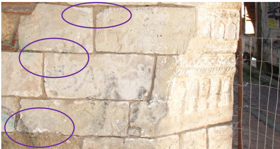
Φωτ. 439. Πλήθος αποφλοιώσεων και επιφανειακών απωλειών των λίθων.
