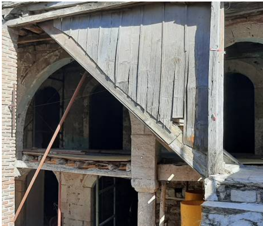
Φωτ. 286 Η νεότερη προσθήκη των κάθετων σανίδων στον εξωτερικό βαθμιδοφόρο της κλίμακας.
