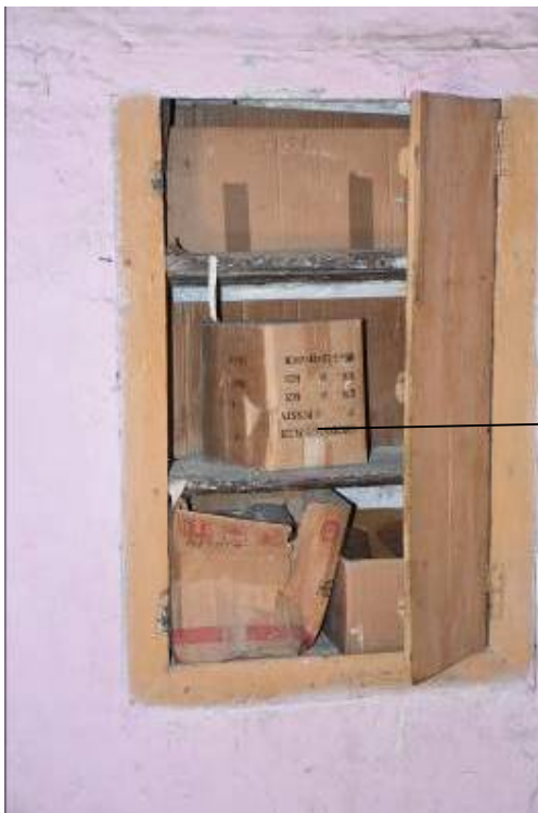
Φωτ. 266 Απώλεια φύλλου ερμαρίου του χώρου ΗΜ2 και η τοποθέτησή του σε παράθυρο.
