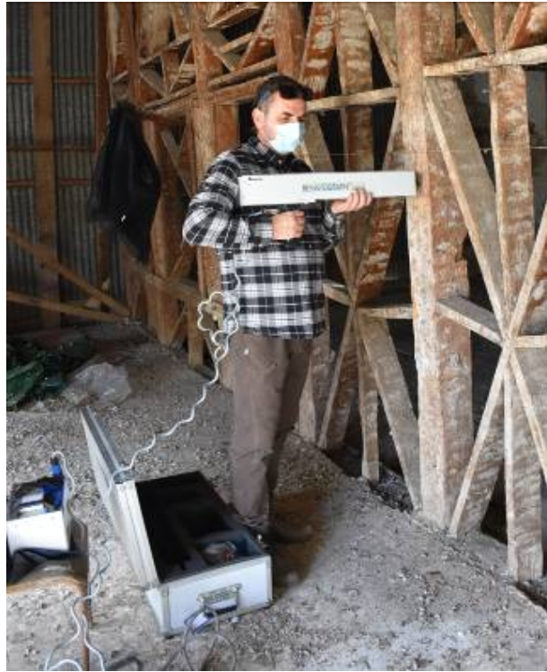
Φωτ. 152 Μέτρηση της πυκνότητας του ξύλου σε ύψος 1,35μ. από το δάπεδο (μπροστινή πλευρά, πάχους 17εκ.).
