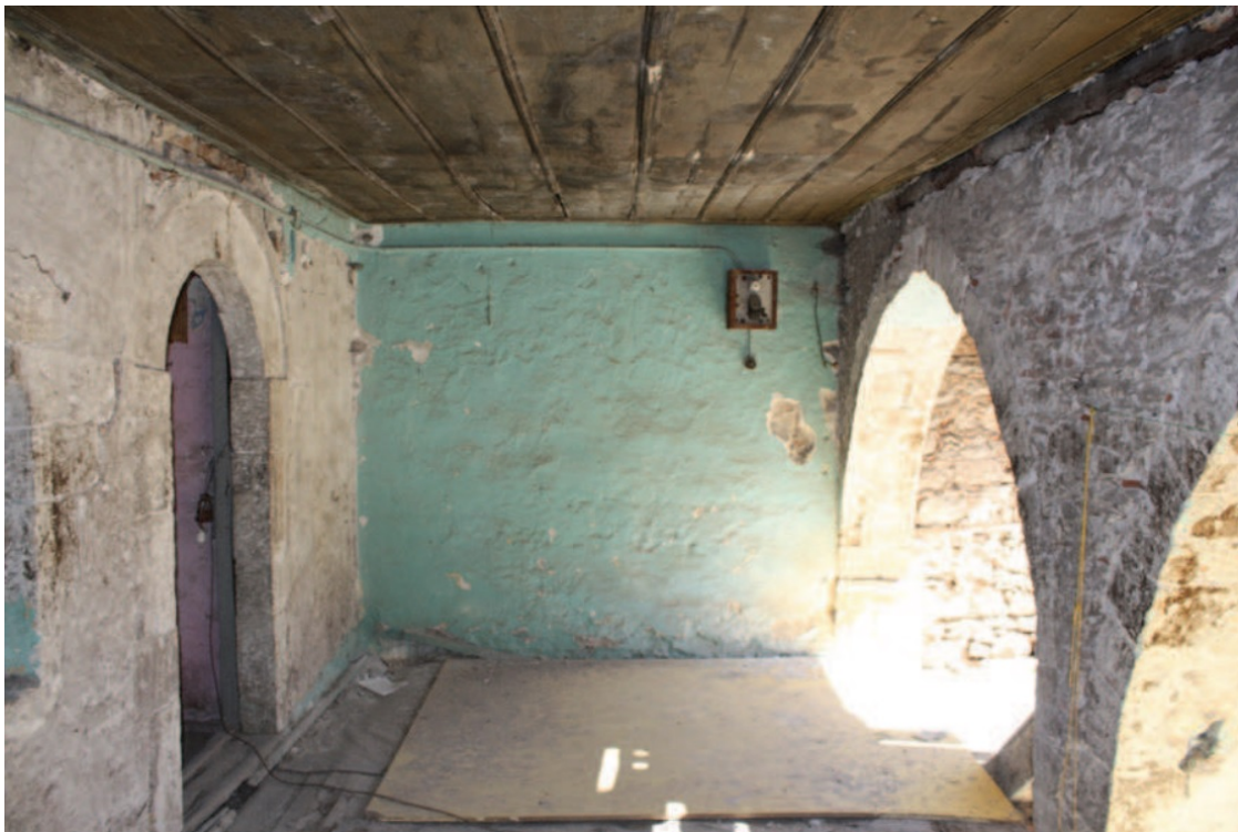
Φωτ. 332 Ο ανατολικός τοίχος του χώρου Ημ1, όπου σώζονται και τα δύο στρώματα του κονιάματος, τα οποία φέρουν νεότερα ασβεστοχρίσματα και επιχρωματισμούς.
