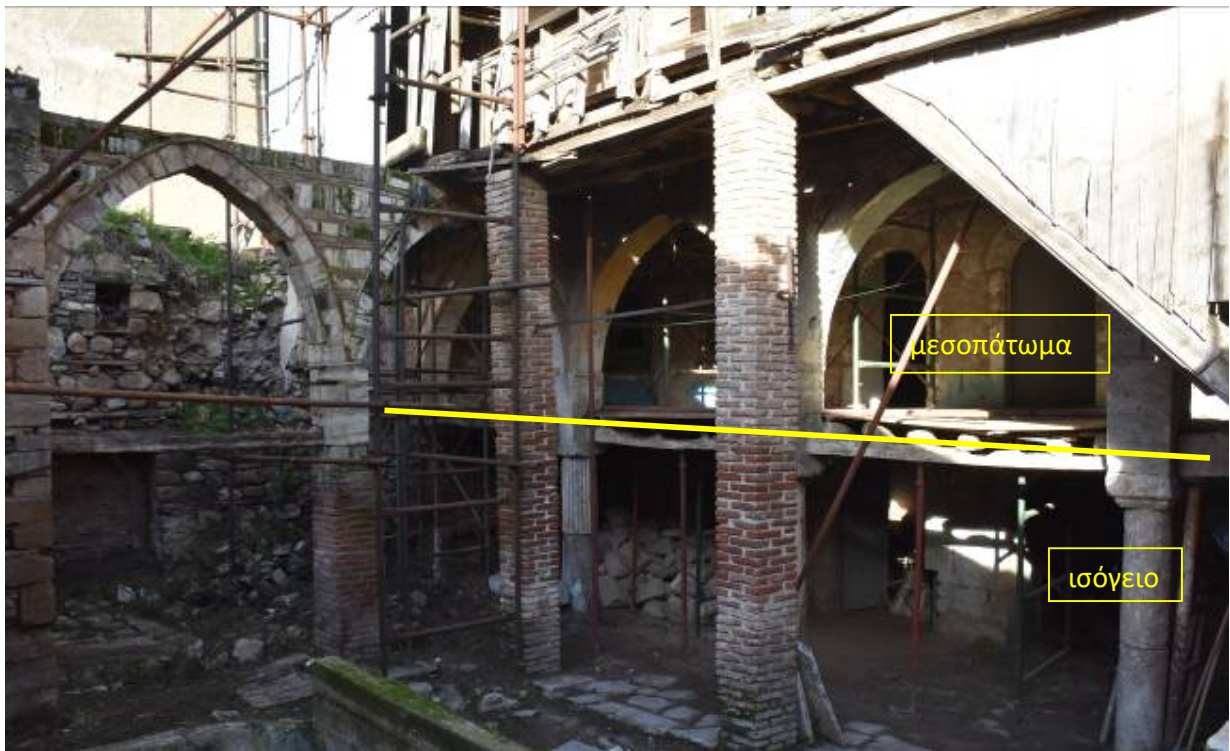
Φωτ. 4 Η ανοικτή στοά, σχήματος Γ, με τα οξυκόρυφα τόξα, που αναπτύσσεται στο επίπεδο του ισογείου και του μεσοπατώματος.
