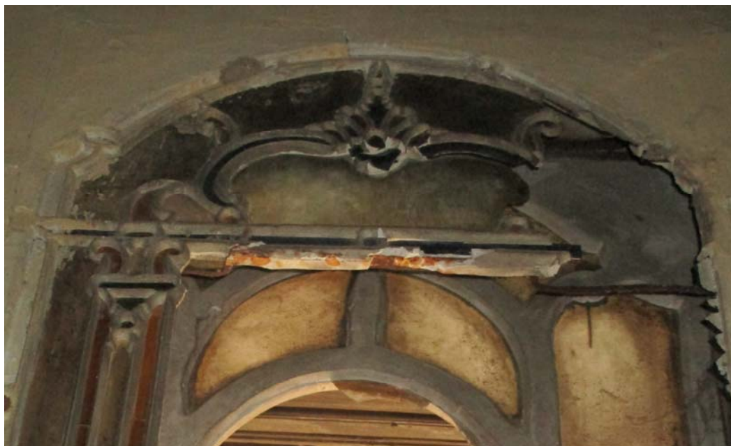
Φωτ. 468. Λεπτομέρεια της κατάστασης διατήρησης του φεγγίτη, σπασμένη υαλώδης επιφάνεια, επικαθίσεις χρώματος, οξειδωμένα μεταλλικά στοιχεία.
