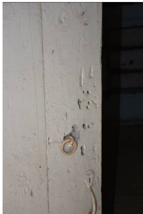
Φωτ. 231 Εκδορές και οπές στην περιοχή των μεταλλικών μηχανισμών των θυρών των χώρων ΗΜ2 και ΗΜ3.
