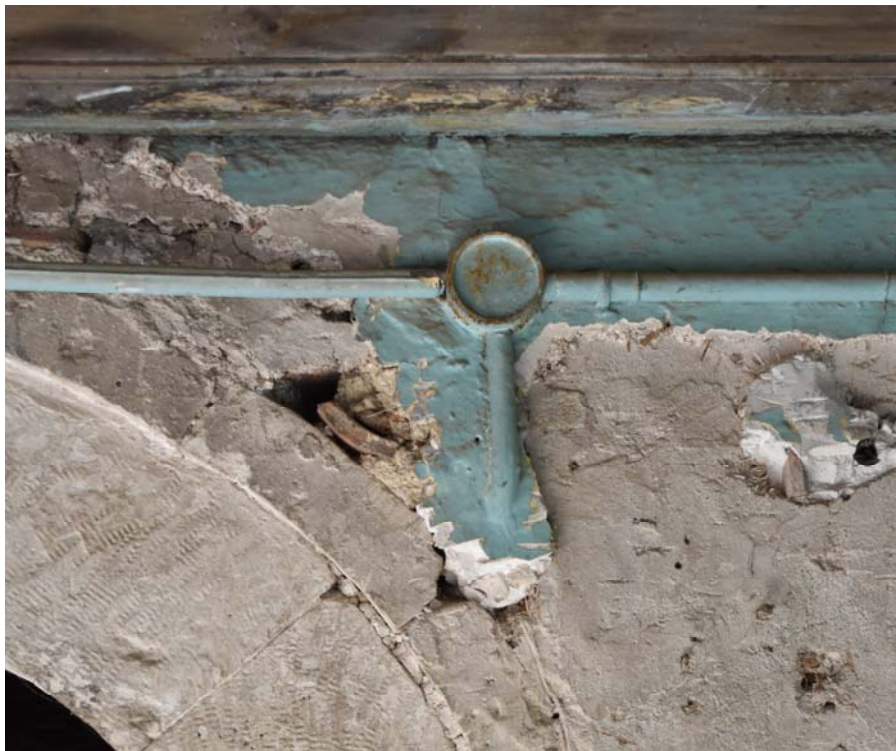
Φωτ. 338 Νεότερο κονίαμα για την πλήρωση των απωλειών του κονιάματος, λόγω της εγκατάστασης καλωδιώσεων ηλεκτροδότησης.
