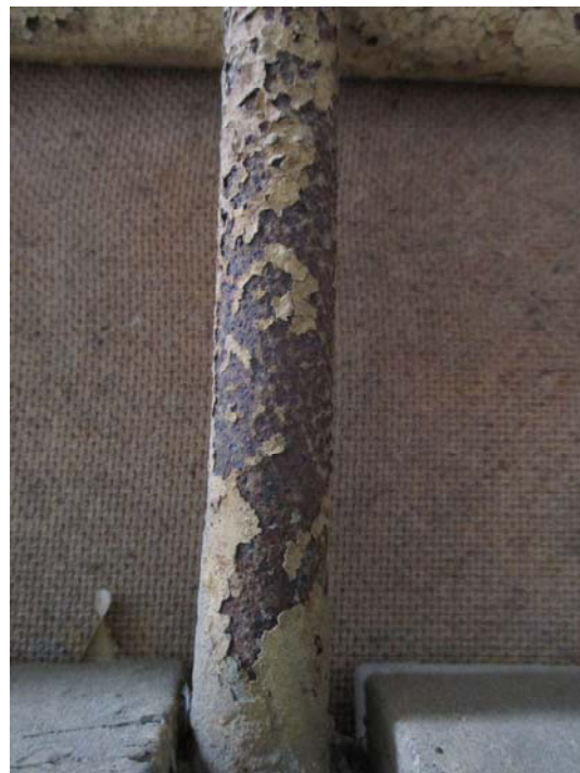
Φωτ. 392-393. Λεπτομέρεια των μεταλλικών στοιχείων στο πλέγμα των παραθύρων. Τα βαμμένα μεταλλικά στοιχεία παρουσιάζουν απώλεια της χρωματικής επιφάνειας λόγω της διόγκωσης των προϊόντων διάβρωσης του σιδήρου.
