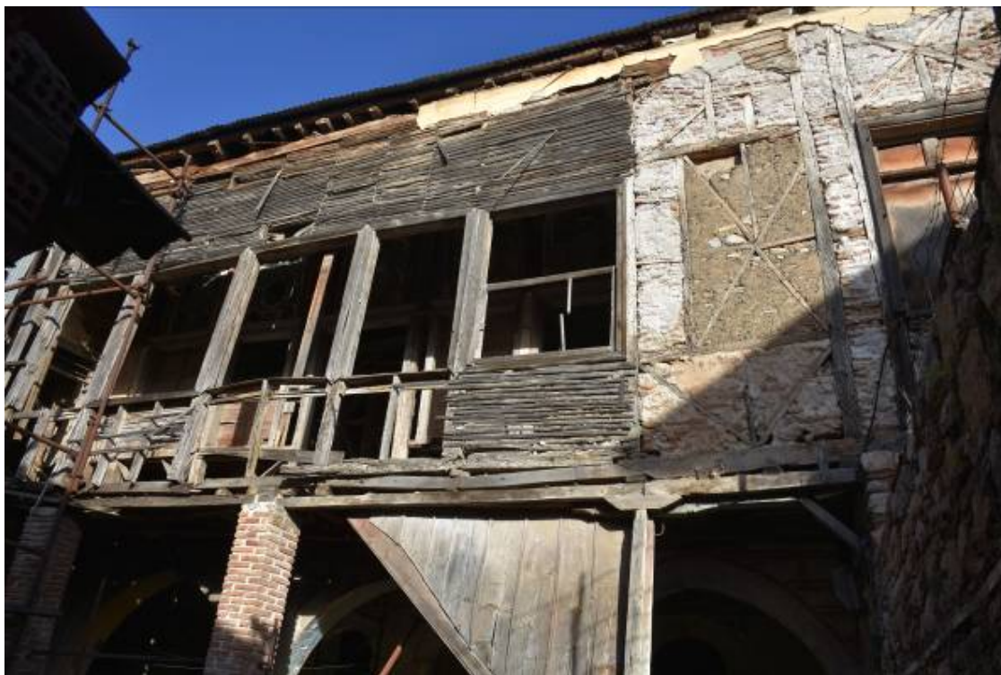
Φωτ. 6 Η όψη του ορόφου.
