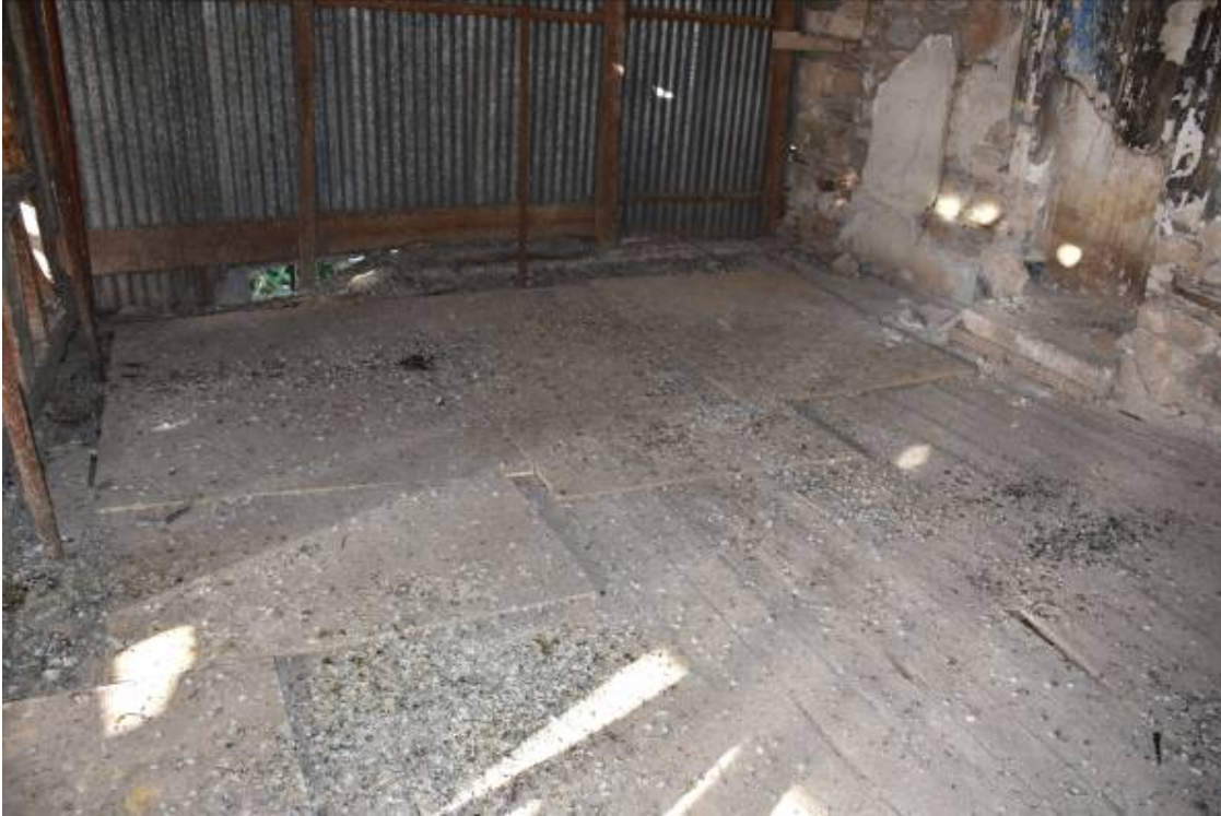
Φωτ. 217 Τοποθέτηση μεγάλων τμημάτων νέου ξύλου (κόντρα πλακέ) στο δυτικό τμήμα του δαπέδου του δυτικού οντά (Α6).
