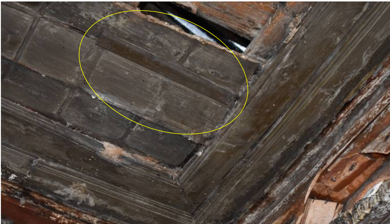
Φωτ. 198 Τοποθέτηση νέου τμήματος ξύλου ως αρμοκάλυπτρο στην οροφή του χαγιατιού (Α2).
