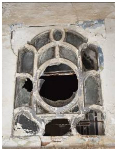
Φωτ. 130 Οι τρεις διπλοί γύψινοι φεγγίτες, όπως φαίνονται από την όψη του ορτά-οντά (A5).
