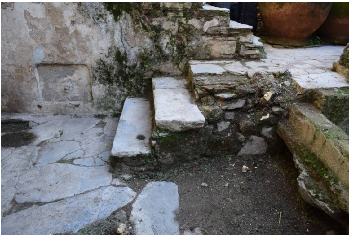
Φωτ. 411. Επίστρωμα και παρουσία φυτών στο μαρμάρινο κλιμακοστάσιο και στις πλάκες του δαπέδου της αυλής.
