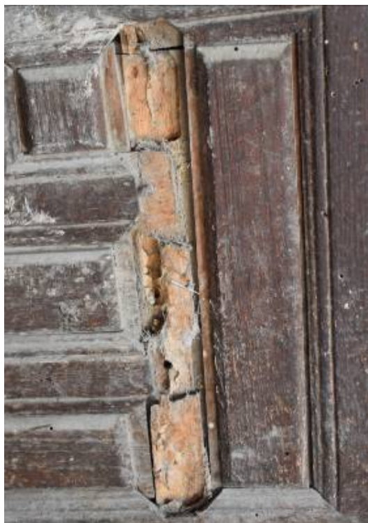
Φωτ. 223 Απώλεια ξύλινου τμήματος από τη δράση ξυλοφάγων εντόμων στη θύρα του ορτά-σοφά (A5).
