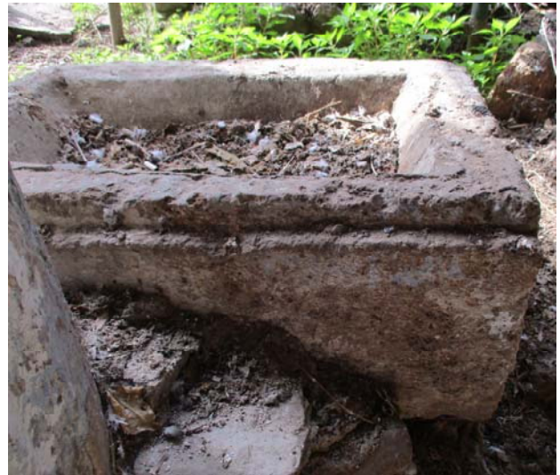
Φωτ. 446-449. Στα λίθινα στοιχεία που έχουν επαναχρησιμοποιηθεί, όπως εδώ στον μαρμάρινο νυπτήρα, παρατηρείται εξαλλοίωση του λίθινου υλικού, με αποτέλεσμα την απώλεια υλικού επιφανείας, την αλλαγή του σχήματος, αλλά και των διαστάσεων των λίθων.
