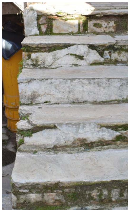
Φωτ. 440-441. Καταπονημένοι και διαβρωμένοι λίθοι σε τοιχοποιία αλλά και στο κλιμακοστάσιο.
