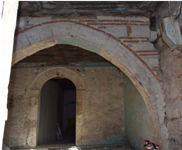
Φωτ. 382. Άποψη του οξυκόρφου τόξου και της καμαρόσχημης εισόδου στο ανατολικό δωμάτιο (βοηθητικός χώρος)
